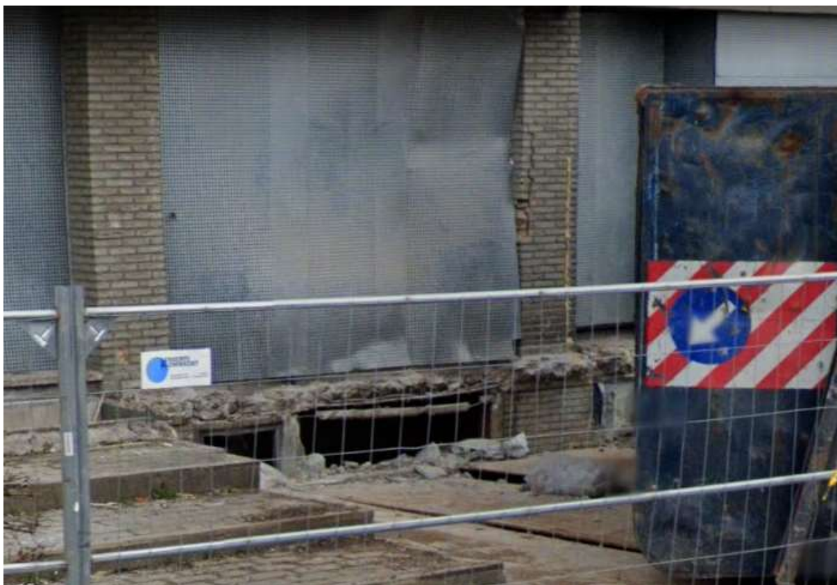
Figuur 4: Detail gebouw open luchtgaten kelderverdieping 5
