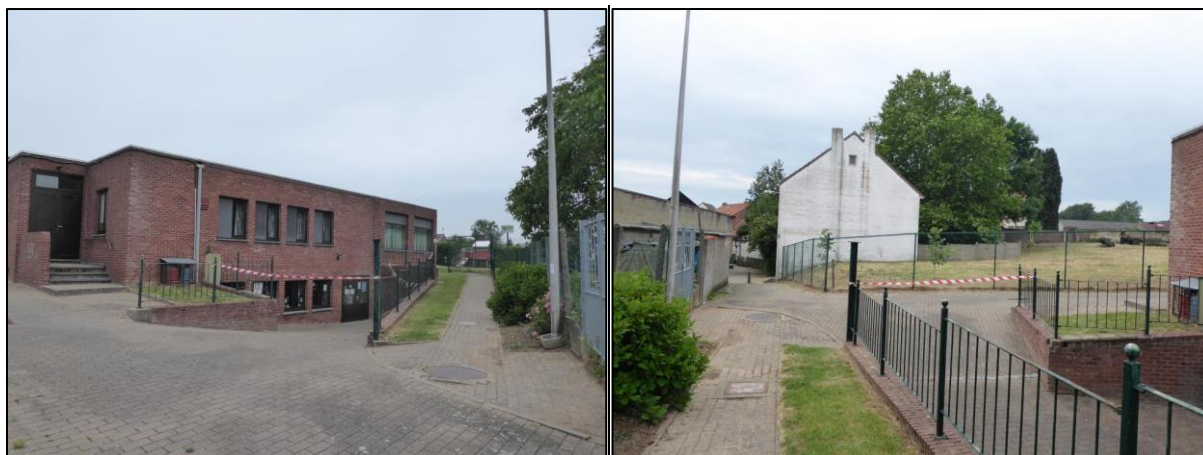
Afb. 10 en 11: De zuidelijke hoek van het projectgebied waar een toegang naar de kelder van het parochiaal centrum is uitgegraven (Bron: Wim Lormans Architect, dd 13/08/2020, 2020/223).
