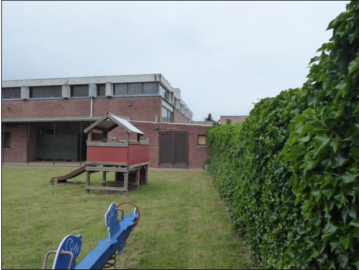
Foto 15: Zicht op de af te breken bergruimtes met links het afdak en vooraan de speelzone, Foto genomen vanuit het zuidoosten.
