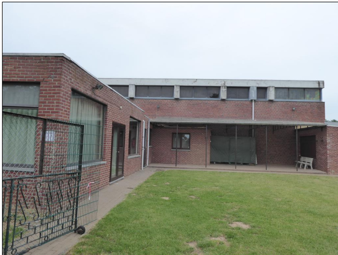
Foto 11: Zicht op het af te breken afdak en de veranda in het zuidoosten van het parochiaal centrum. Foto genomen vanuit het zuidoosten.
