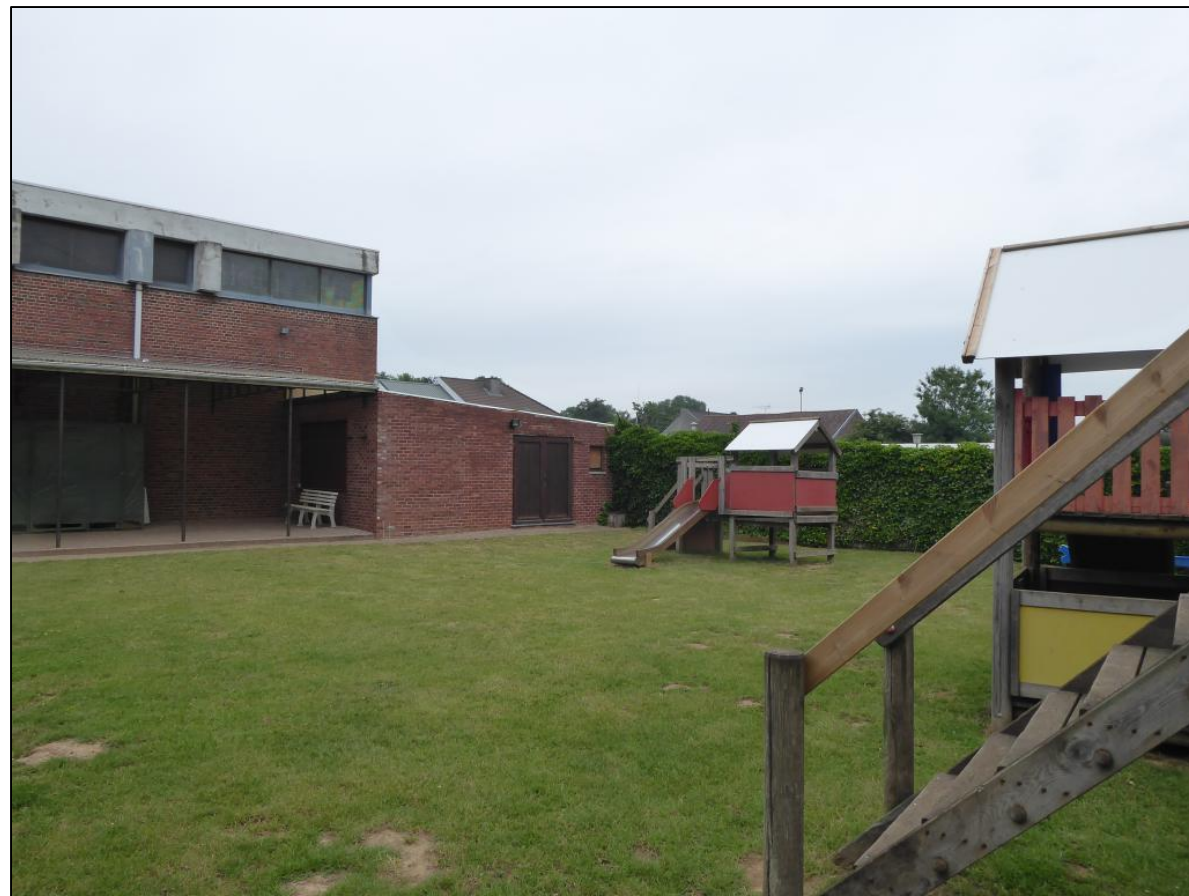
Foto 12 Zicht op de speelzone met achteraan de af te breken bergruimtes en het afdak. Foto genomen vanuit het zuiden.
