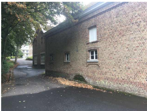
Figuur 9: Foto van een deel van de te slopen bebouwing (dhr. Carl Baert, 2018)
