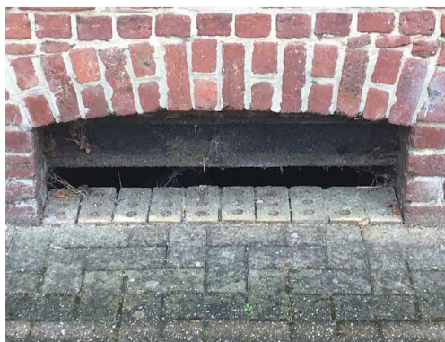
Figuur 10: Detail van de duikerkelder (dhr. Carl Baert, 2018)
