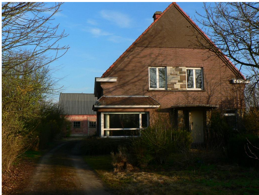
Figuur 4: foto bestaande toestand perceel 679m: huis langs straatkant (buiten de vergunning) met oprit en op de achtergrond stalling in een 19 de eeuwse hoevevleugel.
