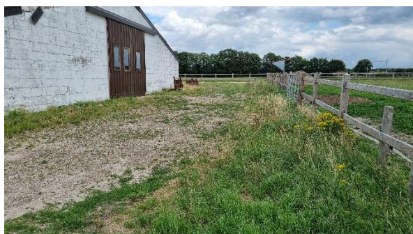
De oprit ten zuiden van de westelijke, lange stal - (grof grind en bouwpuin)
