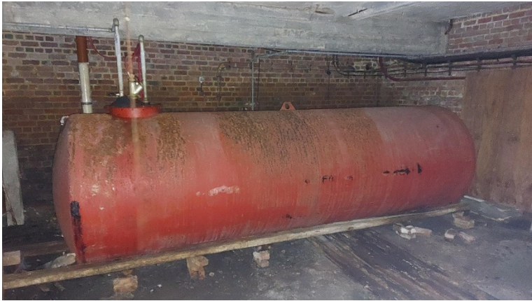
Figuur 8. Aanduiding van de kelders. Onder: zicht op één van de tanks in de kelder.
