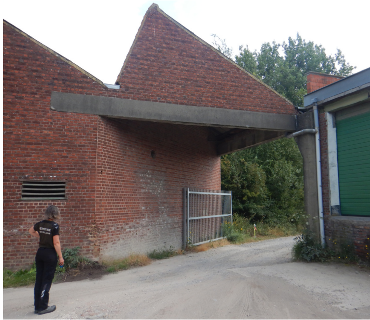
Figuur 9. Zicht op de overkapping aan de zuidelijke "hoek" van de weverij.
