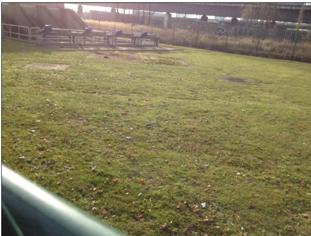
Afb. 7. Bestaande toegangskamers: voorbeeld 1.
