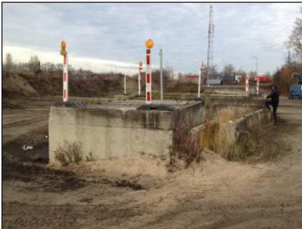
Afb. 10. Bestaande toegangskamers: voorbeeld 4.
