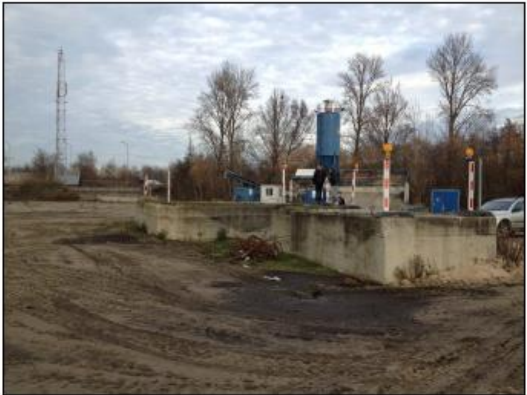
Afb. 11. Bestaande toegangskamers: voorbeeld 5.
