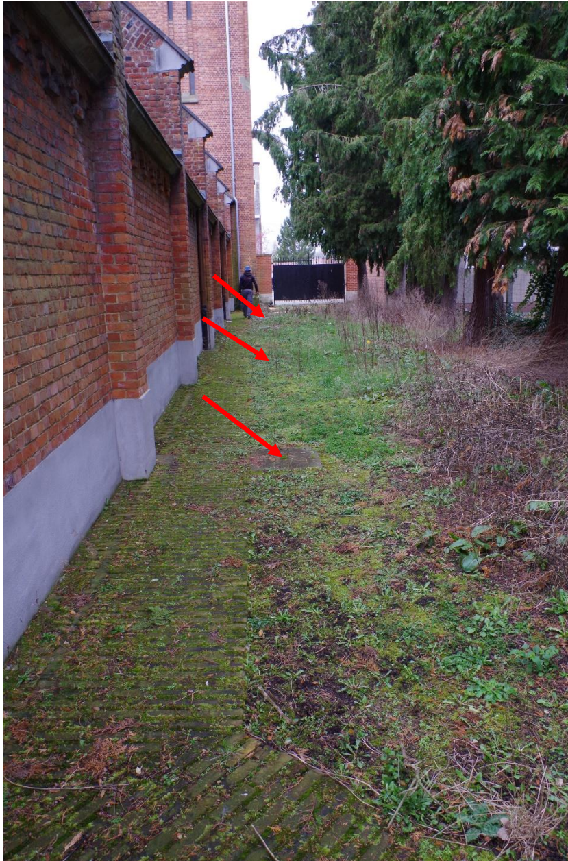
Foto 5. Zicht op de noordelijke zijde van de kerk met gangpad en aanduiding van de afvoerputjes van de riolering langs de kerk. Rechts zijn de te rooien bomen voorzien (bron: SOLVA).
