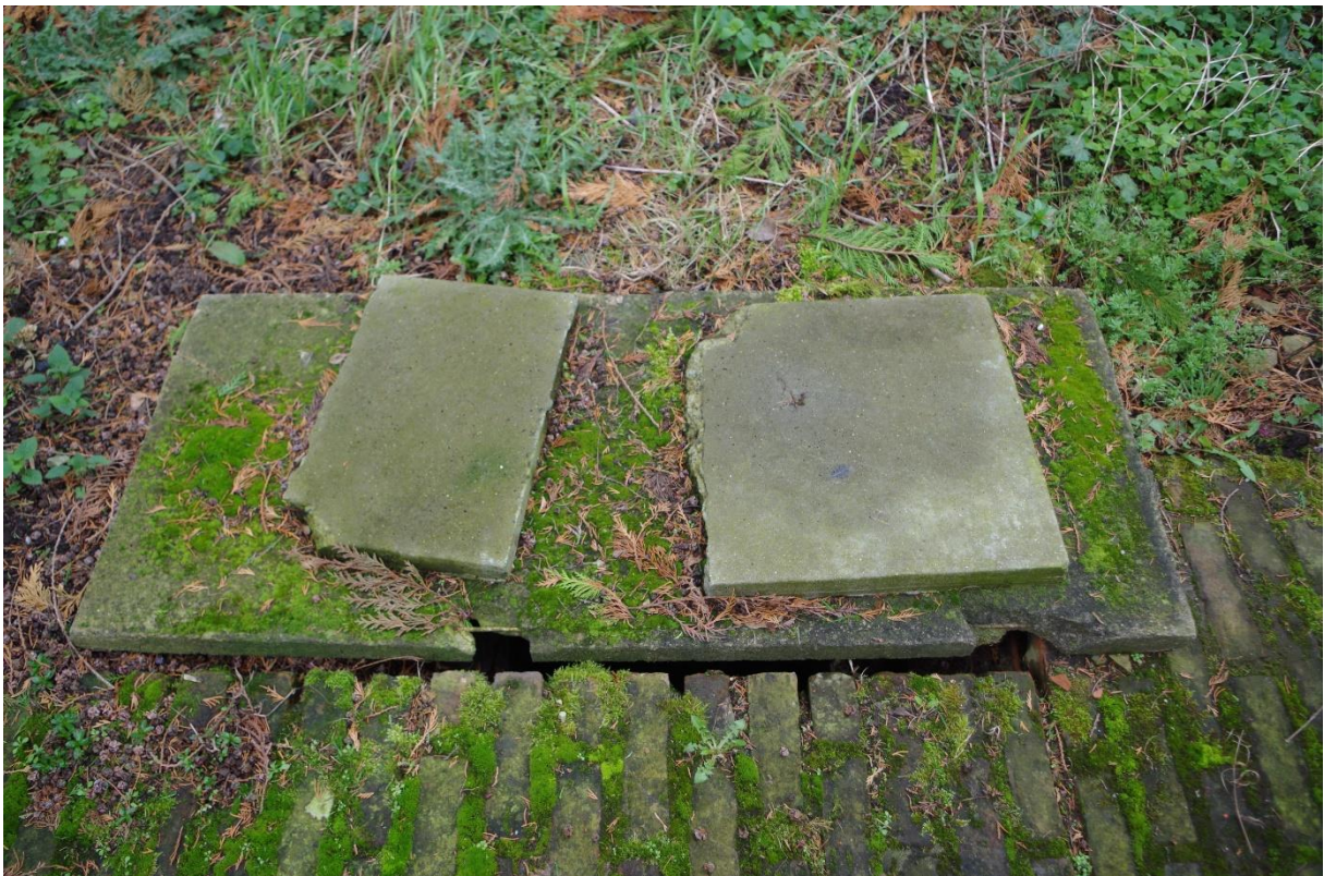
Foto 7. Deksel op een van de afwateringsputjes (bron: SOLVA).
