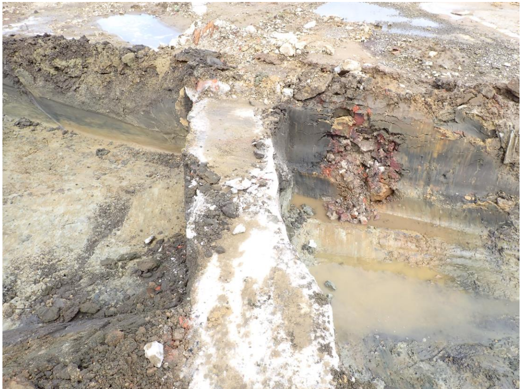
Afb. 19. Voorbeeld van een van de betonnen funderingen van het terras van het huis.
