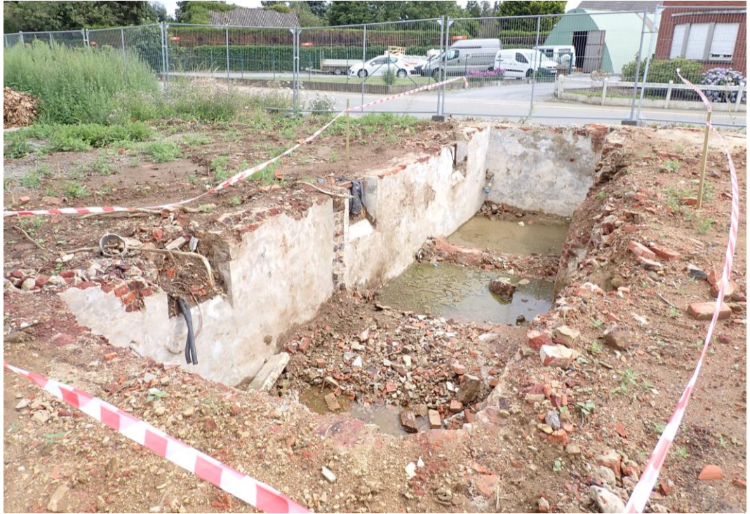
Afb. 5. Zicht op de oostelijke kelder.
