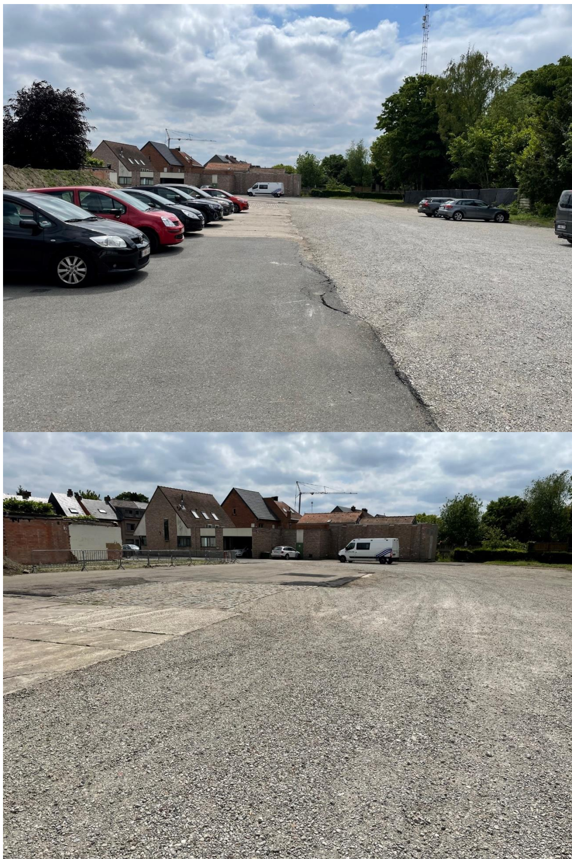
Figuur 8: Zicht op de tijdelijk ingerichte parking
