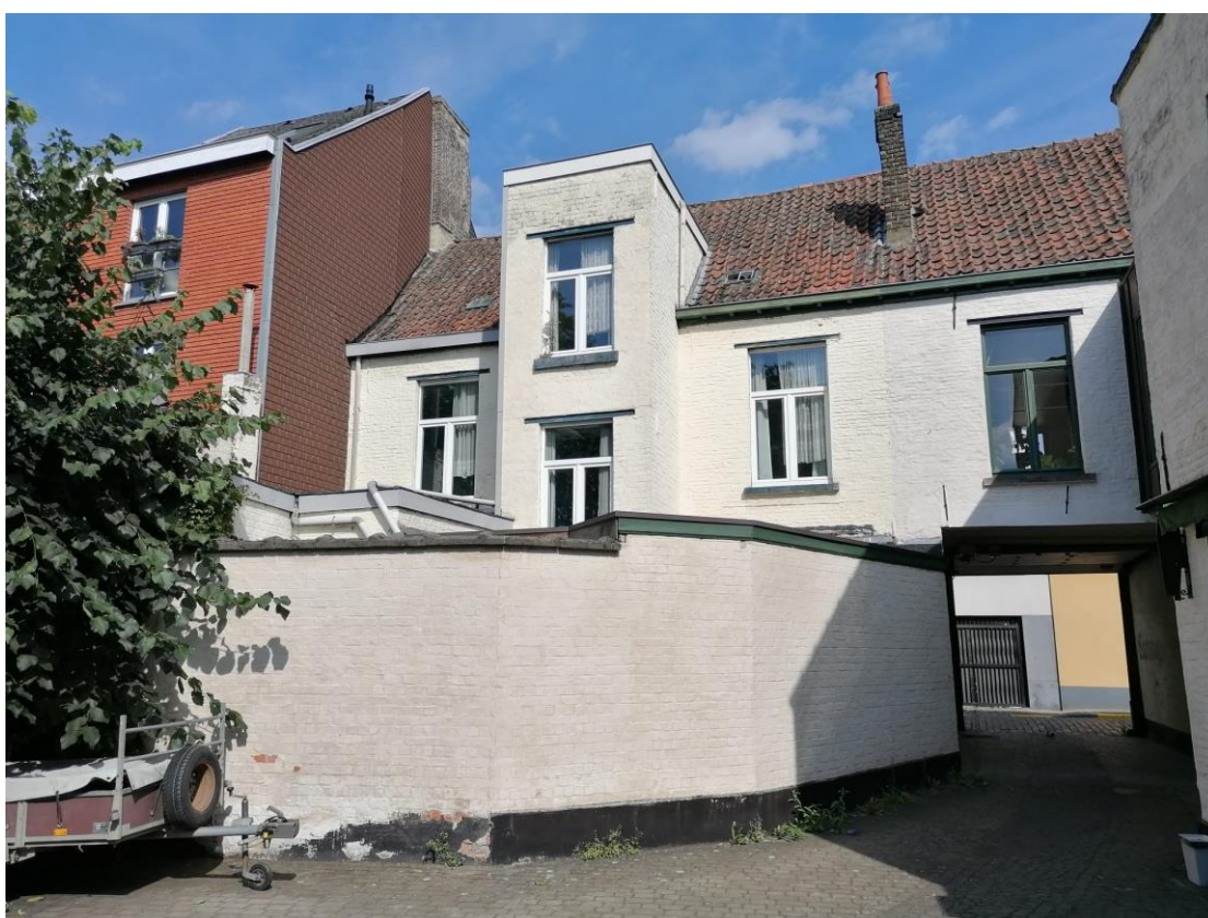
Figuur 2: Achtergevel bestaande bebouwing, met zicht op de aanbouwen en tuinmuur (©BAAC Vlaanderen 2023).
