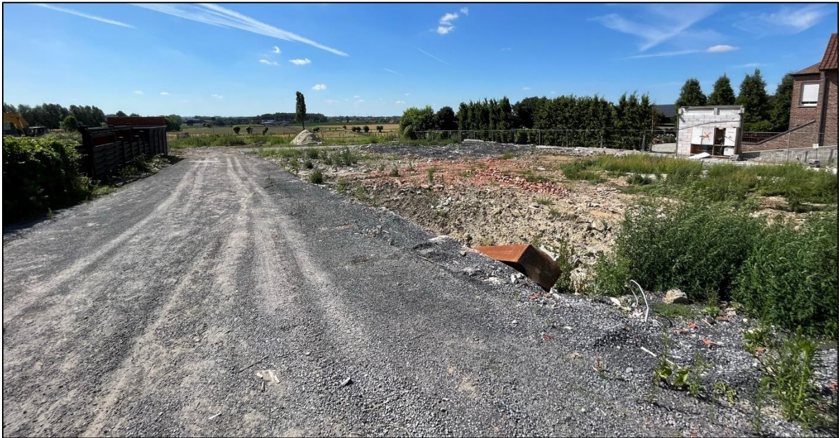
Figuur 2: De werfweg (links) en gesloopte bebouwing aan de straatzijde (rechts). Gefotografeerd in zuidelijke richting.
