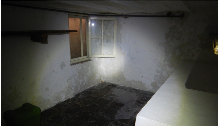
Figuur 8. Zicht op de kelder.
