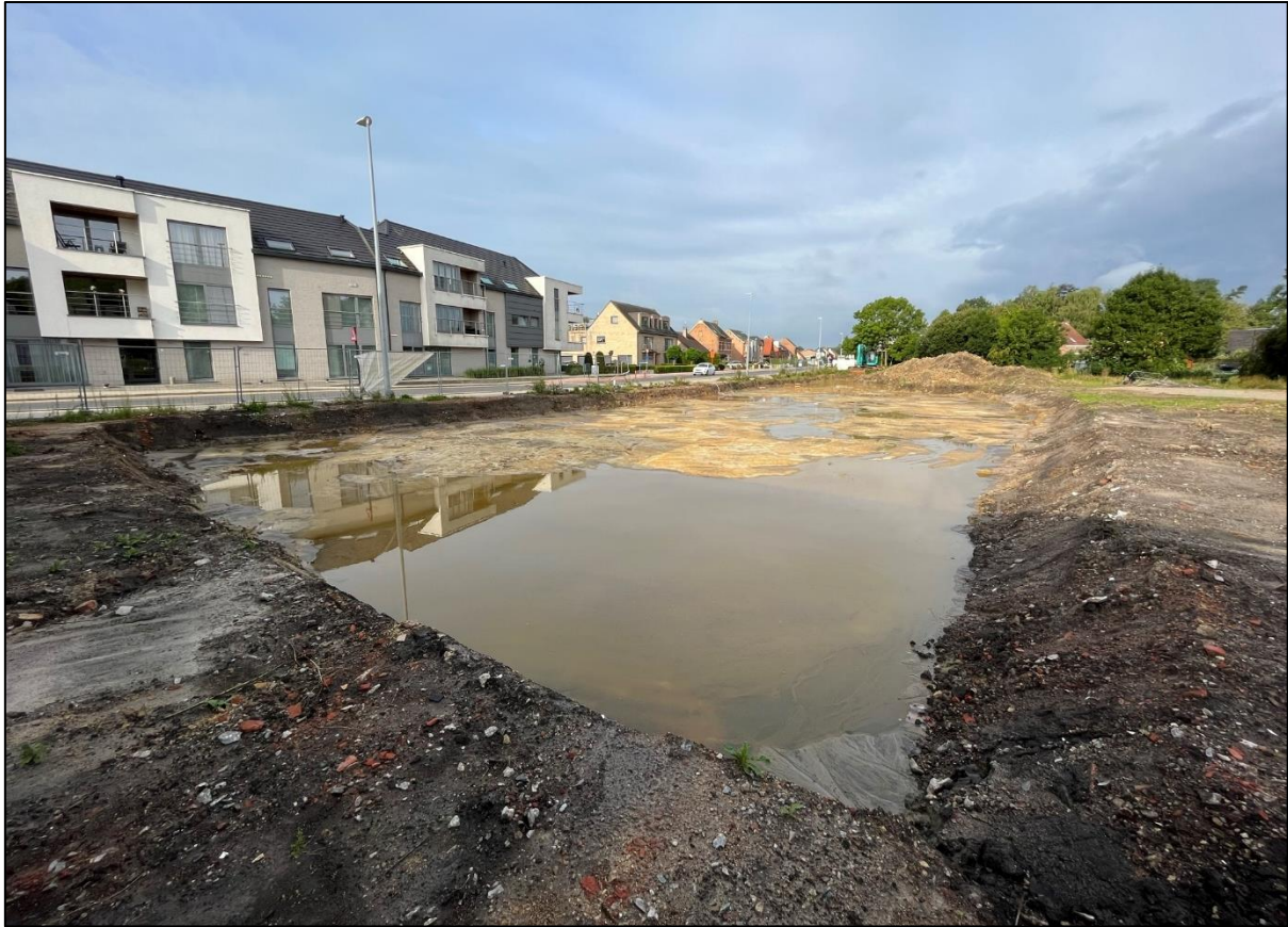
Figuur 10: De uitgraving van 1.170 m 2 tot 3,00 m-Mv op het onderzoeksgebied. Ten tijde van de foto was de put terug opgevuld tot ca. 1,00 m-Mv. Gefotografeerd in zuidwestelijke richting.
