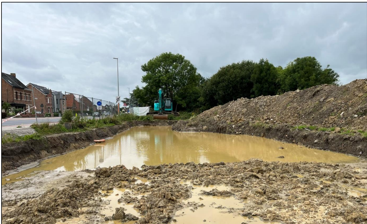
Figuur 16: De locatie van boring 2 (niet uitgevoerd). Gefotografeerd in westelijke richting.
