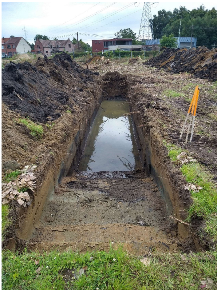
Figuur 8d. Zicht op werkput 2 die is ondergelopen alsook de boomstronken waardoor deze werkput is onderbroken. ©LARES
