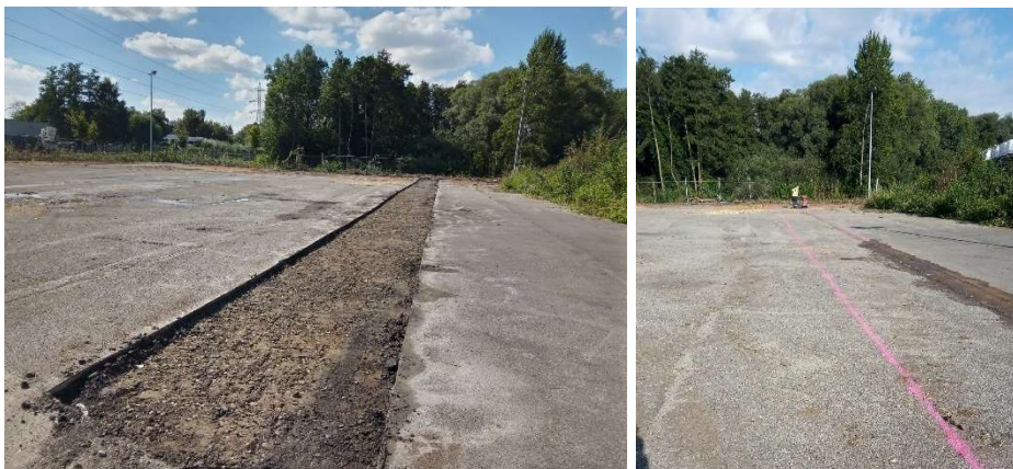
Figuur 5. Overzichtsfoto's van de sloopbegeleiding. ©LARES
