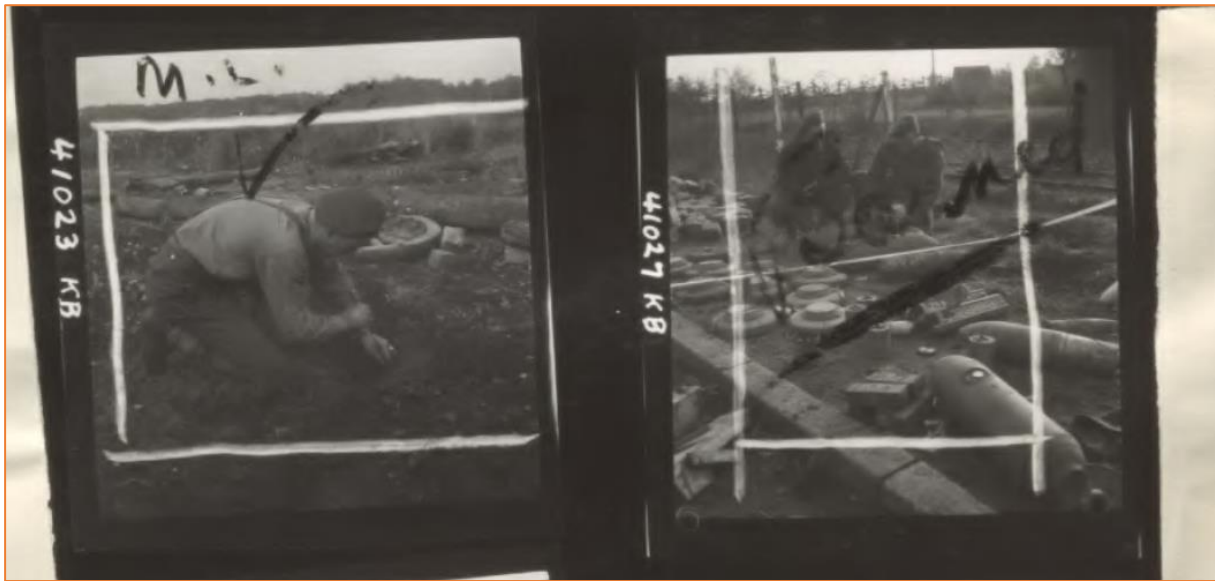
Figuur 17. Ontmijning van wegversperringen nabij Kapellen. Vergelijkbare wegversperringen werden aangelegd nabij Brasschaat ( Library and Archives Canada ).
