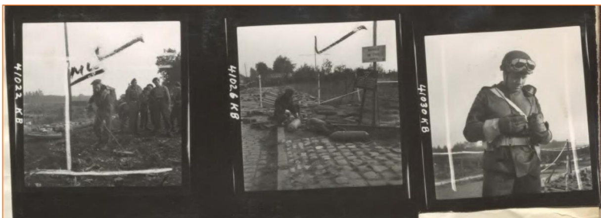
Figuur 16. Ontmijning van wegversperringen nabij Kapellen. Vergelijkbare wegversperringen werden aangelegd nabij Brasschaat ( Library and Archives Canada ).
