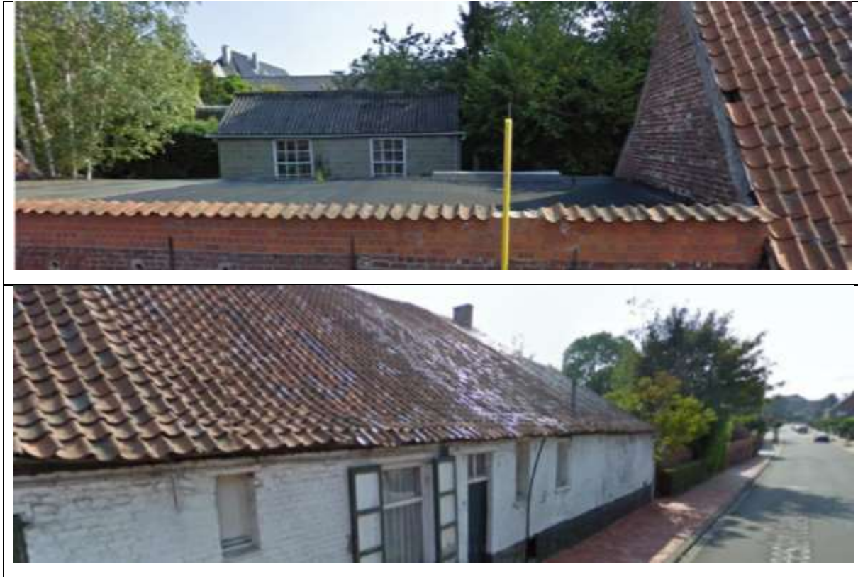
Figuur 4: Overzichtsfoto van de bestaande toestand van op de Burgemeester Callewaertlaan aan de noordwestelijke zijde (boven) en de voormalige arbeidershuisjes in het noordwesten van het terrein (onder) (bron: Google Street view 2009).
