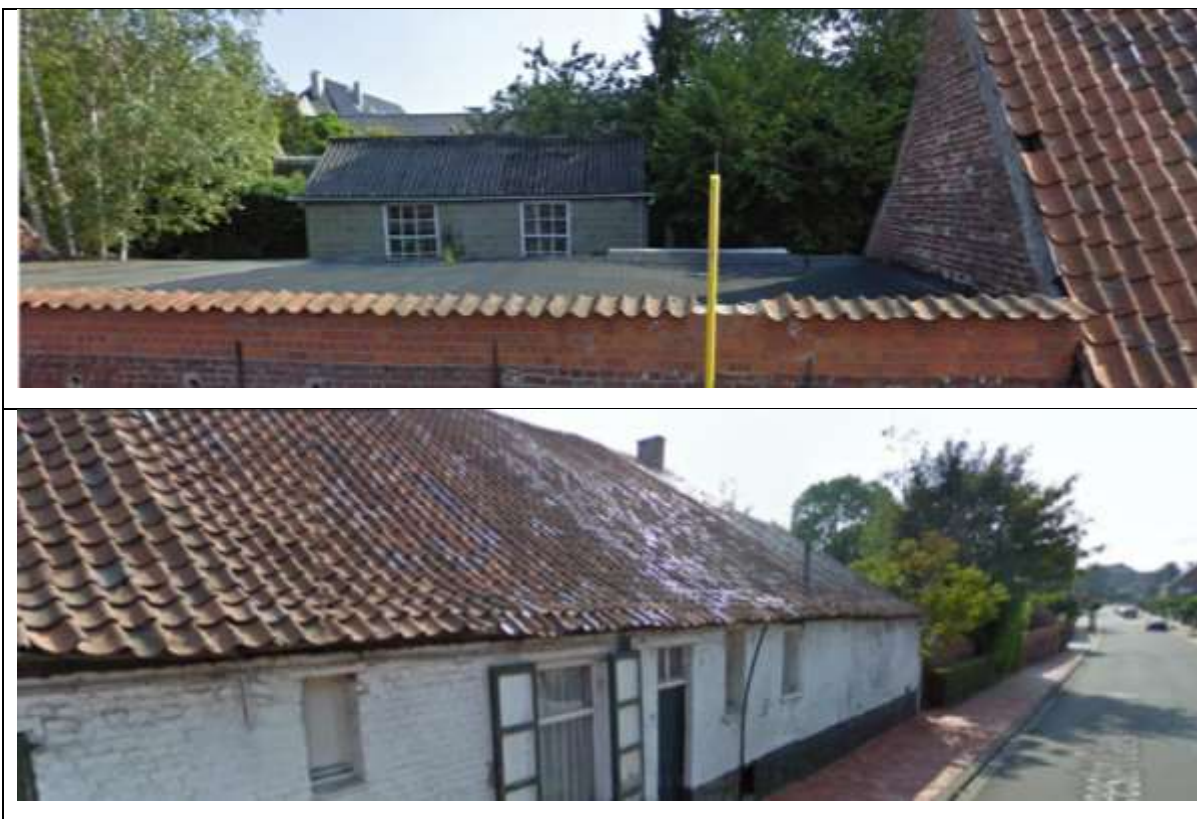
Figuur 4: Overzichtsfoto van de bestaande toestand van op de Burgemeester Callewaertlaan aan de noordwestelijke zijde (boven) en de voormalige arbeidershuisjes in het noordwesten van het terrein (onder) (bron: Google Street view 2009).
