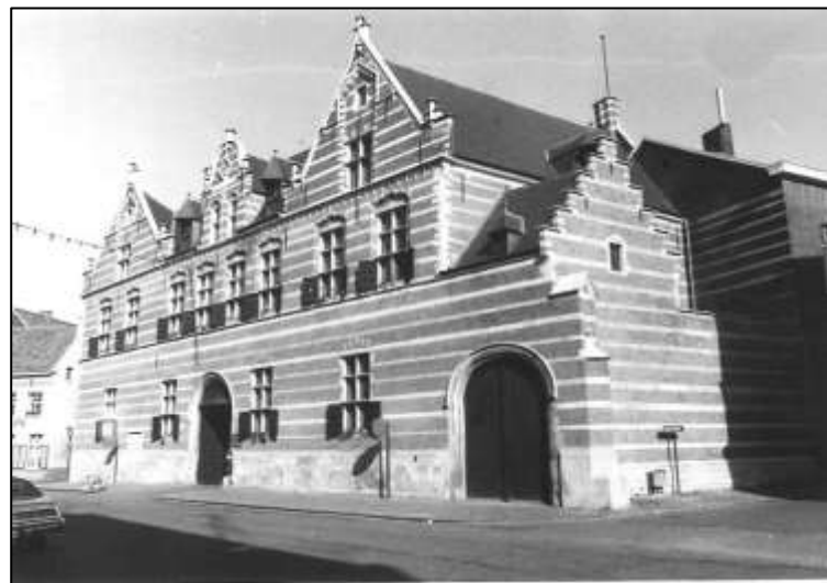
Figuur 28: Het Refugehuis in 1975, zichten op buitengevels en binnenkoer (bron: Agentschap Onroerend Erfgoed 2016)
