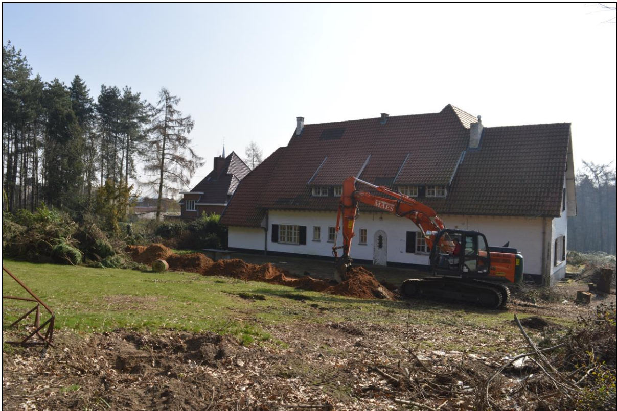
Afb. 9: Aanleg SL4 (bron: ARON bvba, dd 16/03/2017, 2017C222)
