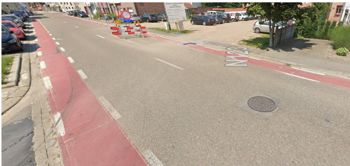
Figuur 2: Zicht op de Retiesebaan met de putdeksel midden in de straat (© Google Streetview dec. 2009)
