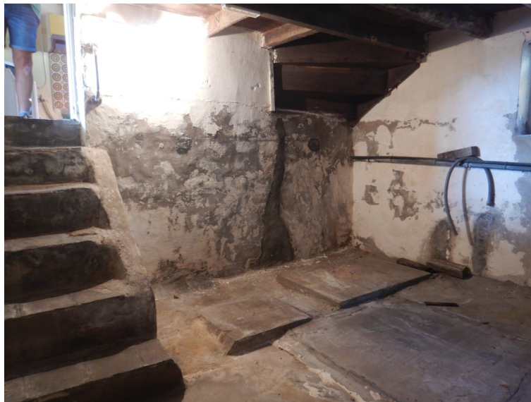
Figuur 7. De hoeve en bijgebouwen. Onder: de aardappelkelder onder het woonhuis.
