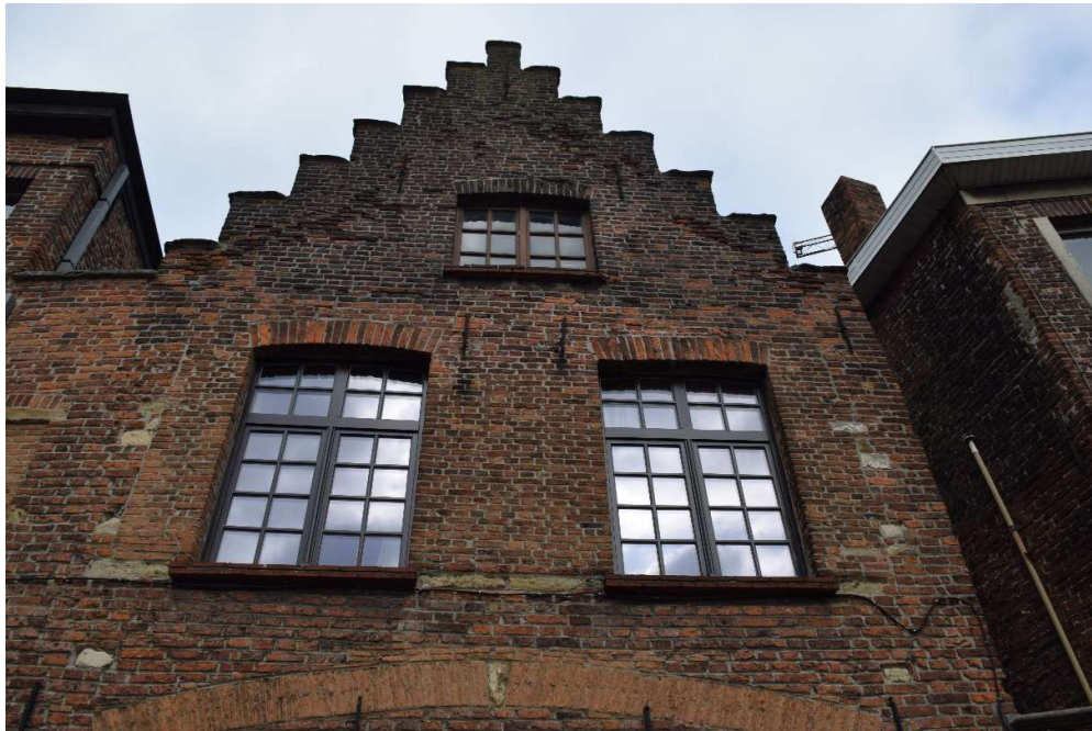
Afb. 492 M15e: detail van de tweede bouwlaag en geveltop
