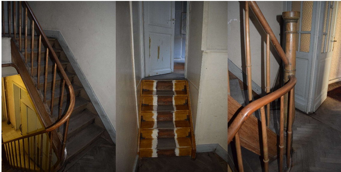
Afb. 470 Ruimte M15a_R1.07: detail van de 19 de -eeuwse trap
