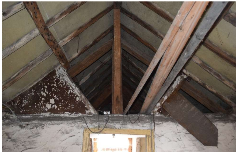
Afb. 219 Ruimte M5_R2.02: detail van de dakconstructie boven ruimte M5_R2.01
