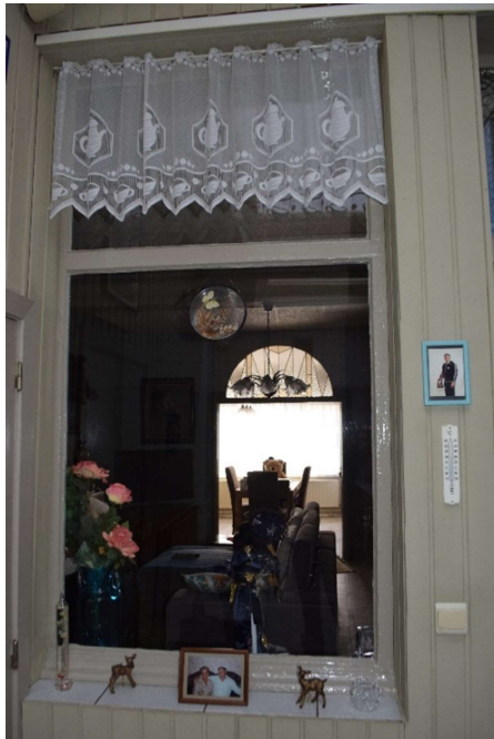
Afb. 174 Ruimte M5_R0.04: vast houten raam in de achtergevel
