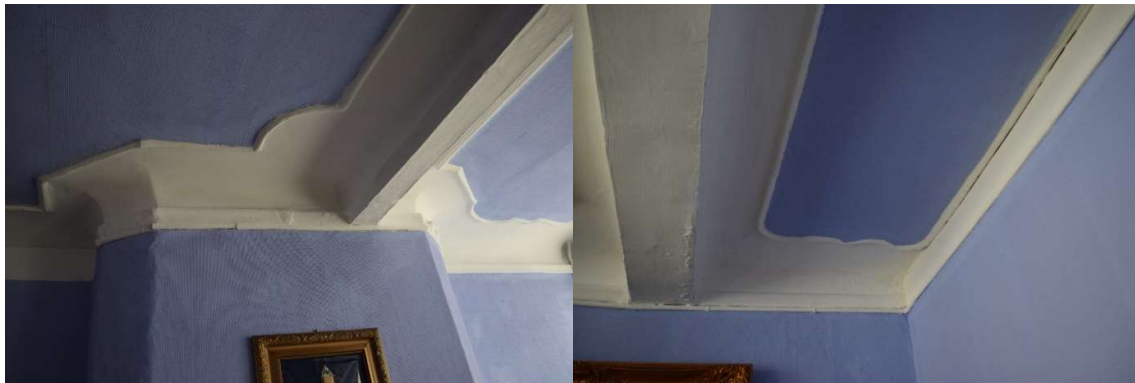
Afb. 186 Ruimte M5_R1.01: detail van het 18 de -eeuws stucwerkplafond met geprofileerd lijstwerk
