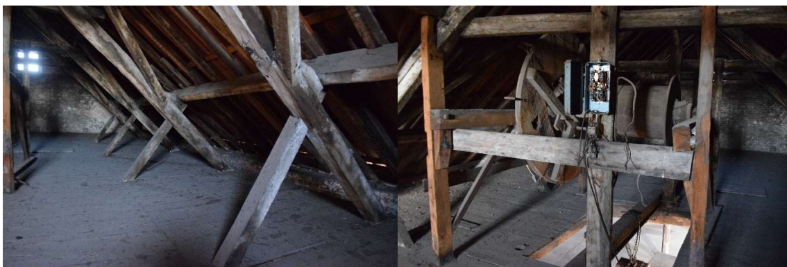
Afb. 619 M15h_R4.01: detail van de dakconstructie
