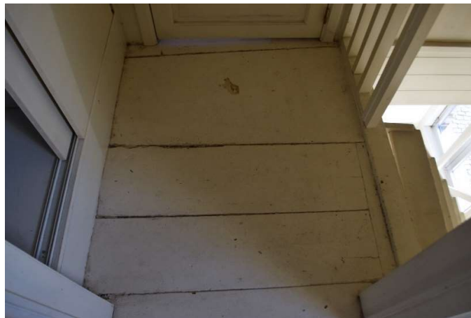
Afb. 59 Ruimte M1_R2.02: brede plankenvloer
