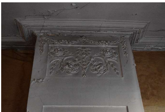
Afb. 432 Ruimte M15a_R1.01: detail van het bepleisterd schouwlichaam
