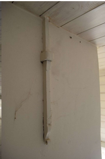
Afb. 63 Ruimte M1_R2.03: detail van het muurankers op het schouwlichaam
