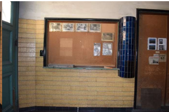
Afb. 383 Ruimte M15a_RO.01: dichtgemaakt loket naar ruimte 0.04
