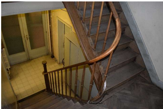
Afb. 468 Ruimte M15a_R1.07: detail van de 19 de -eeuwse trap
