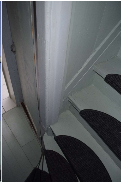
Afb. 200 Ruimte M5_R1.04: detail van de 18 de -eeuwse trap
