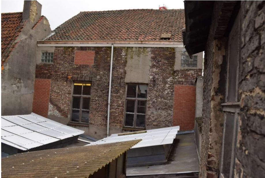
Afb. 278 M15 (11-13): algemeen zicht op de achtergevel van beide panden
