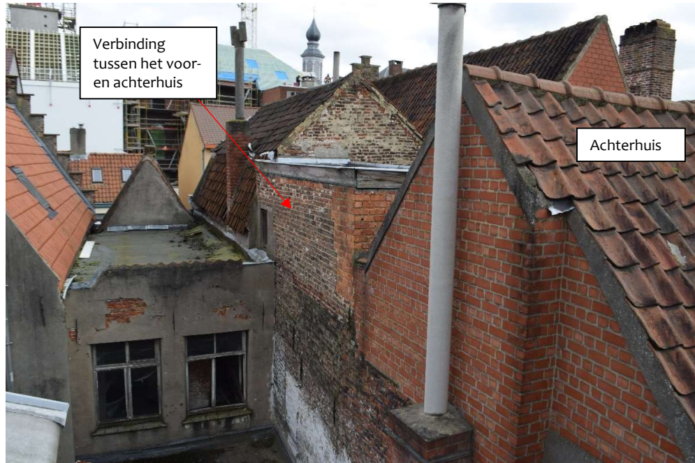
Afb. 153 M5: algemeen zicht op de zijgevel
