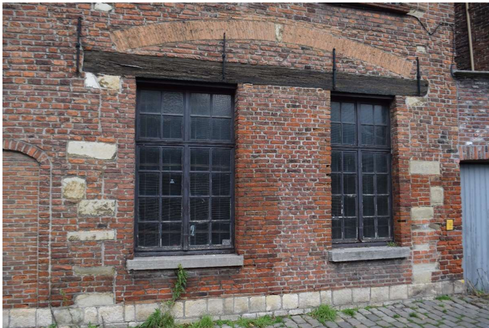
Afb. 493 M15e: detail van de eerste bouwlaag
