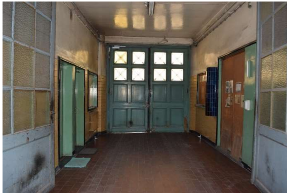
Afb. 380 Ruimte M15a_RO.01: algemeen zicht naar de voorgevel
