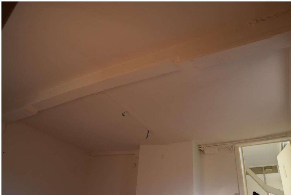
Afb. 39 Ruimte M1_R1.03: algemeen zicht op de 15 de -eeuwse balkenzoldering
