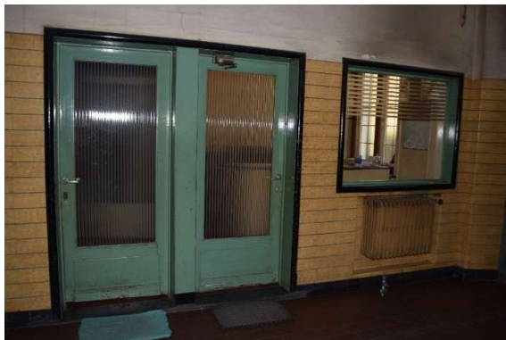
Afb. 384 Ruimte M15a_RO.01: zicht op de doorgangen naar 0.02 en 0.03
