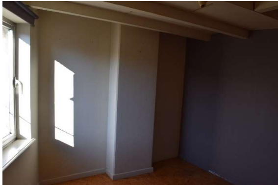
Afb. 67 Ruimte M1_R2.04: bepleisterd schouwlichaam
