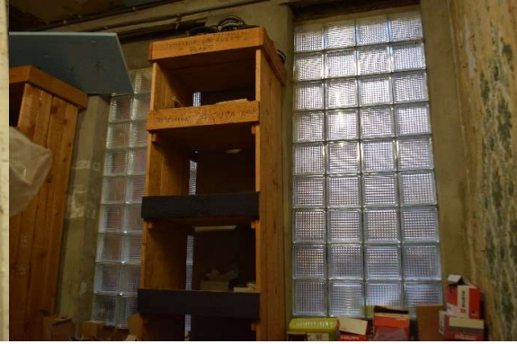
Afb. 294 Ruimte M15B_R0.03: algemeen zicht op de vensteropeningen
