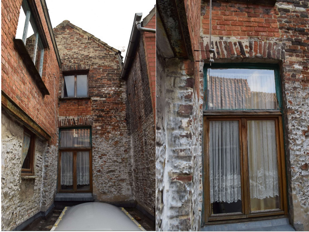
Afb. 147 M5: algemeen zicht op de achtergevel
