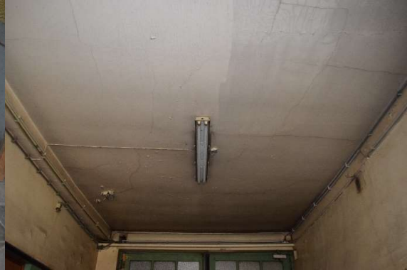
Afb. 387 Ruimte M15a_RO.01: vlak bepleisterd plafond
