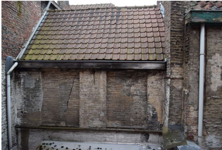
Afb. 80 M3: zicht op de voorgevel van het achterhuis met dichtgemetselde vensteropeningen
