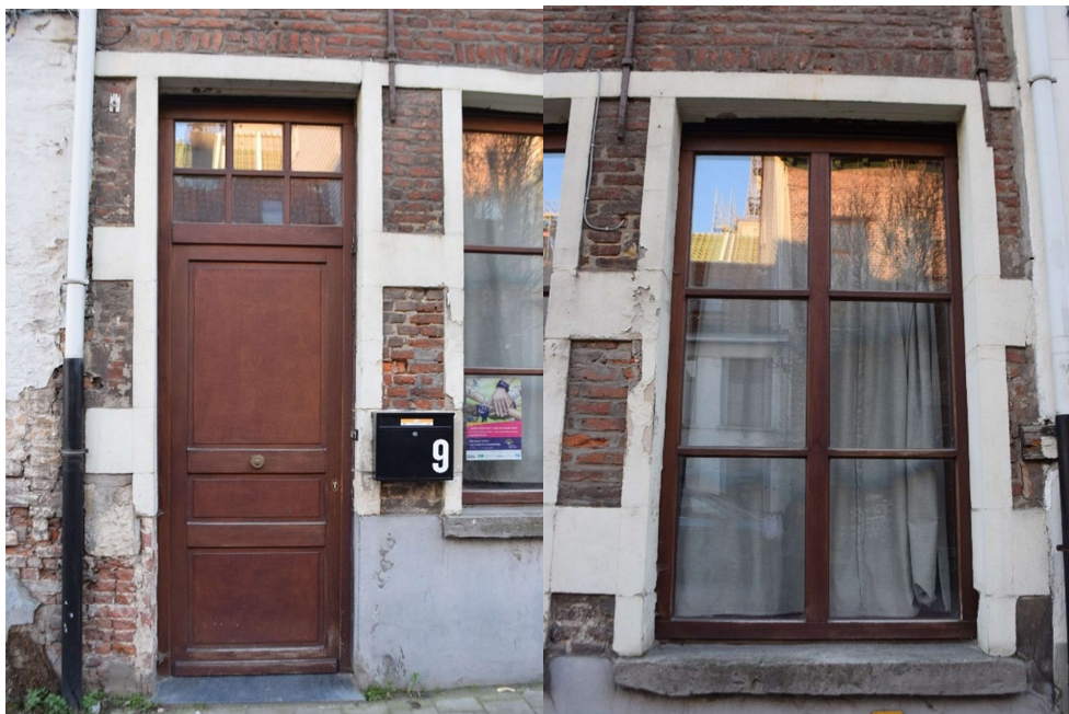
Afb. 239 M9: detail van de deuropening
