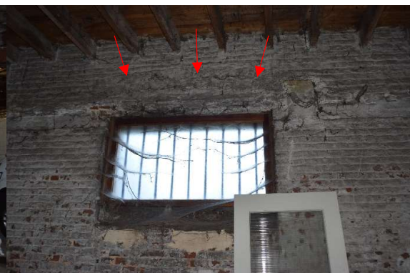
Afb. 661 M15h_R0.13: vensteropeningen voorzien van een ontlastingsboog
