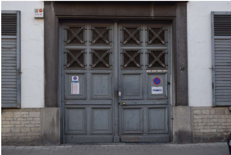
Afb. 365 M15: detail van de dubbele, houten toegangspoort
