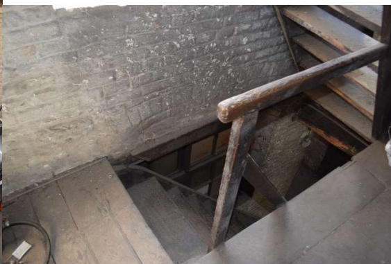
Afb. 600 M15h_R2.01: steektrap naar de eerste verdieping
