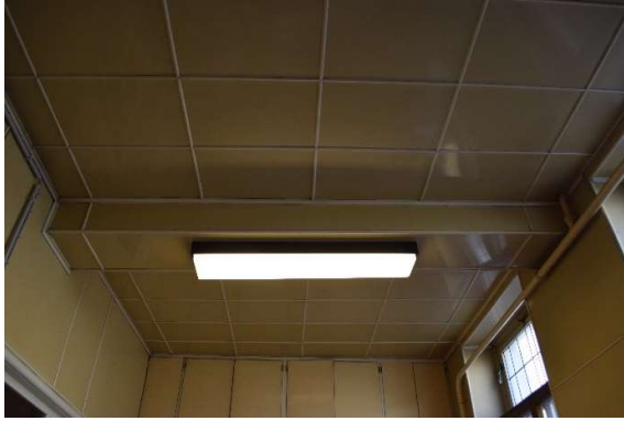
Afb. 392 Ruimte M15a_R0.02: zicht op de moerbalk of ligger
