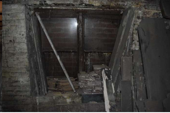
Afb. 668 M15h_R1.11: dichtgemetselde vensteropening
