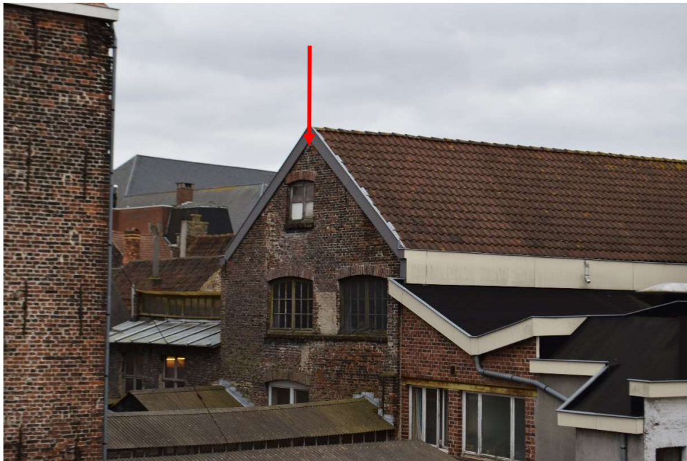
Afb. 520 M15f: algemeen zicht op de achtergevel
