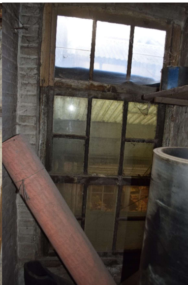
Afb. 581 M15h_R0b.01: houten raam in de buitengevel
