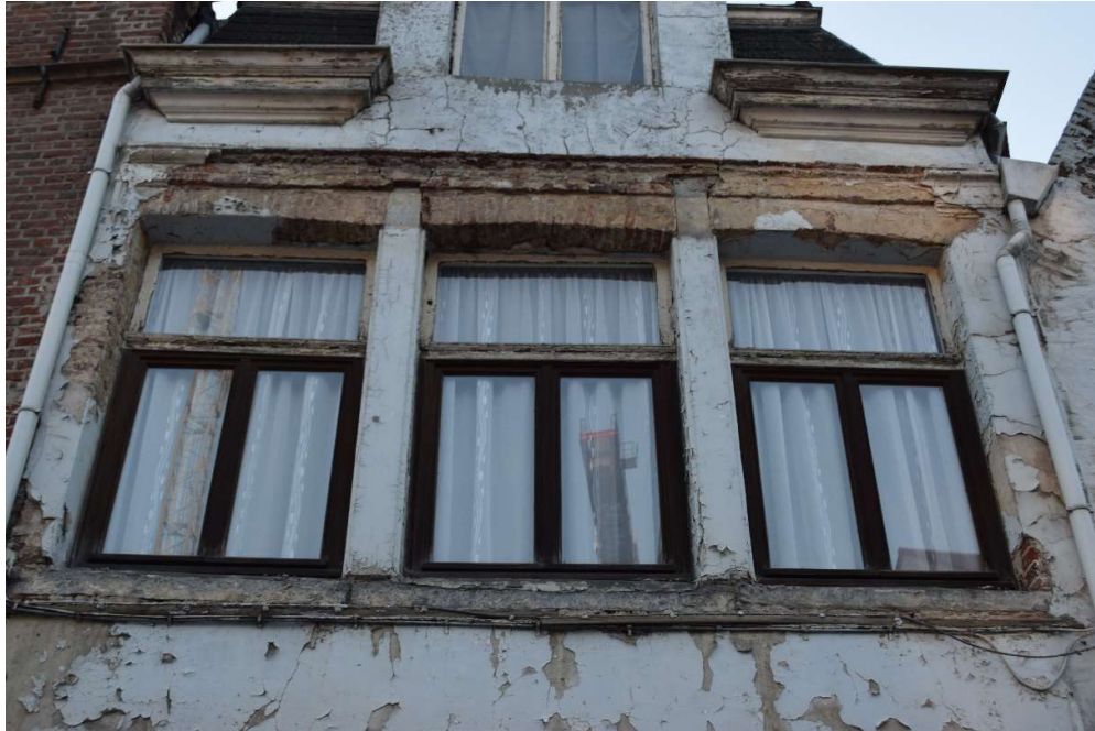
Afb. 145 M5: detail van de gekoppelde vensters van de tweede bouwlaag
