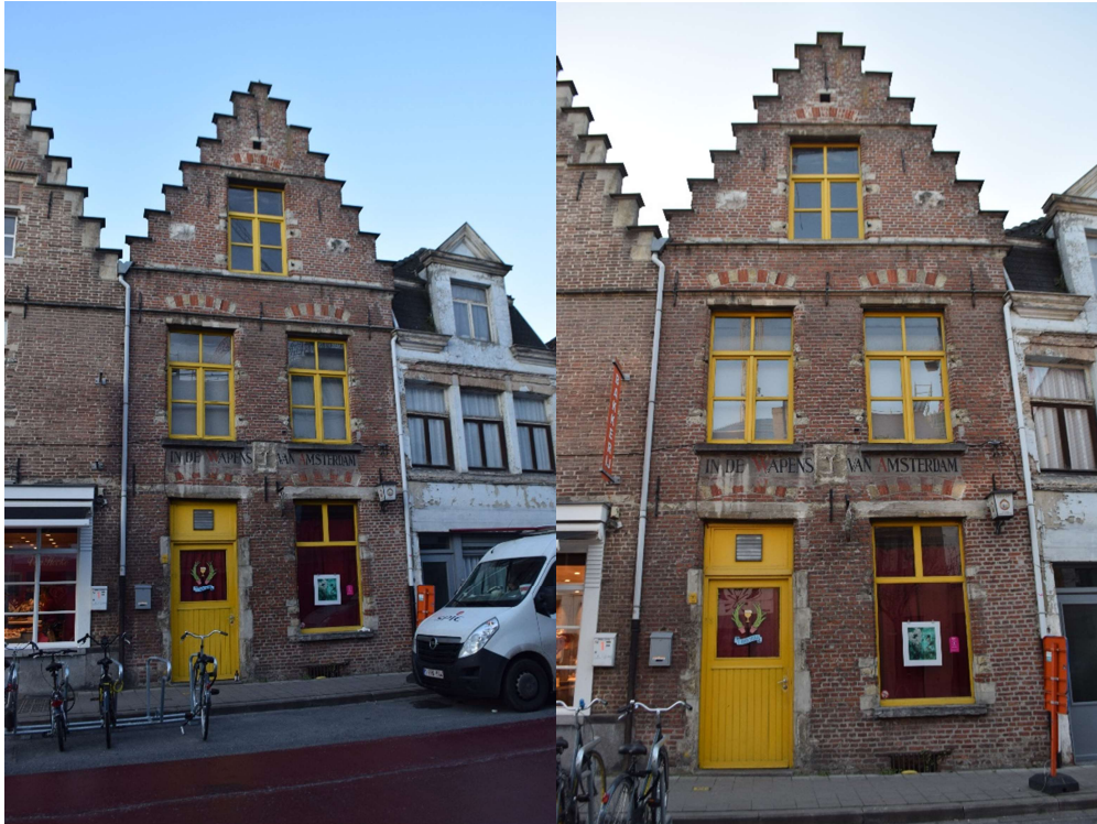
Afb. 71 M3: algemeen zicht op de voorgevel
