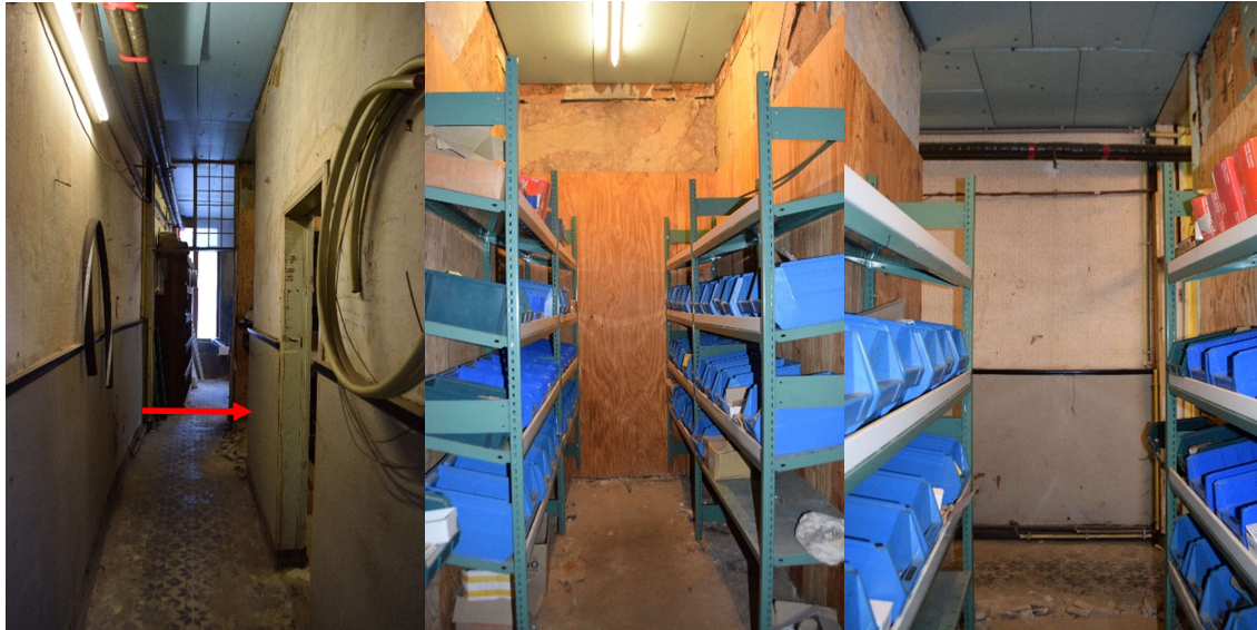
Afb. 288 Ruimte M15B_R0.02: algemeen zicht naar de traphal (rode pijl)
