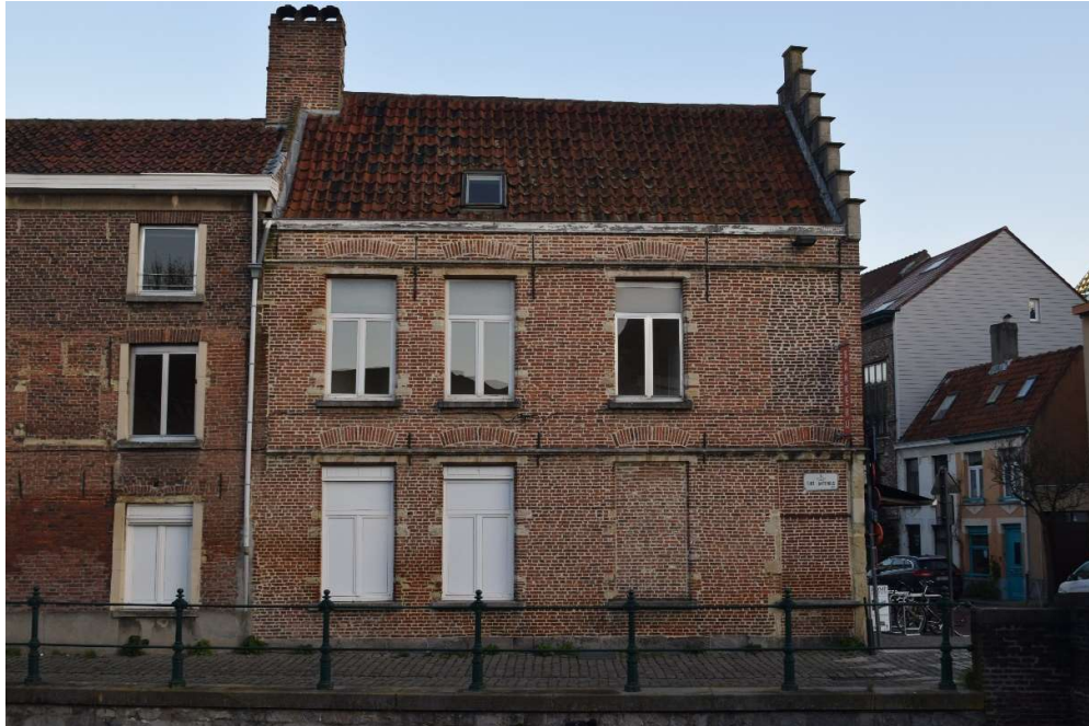
Afb. 6 Zijgevel 1 aan de Sint-Antoniusskaai
