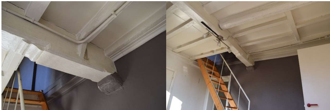
Afb. 31 Ruimte M1_R1.04: detail van de 16 de -eeuwse balksleutels
