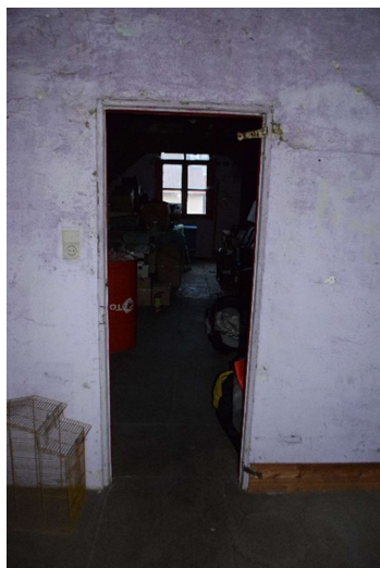
Afb. 140 Ruimte M3_R2.02: deuropening naar ruimte M3_R0.02
