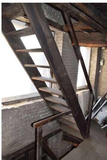
Afb. 599 M15h_R2.01: steektrap naar de derde verdieping
