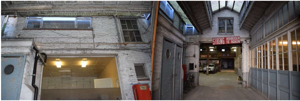
Afb. 419 Ruimte M15a_R0.08: buitenmuur van de haakse aanbouw
