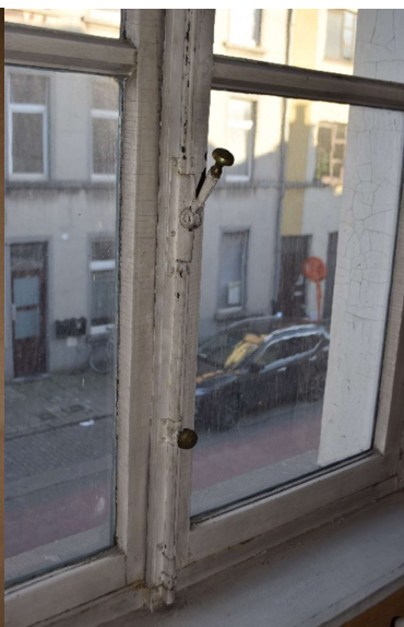
Afb. 430 Ruimte M15a_R1.01: detail pompespanjoetsluiting
