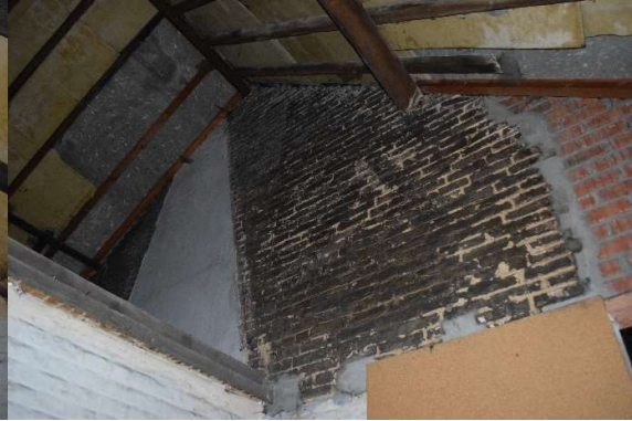
Afb. 361 Ruimte M15C_R2.01: scheidingsmuur met ruimte M15B_R2.01
