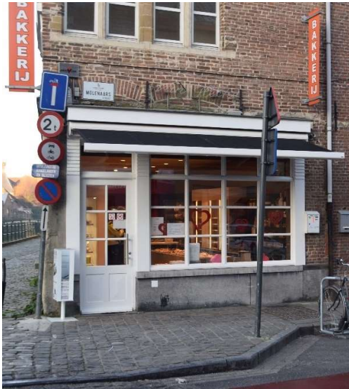
Afb. 3 M1: detail van de recente winkelpui
