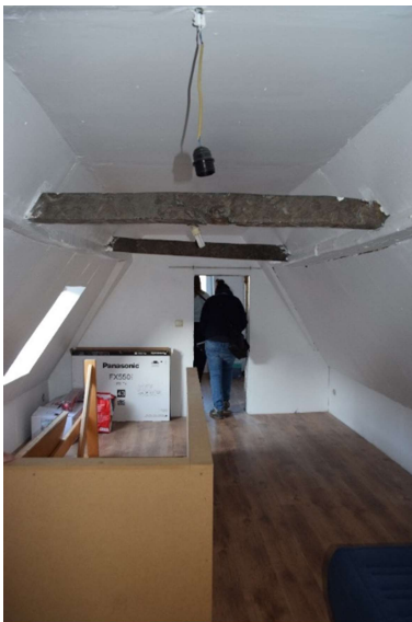
Afb. 269 Ruimte M9_R2.02: algemeen zicht naar de achtergevel
