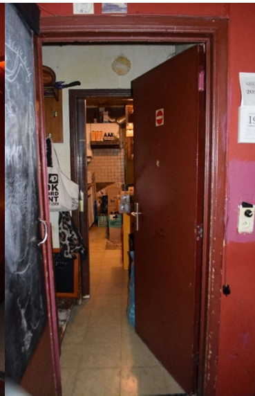
Afb. 99 Ruimte M3_R0.03: toegangsdeur
