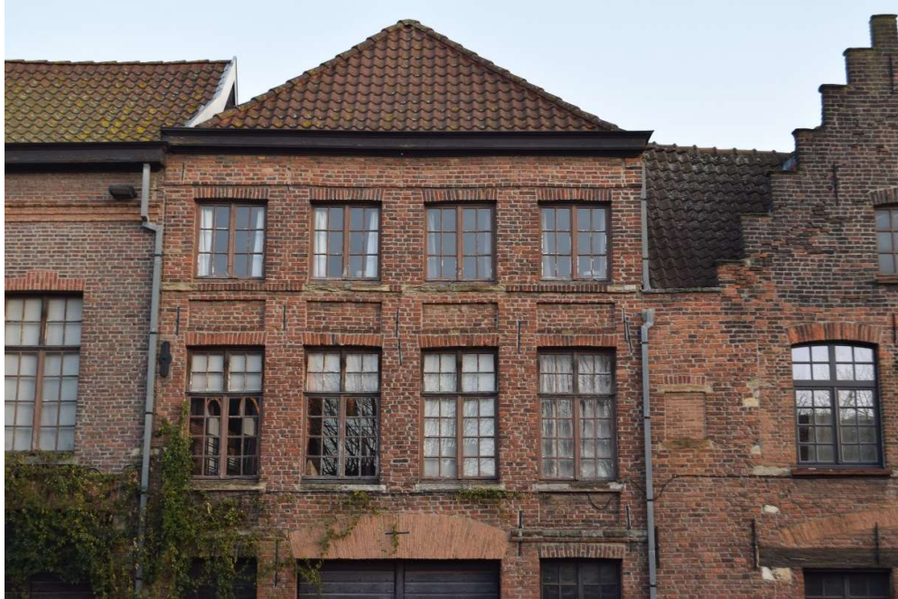
Afb. 518 M15f: detail van de bovenste bouwlagen
