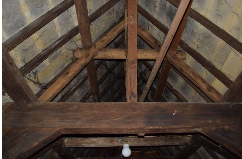
Afb. 129 Ruimte M3_R2.01: detail van de dakconstructie
