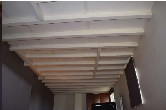
Afb. 68 Ruimte M1_R2.04: zicht op de zoldering
