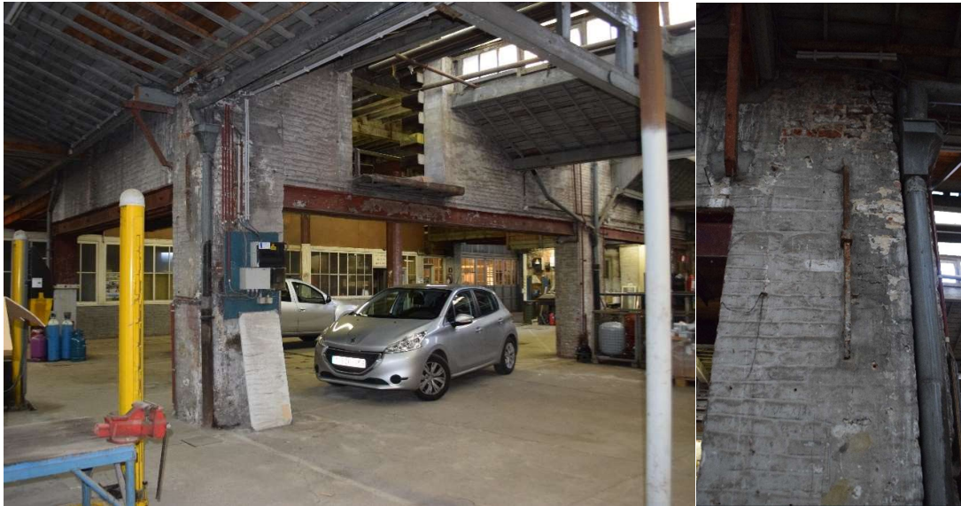
Afb. 564 M15h: algemeen zicht op de oorspronkelijke buitenmuren
