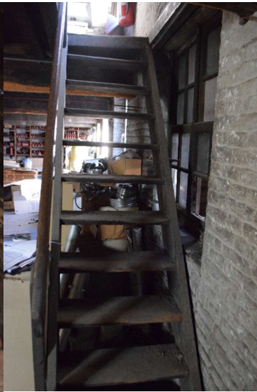
Afb. 591 M15h_R1.01: steektrap naar de tweede verdieping
