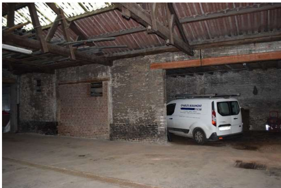
Afb. 637 M15h: zicht op de oorspronkelijke buitengevel
