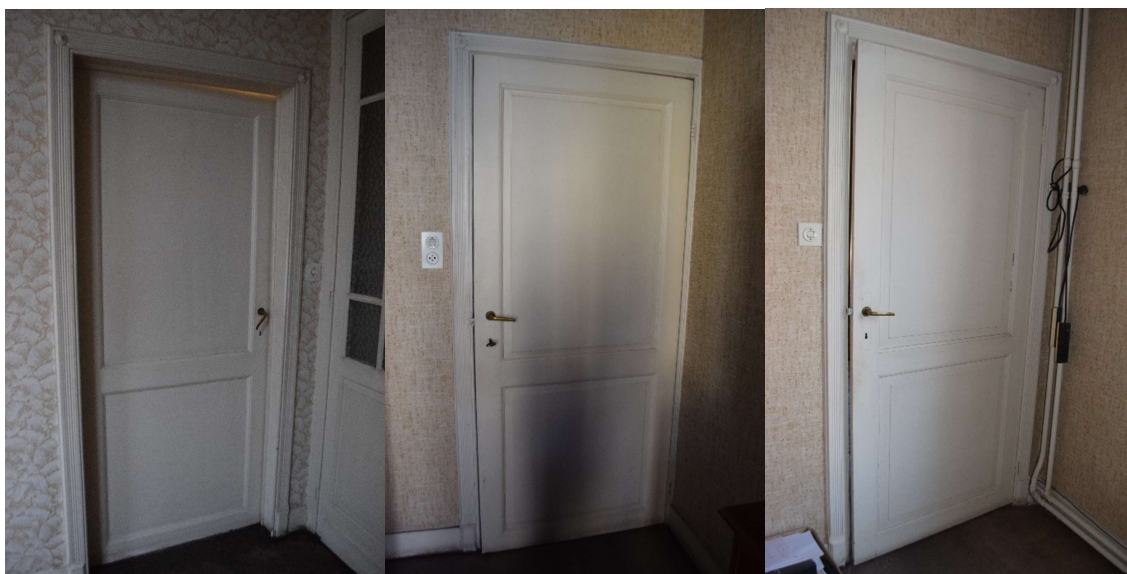
Afb. 451 Ruimte M15a_R1.03: houten paneel deur
