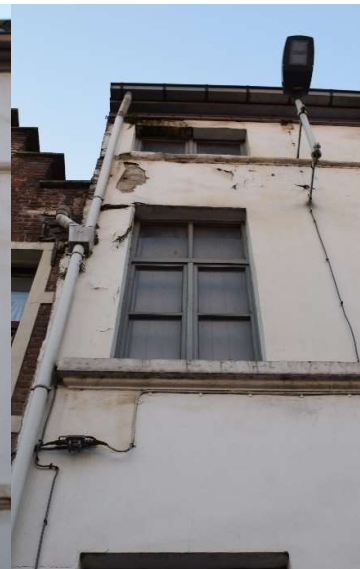
Afb. 277 M15 (11-13): detail van de gevels en vensters
