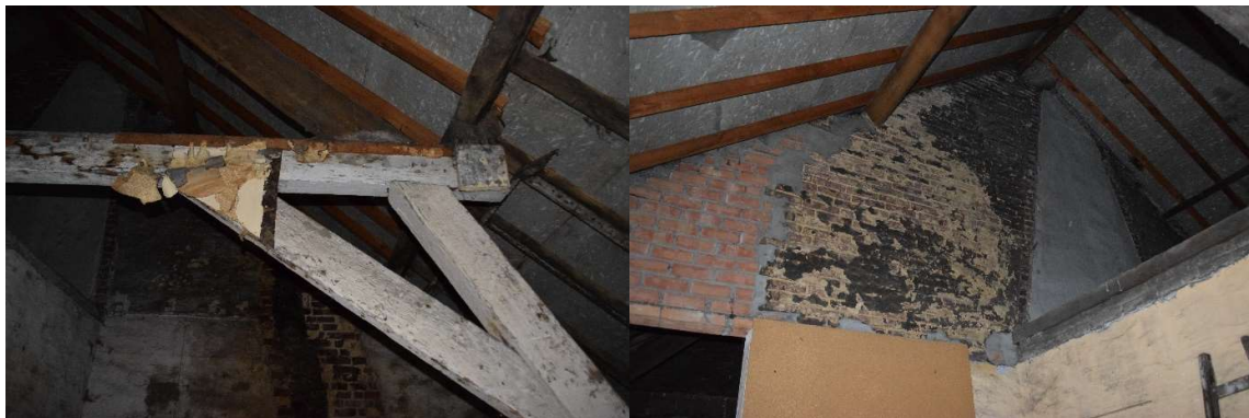
Afb. 349 Ruimte M15B_R2.01: detail van de dakconstructie
