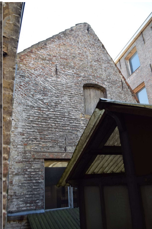
Afb. 374 M15: algemeen zicht op de zijpuntgevel van de haakse achterbouw
