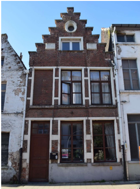
Afb. 237 M9: algemeen zicht op de voorgevel
