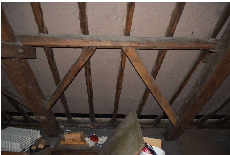
Afb. 530 M15f_R3.01: detail van de dakconstructie
