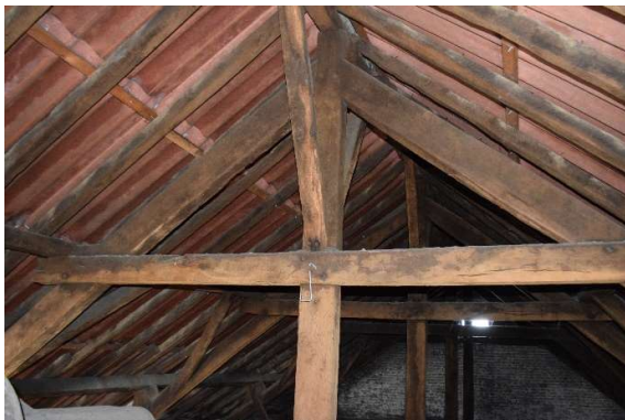
Afb. 625 M15h_R4.02: detail van de dakconstructie
