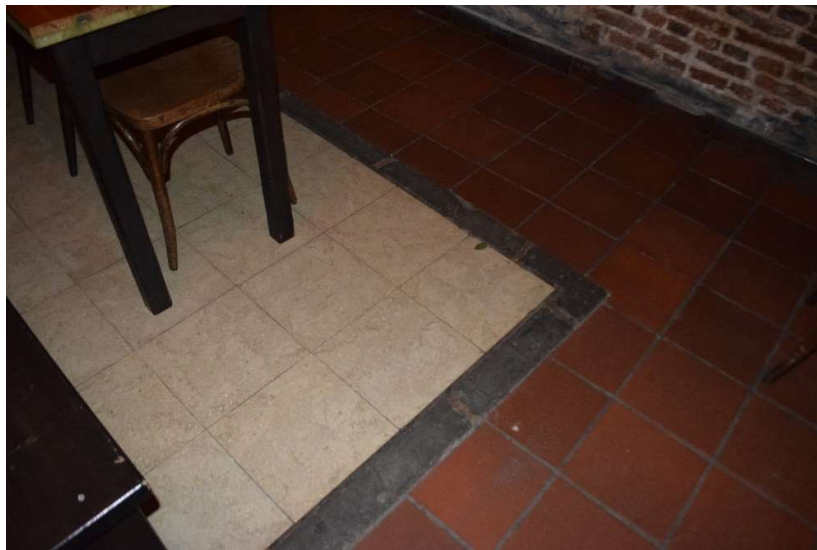
Afb. 92 Ruimte M3_R0.01: detail van de vloeren uit het vierde kwart van de 20 ste eeuw
