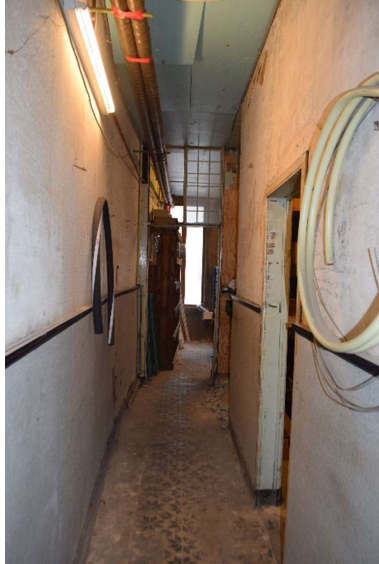
Afb. 282 Ruimte M15B_RO.01: algemeen zicht
