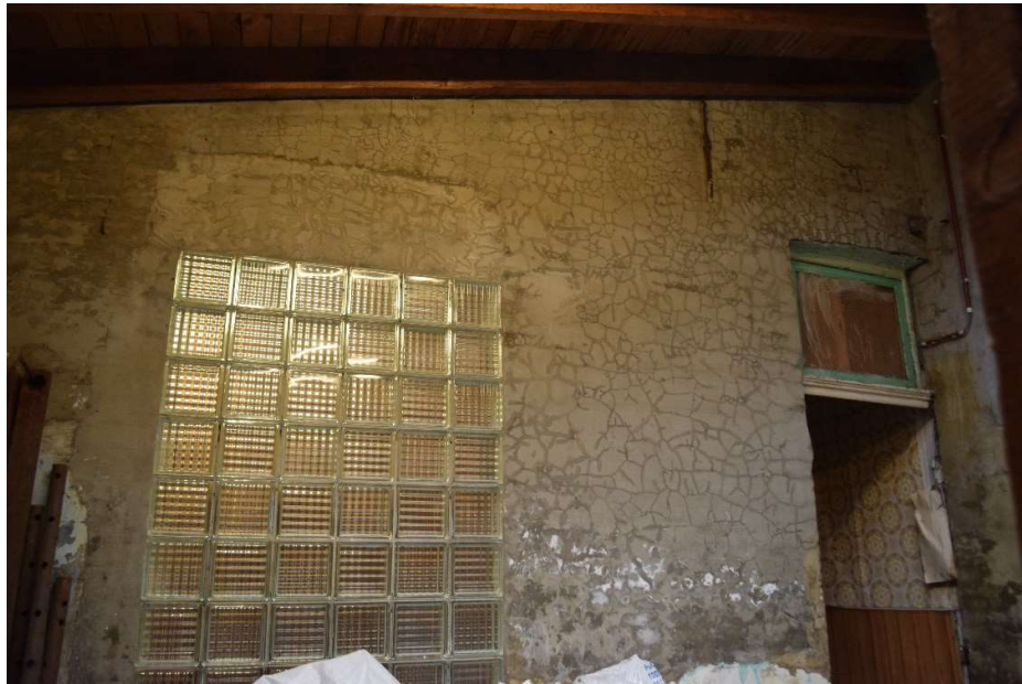
Afb. 280 M15 (11-13): algemeen zicht op de achtergevel van Molenaarstraat 11
