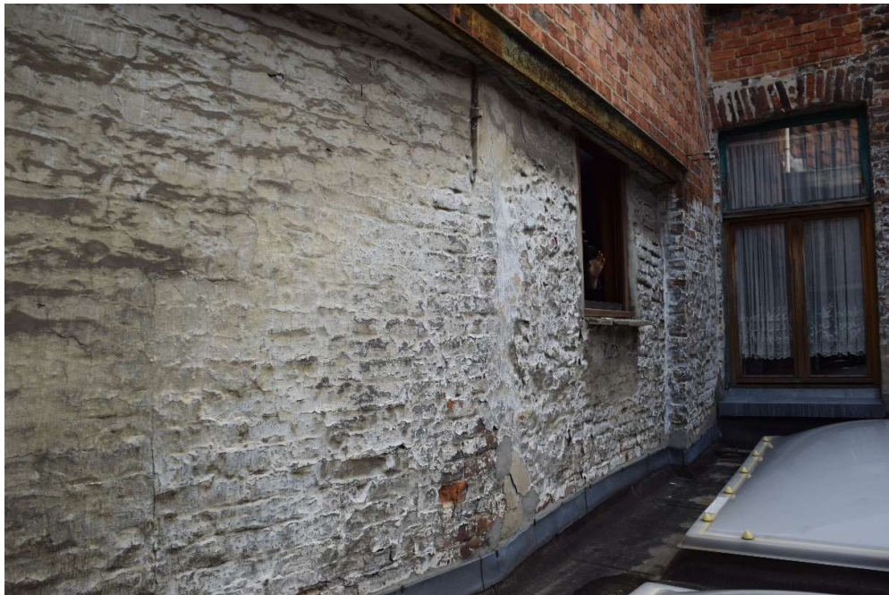
Afb. 156 M5: zicht op de zijgevel van de verbindingsvleugel
