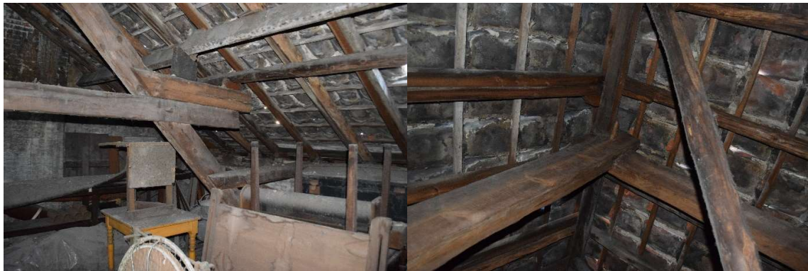
Afb. 479 Ruimte M15a_R2.01: detail van de dakconstructie
