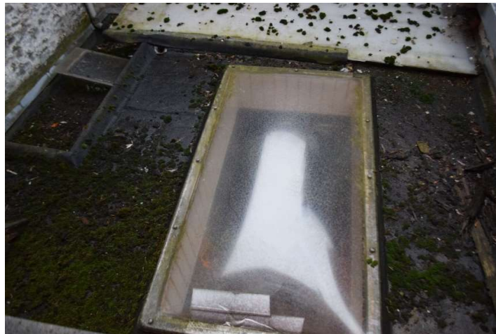
Afb. 81 M3: zicht op de overdekte binnenkoer en lichtkoepel
