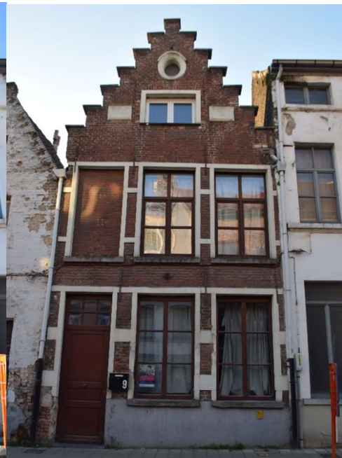
Afb. 238 M9: algemeen zicht op de voorgevel
