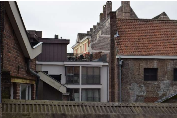
Afb. 653 M15h: zone waar het gebouw werd ingekort
