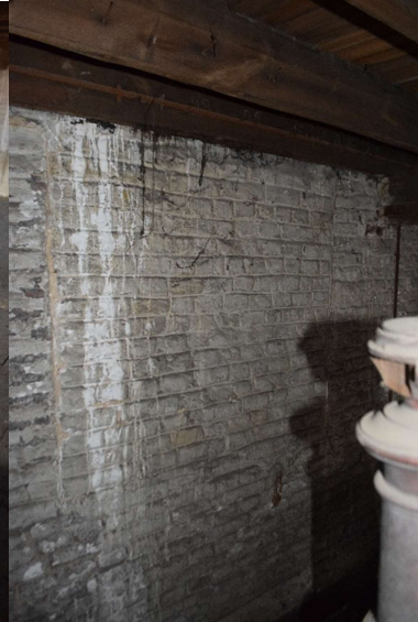
Afb. 675 M15h_R2.03: dichtgemetselde opening
