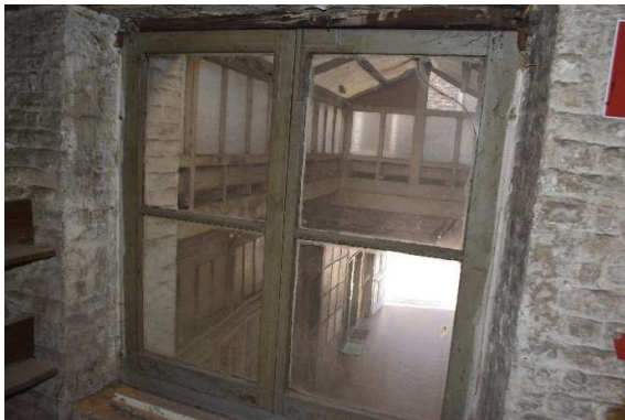
Afb. 575 M15h_R0b.01: houten raam met sporen van luikduimen in de opening
