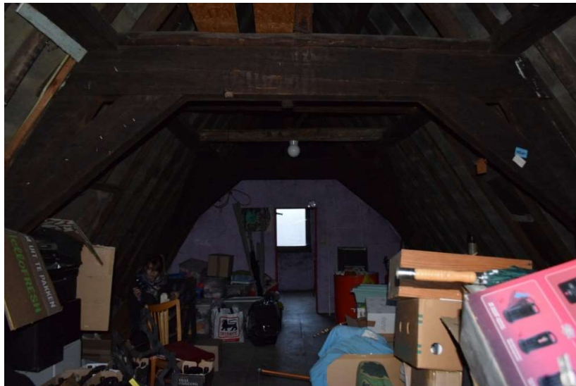
Afb. 128 Ruimte M3_R2.01: algemeen zicht naar de achtergevel
