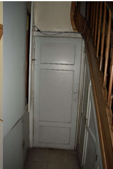
Afb. 411 Ruimte M15a_RO.05: houten deur uit ca. 1942 naar de kelderverdieping
