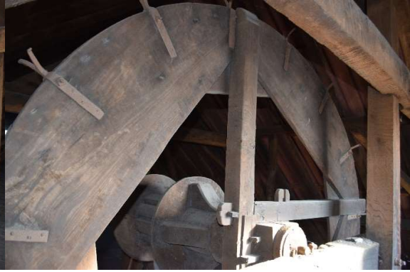
Afb. 628 M15h_R4.02: detail van de windas
