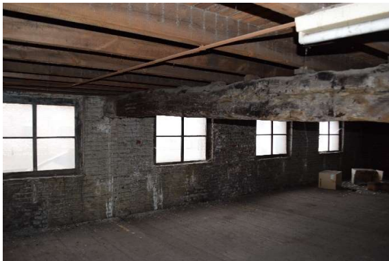
Afb. 671 M15h_R2.03: algemeen zicht op de vensteropeningen
