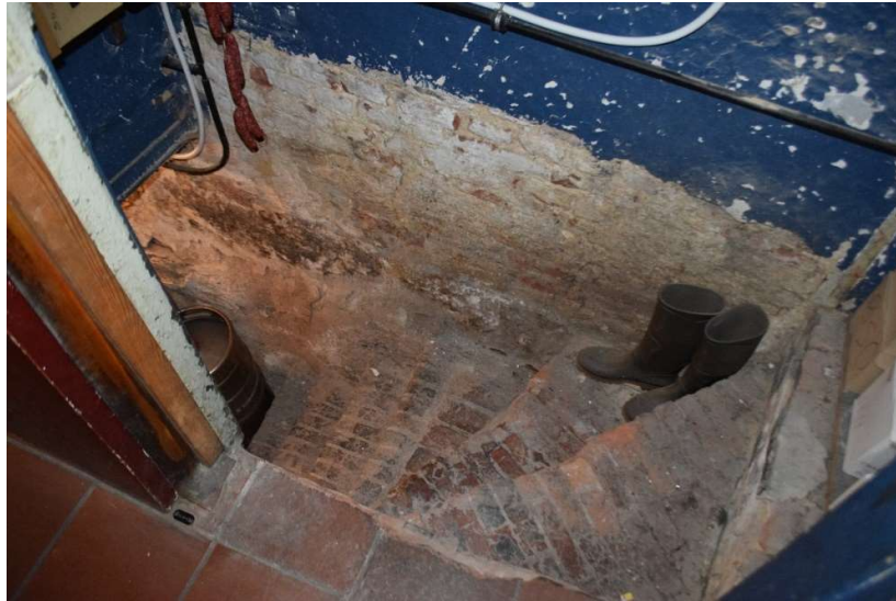
Afb. 97 Ruimte M3_R0.02: toegang tot de kelderverdieping via een bakstenen keldertrap
