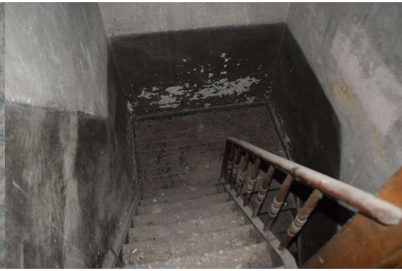
Afb. 342 Ruimte M15C_R1.02: zicht op het trapbordes tussen de eerste en zolderverdieping, geschilderde lambrisering
