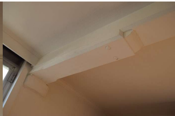
Afb. 37 Ruimte M1_R1.03: detail van de balksleutel
