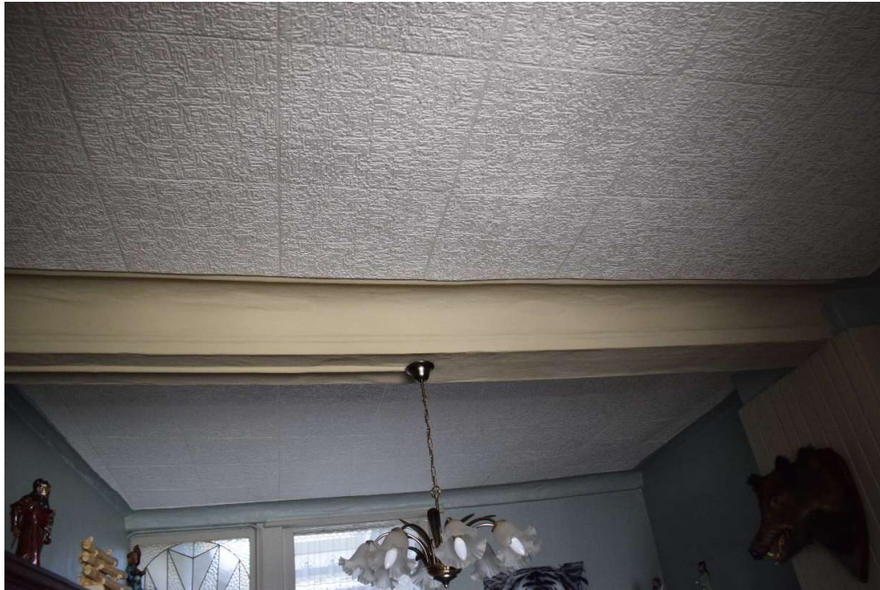
Afb. 167 Ruimte M5_R0.03: zicht op het 18 de -eeuws stucwerkplafond
