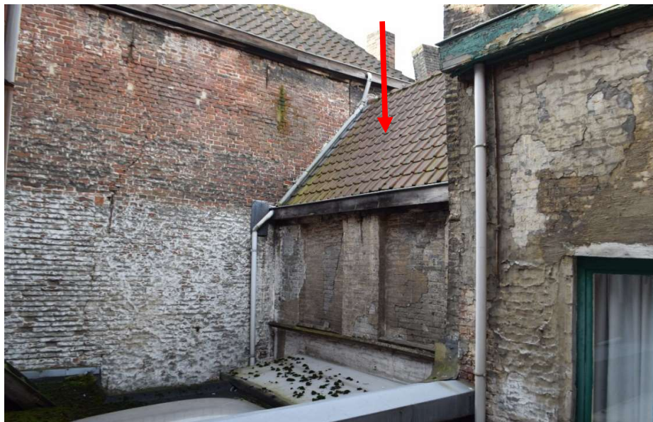
Afb. 79 M3: zicht op het achterhuis
