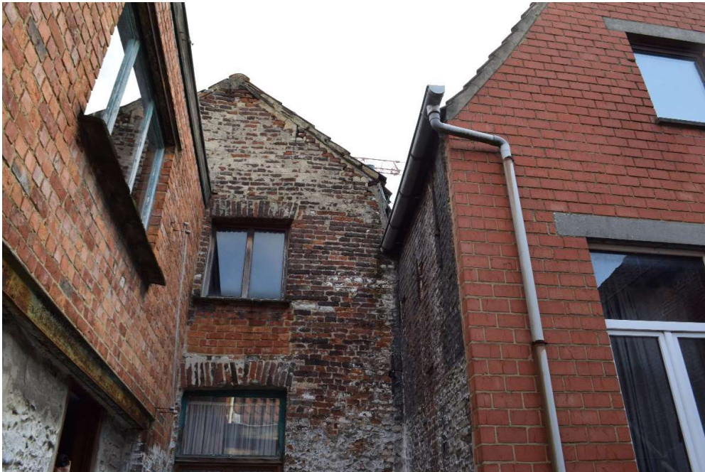
Afb. 149 M5: algemeen zicht op de achtergevel
