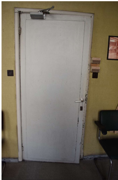
Afb. 403 Ruimte M15a_RO.04: laat 19 de -of begin 20 ste -eeuwse paneel deur
