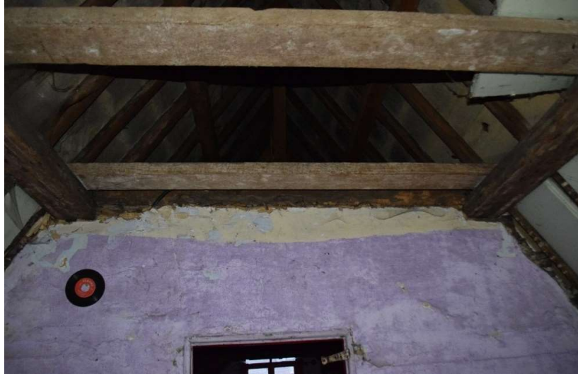
Afb. 138 Ruimte M3_R2.02: detail van de dakconstructie en deel van de deuropening
