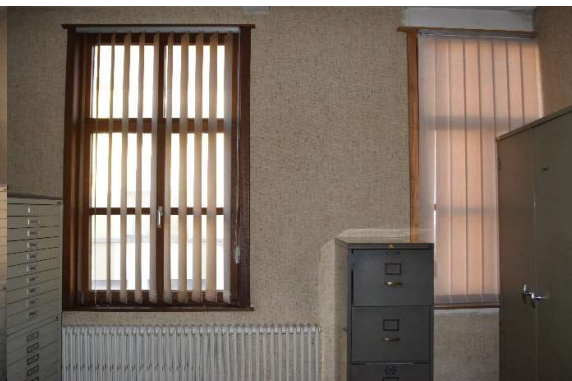
Afb. 334 Ruimte M15C_R1.01: recent schrijnwerk in de vensteropeningen
