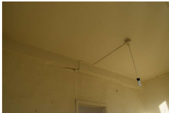
Afb. 50 Ruimte M1_R1.01: zicht op de bepleisterde 17 de -eeuwse moerbalk
