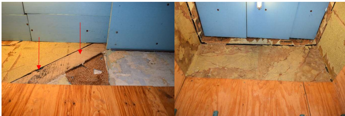
Afb. 291 Ruimte M15B_R0.02: sporen van de weggebroken trap
