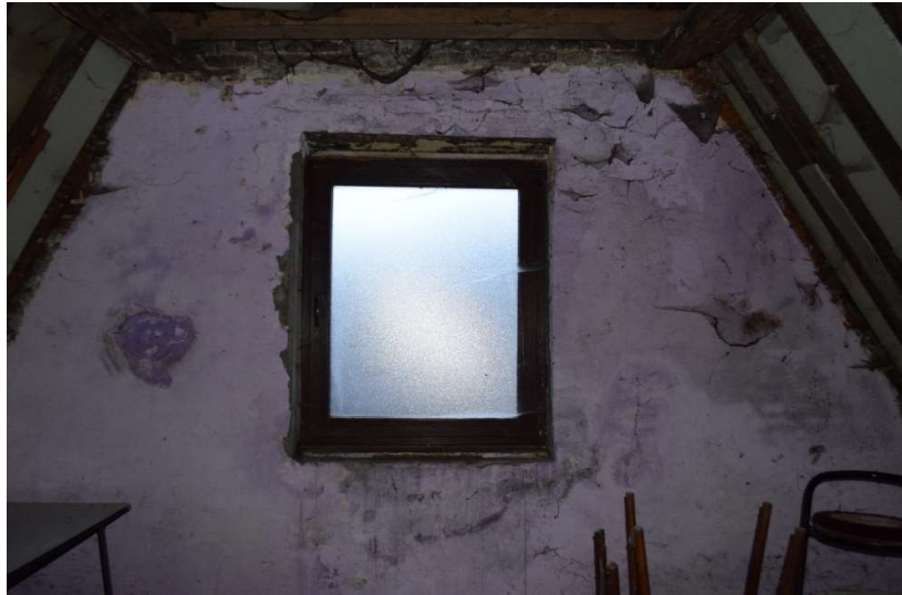
Afb. 136 Ruimte M3_R2.02: algemeen zicht naar de achtergevel
