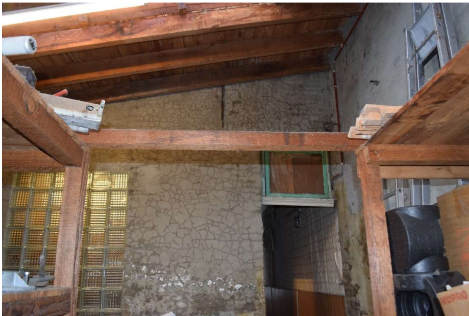
Afb. 279 M15 (11-13): algemeen zicht op de achtergevel van Molenaarstraat 11
