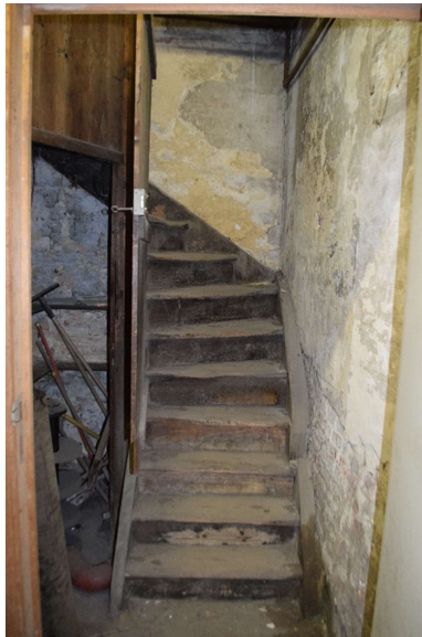
Afb. 568 M15h_R0.03: originele spiltrap naar de eerste verdieping
