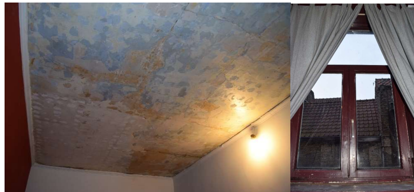
Afb. 125 Ruimte M3_R1.05: plafond
