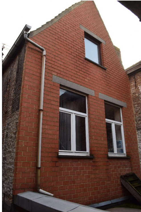
Afb. 78 M3: zicht op de achtergevel
