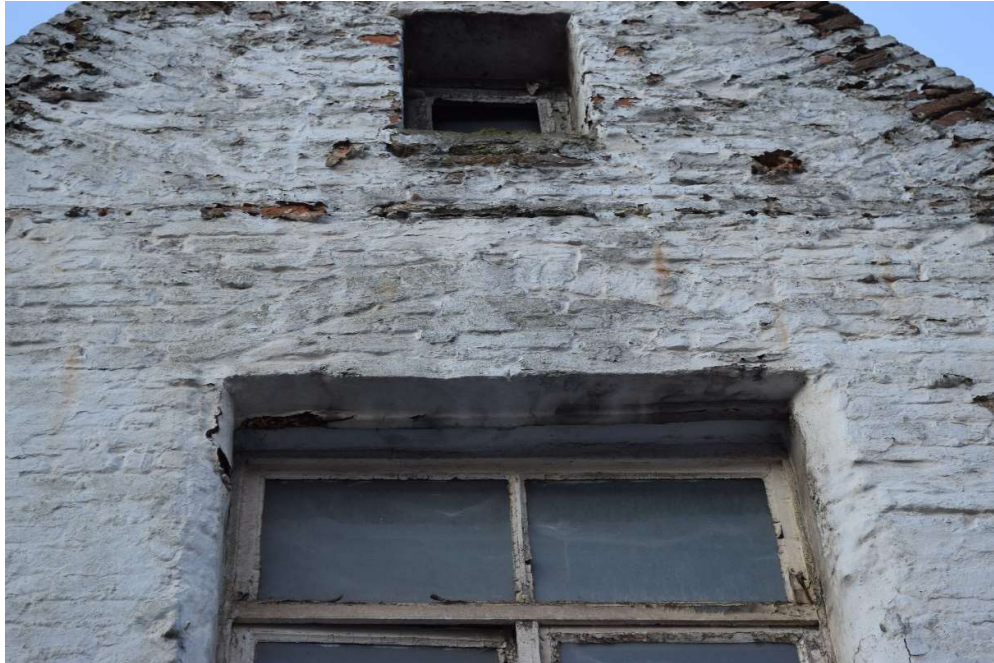
Afb. 230 M7: detail van de ontlastingsboog, muurvlchtingen en klein zoldervenster
