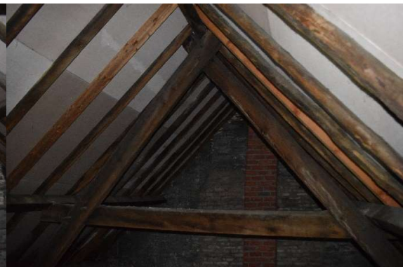
Afb. 557 M15g_R2b.01: algemeen zicht op de dakconstructie
