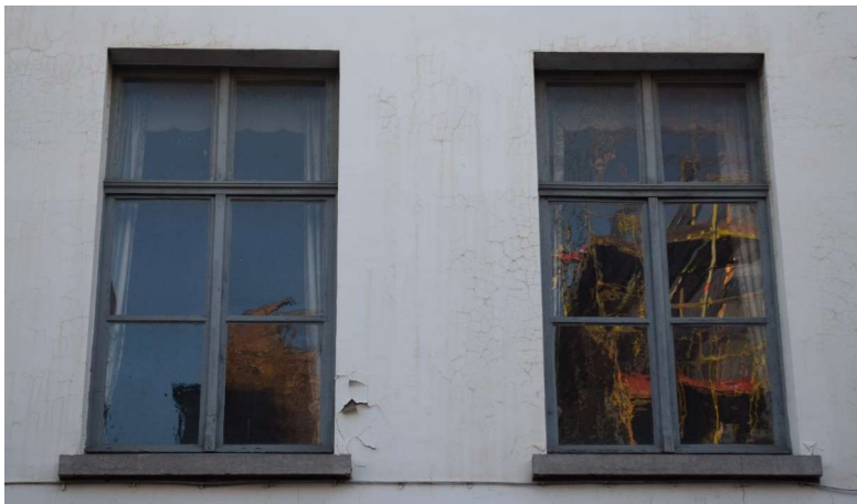
Afb. 366 M15: detail van de 19 de -eeuwse houten ramen van de bovenverdieping
