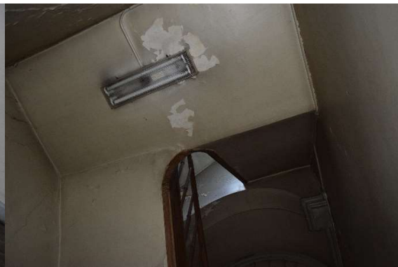
Afb. 469 Ruimte M15a_R1.07: zicht op het plafond
