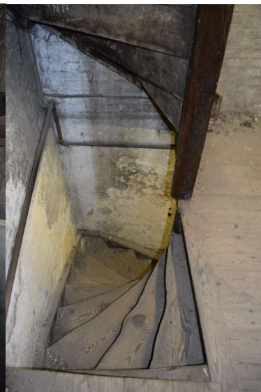
Afb. 582 M15h_R0b.01: detail van de spiltrap
