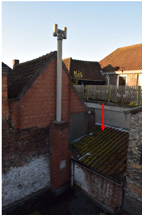
Afb. 236 M7: zicht op het achterhuis
