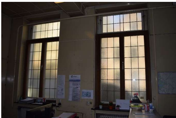
Afb. 390 Ruimte M15a_RO.02: 20 ste -eeuwse houten ramen in de voorgevel
