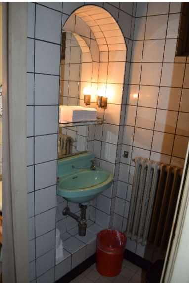
Afb. 416 Ruimte M15a_R0.07: detail van het toilet jaren '40
