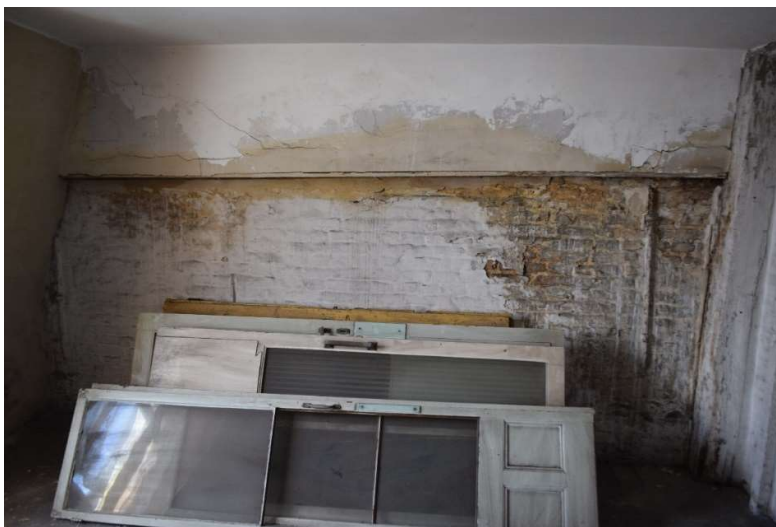
Afb. 214 Ruimte M5_R2.01: algemeen zicht. Op de zolder liggen enkele binnendeuren die vermoedelijk afkomstig zijn van de deuropeningen op de gelijkvloerse verdieping
