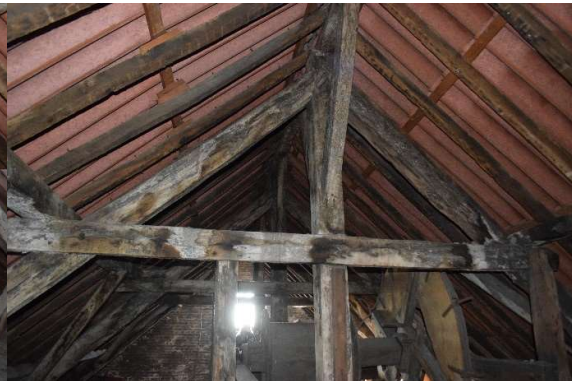
Afb. 622 M15h_R4.01: detail van de dakconstructie
