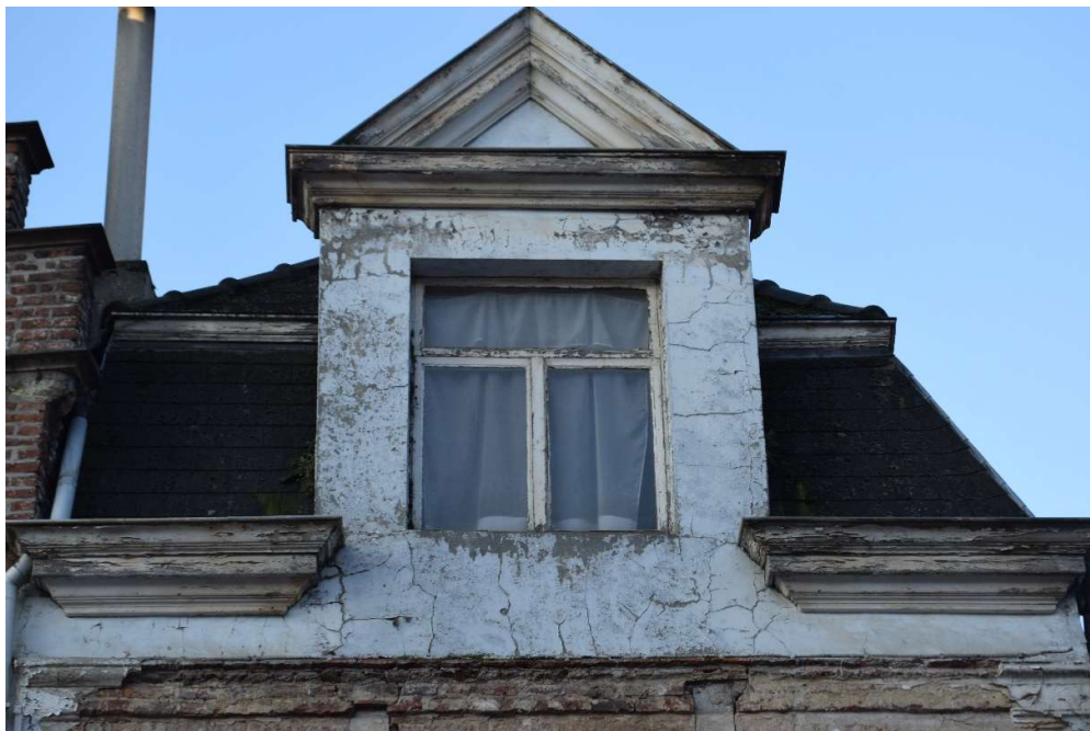
Afb. 146 M5: detail van het dak en het dakvenster
