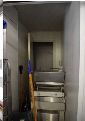
Afb. 18 Ruimte M1_R0.02: doorgang naar de ruimte achter de trap
