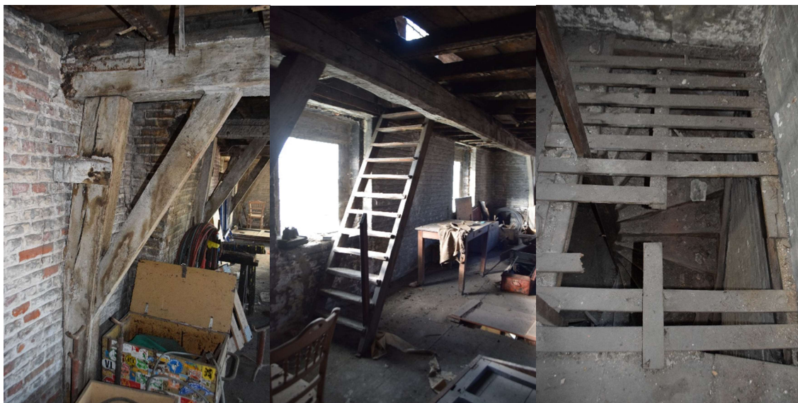
Afb. 614 M15h_R3.02: detail van de muurstijlen en korbelen
