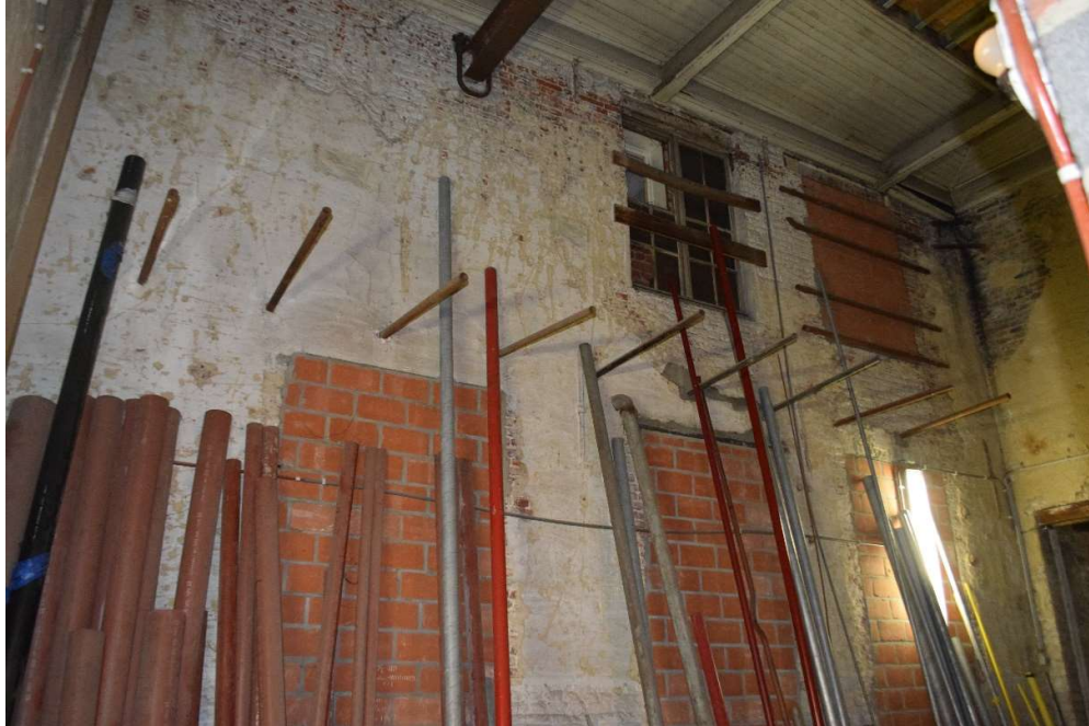
Afb. 522 M15f: algemeen zicht op de zijgevel met dichtgemetselde openingen
