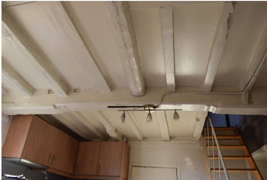
Afb. 33 Ruimte M1_R1.04: algemeen zicht op de 15 de -eeuwse balkenzoldering
