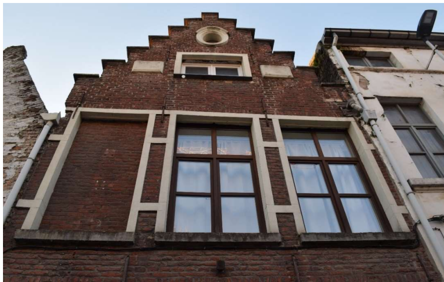
Afb. 241 M9: algemeen zicht op de geveltop met onderaan de vlaggenstokhouder
