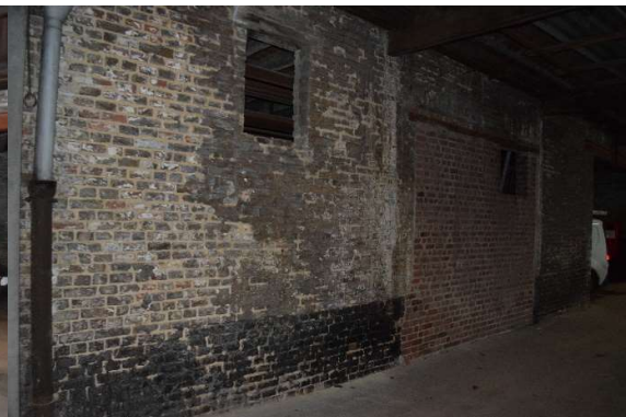
Afb. 638 M15h: M15h: zicht op de oorspronkelijke buitengevel
