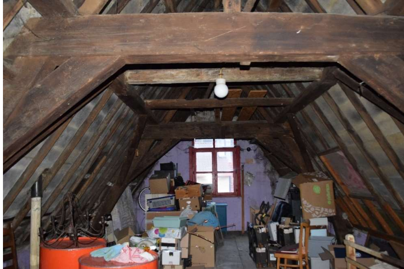
Afb. 127 Ruimte M3_R2.01: algemeen zicht naar de voorgevel
