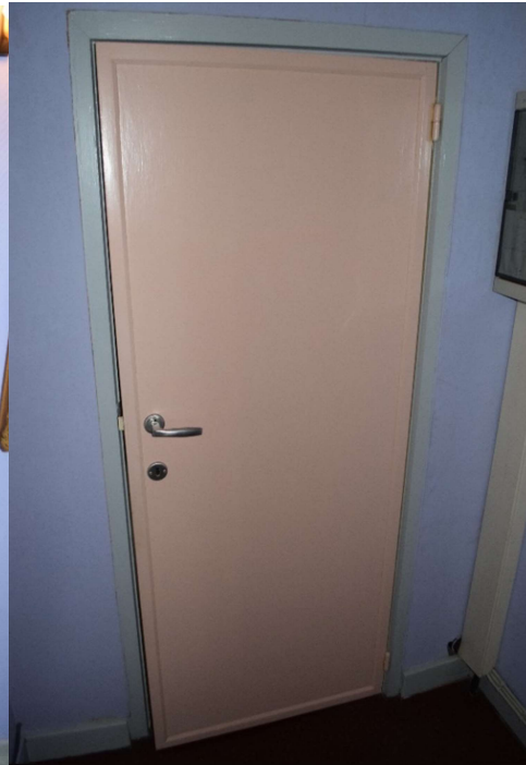
Afb. 207 Ruimte M5_R1.05: 20 ste -eeuwse toegangsdeur
