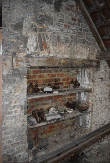
Afb. 645 M15h_R1.09: dichtgemetselde vensteropening in kopgevel
