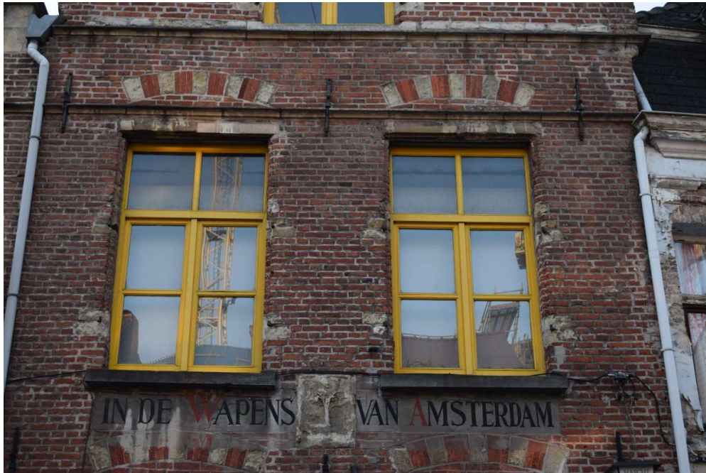
Afb. 76 M3: detail van de vensteropeningen ter hoogte van de tweede bouwlaag
