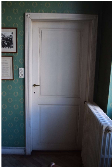
Afb. 441 Ruimte M15a_R1.02: houten paneeldeur naar 0.01
