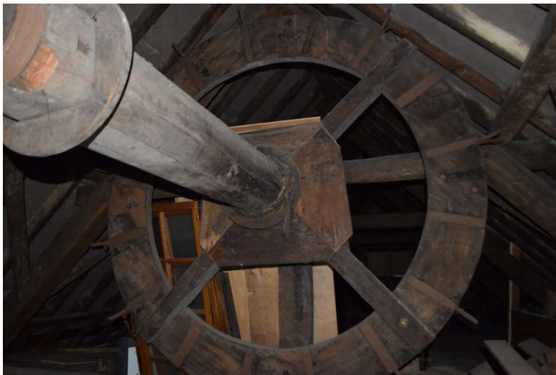
Afb. 529 M15f_R3.01: detail van de windas
