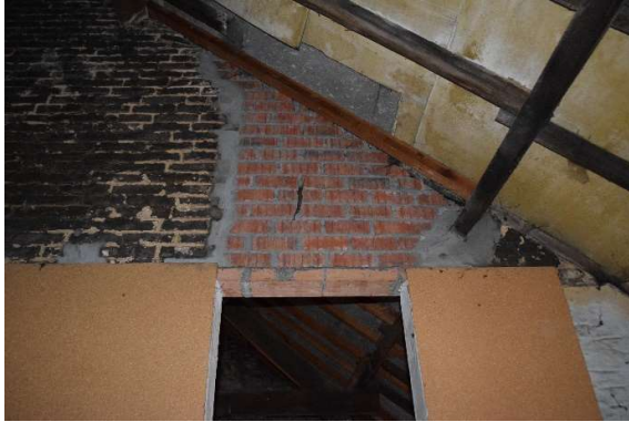
Afb. 360 Ruimte M15C_R2.01: scheidingsmuur met ruimte M15B_R2.01
