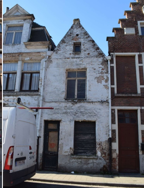
Afb. 228 M7: algemeen zicht op de voorgevel
