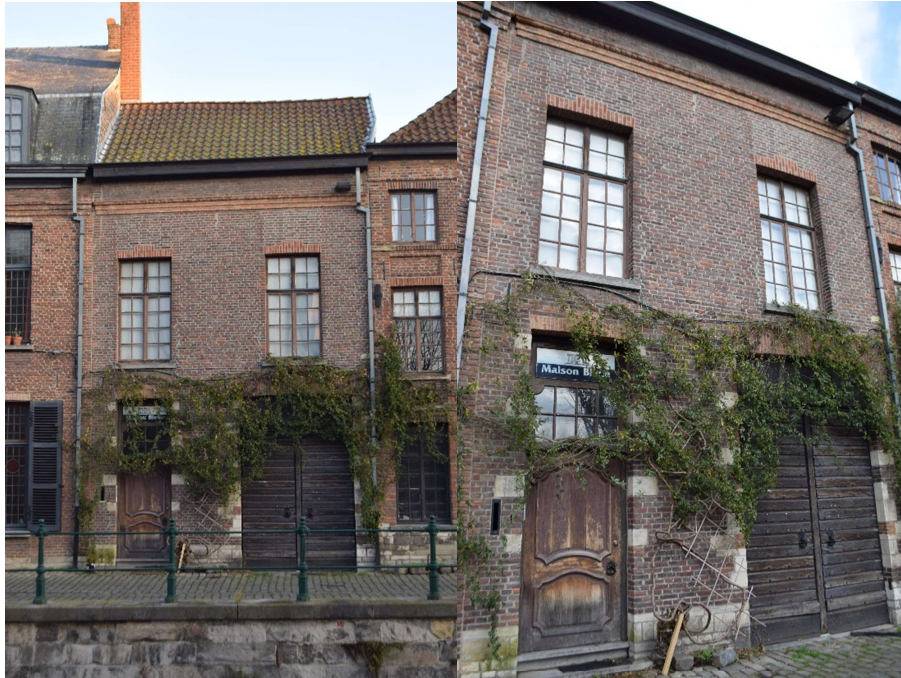
Afb. 531 M15g: algemeen zicht op de voorgevel Afb. 532 M15g: algemeen zicht op de voorgevel
