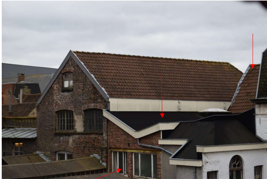
Afb. 536 M15g: algemeen zicht op de achtergevel en het dak
