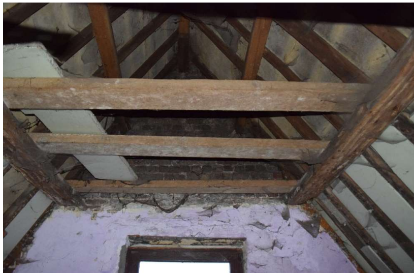
Afb. 137 Ruimte M3_R2.02: detail van de dakconstructie
