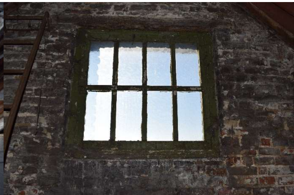
Afb. 624 M15h_R4.01: houten raam in de buitengevel
