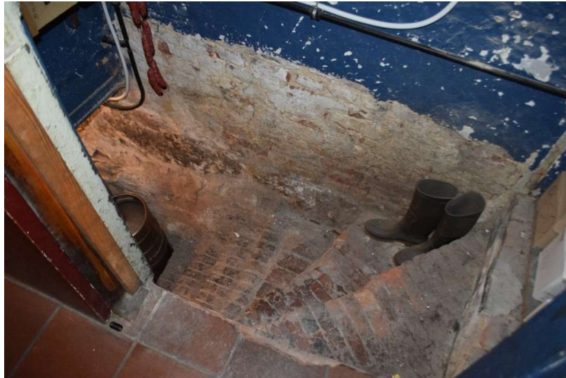
Afb. 83 Ruimte M3_R-1.01: bakstenen keldertrap
