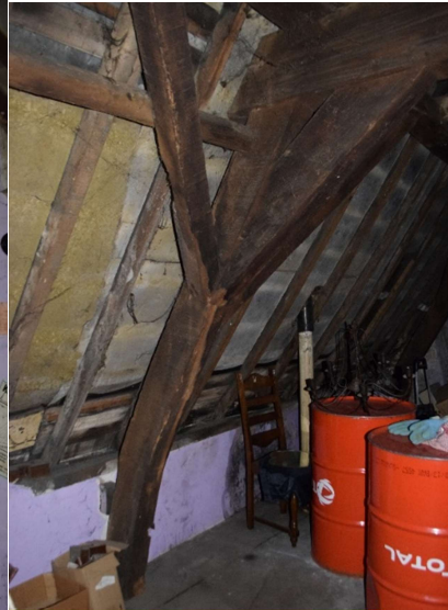
Afb. 133 Ruimte M3_R2.01: detail van een spantbeen
