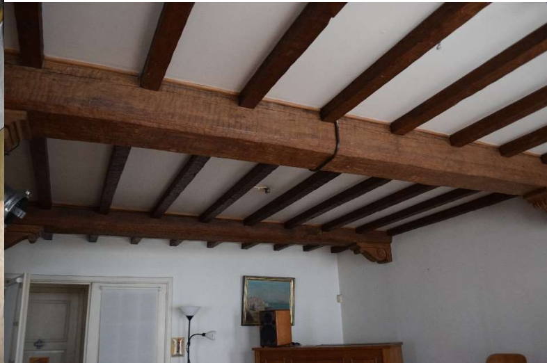
Afb. 526 M15f_R1.01: zicht op de balkenzoldering
