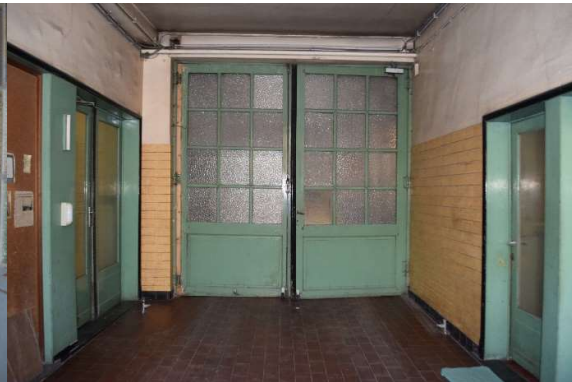
Afb. 381 Ruimte M15a_RO.01: algemeen zicht naar de achtergevel
