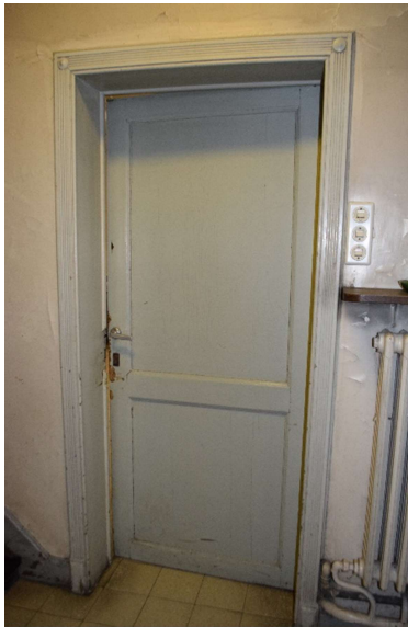
Afb. 414 Ruimte M15a_R0.07: eind 19 de of begin 20 ste -eeuwse paneeldeur
