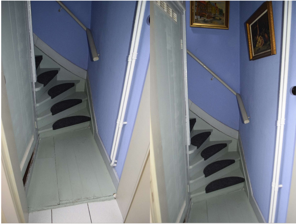
Afb. 179 Ruimte M5_R0.05: houten plankenvloer
