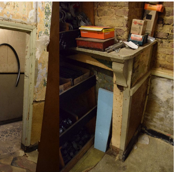
Afb. 297 Ruimte M15B_R0.03: detail van de houten haardmantel
