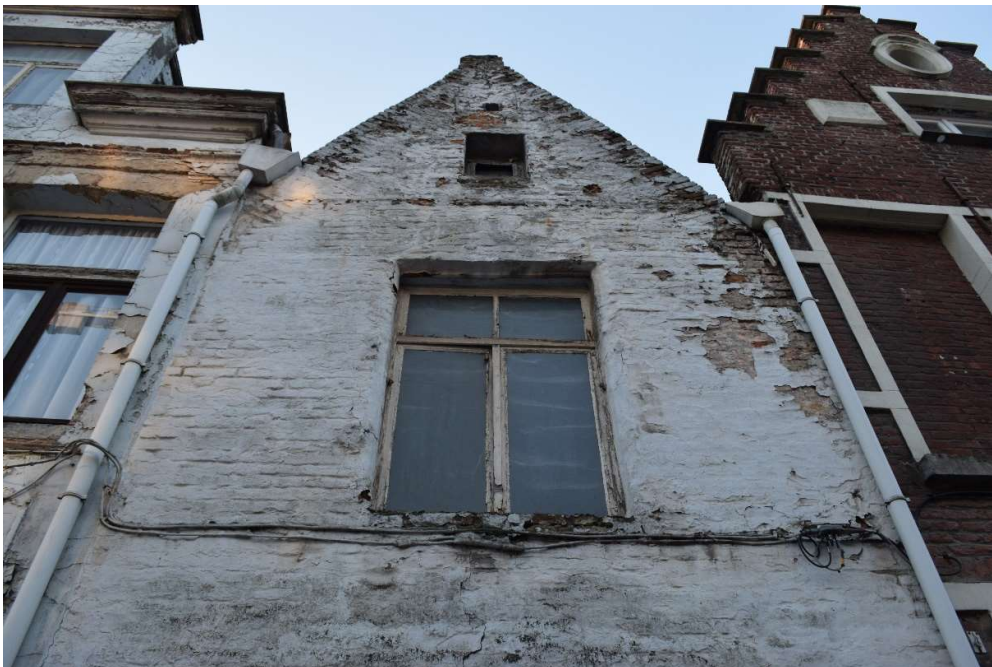
Afb. 229 M7: detail van de tweede bouwlaag met ontlastingsboog boven de vensteropening
