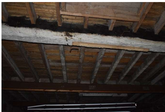
Afb. 658 M15h_R0.13: zicht op de balkenzoldering
