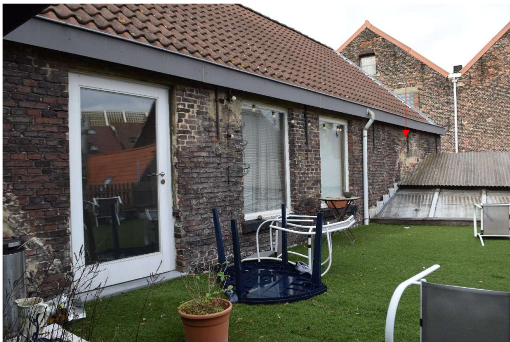
Afb. 521 M15f: algemeen zicht op de zijgevel
