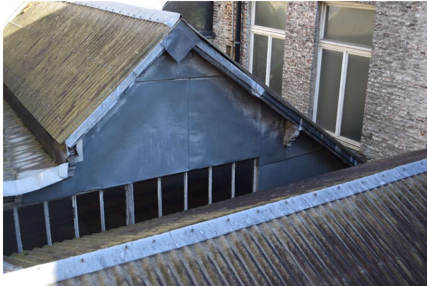
Afb. 375 M15: algemeen zicht op de overdekte binnenkoer
