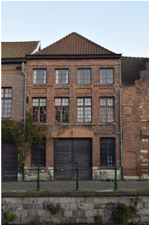
Afb. 516 M15f: algemeen zicht op de voorgevel
