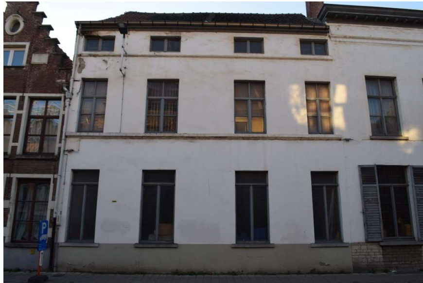
Afb. 274 M15 (11-13): algemeen zicht op de voorgevels
