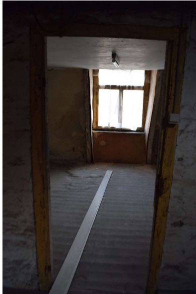
Afb. 215 Ruimte M5_R2.01: deuropening
