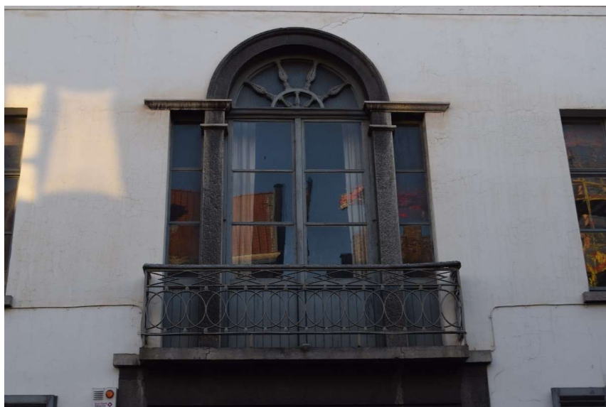
Afb. 364 M15: detail van het Venetiaans deurvenster uit 1828
