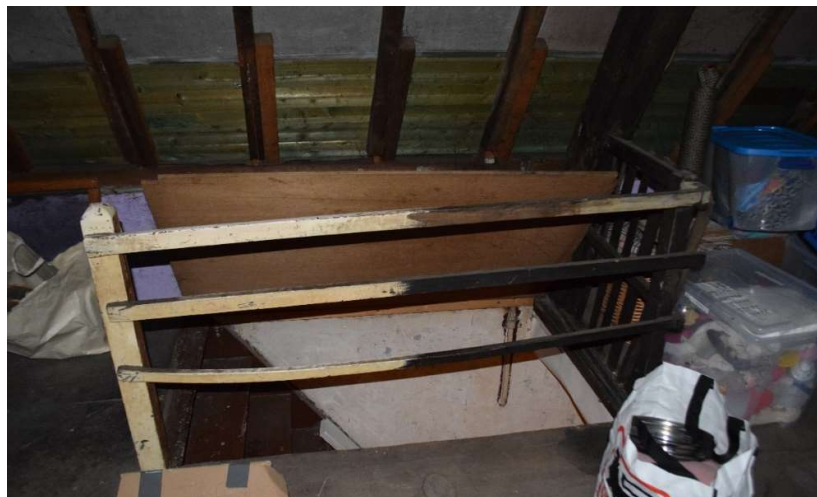
Afb. 135 Ruimte M3_R2.01: zicht op de zoldertoegang
