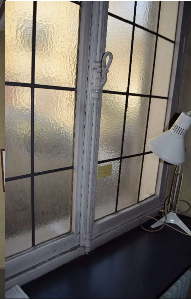
Afb. 405 Ruimte M15a_RO.04: detail van de spanjoetsluiting
