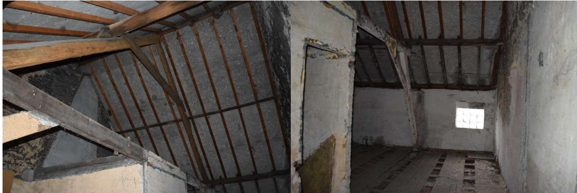
Afb. 347 Ruimte M15B_R2.01: 19 de -eeuwse dakconstructie
