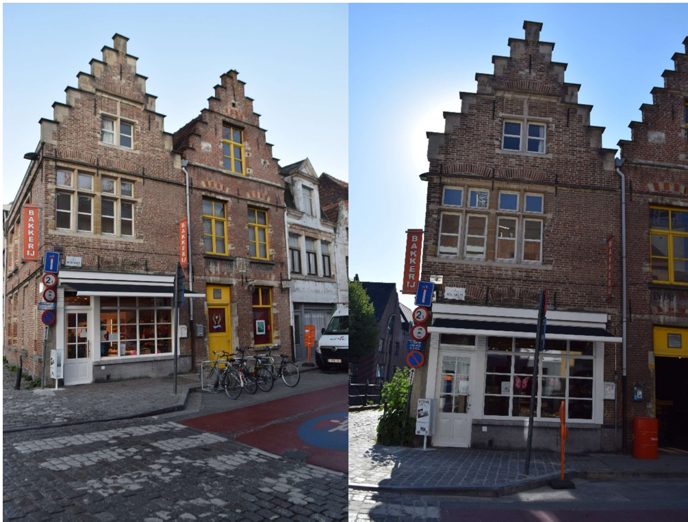
Afb. 1 M1: algemeen zicht op de voorgevel
