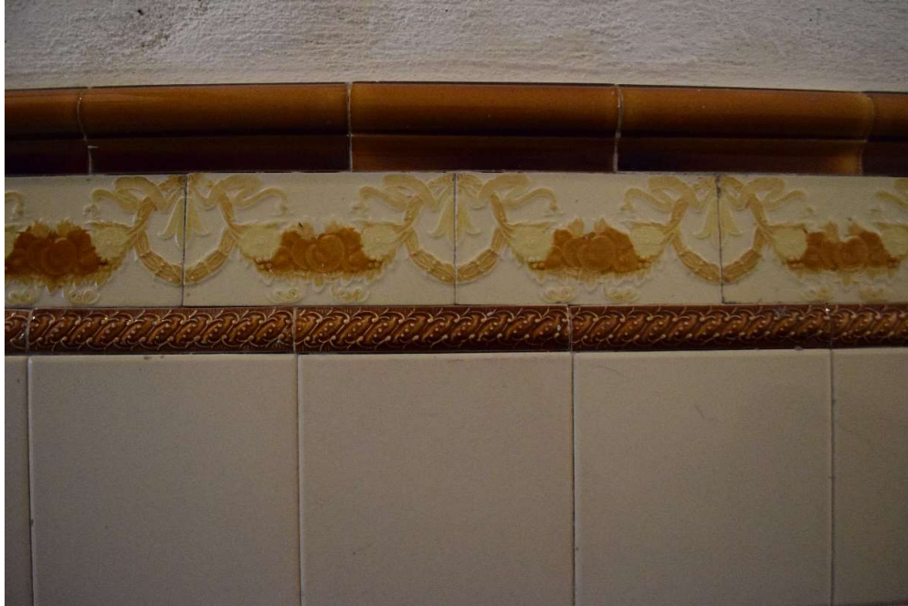
Afb. 255 Ruimte M9_R0.02: bewaarde wandbetegeling uit ca. 1924
