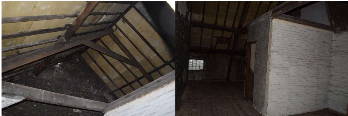
Afb. 355 Ruimte M15C_R2.01: 19 de -eeuwse dakconstructie
