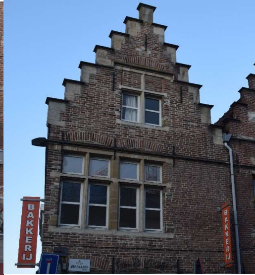
Afb. 4 M1: detail van de tweede bouwlaag en geveltop
