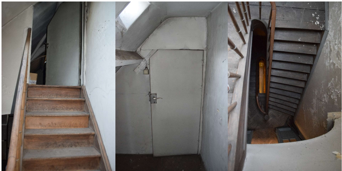
Afb. 487 Ruimte M15a_R2.06: toegang tot de zolderverdieping
