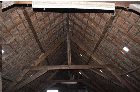
Afb. 677 M15h_R3.03: detail van de dakconstructie
