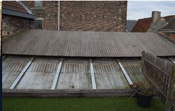
Afb. 497 M15e: het dak werd integraal vervangen
