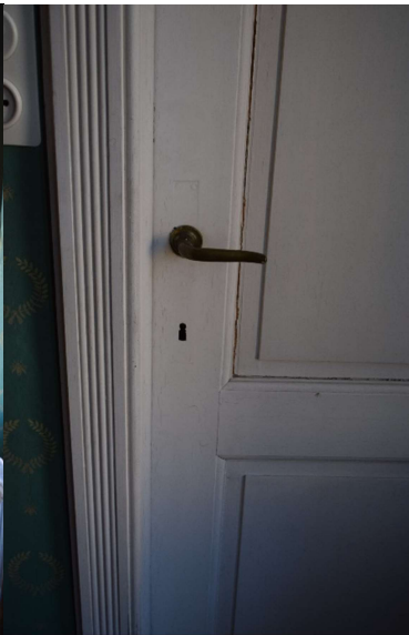
Afb. 442 Ruimte M15a_R1.02: detail van de L-vormige deurkrukken
