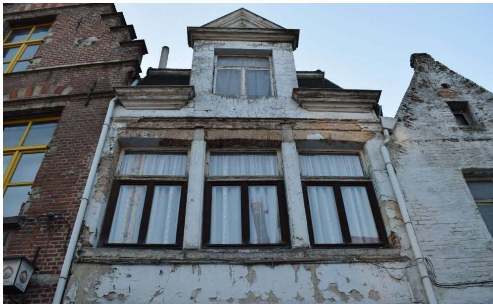
Afb. 144 M5: detail van de gekoppelde vensters van de tweede bouwlaag en dakvenster
