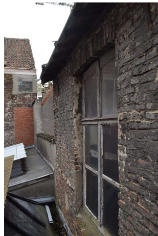
Afb. 498 M15e: gevels in 18 de -eeuws baksteenmetselwerk
