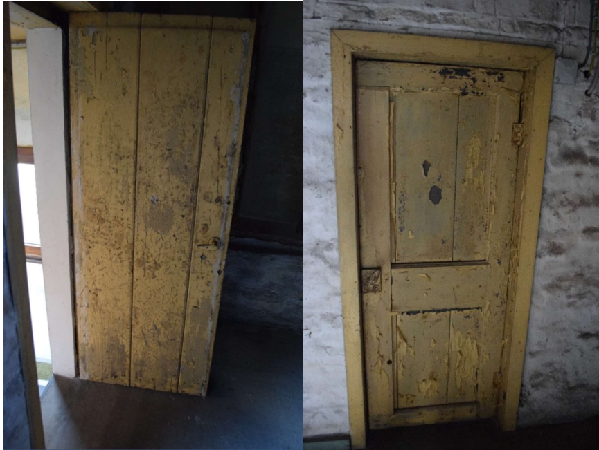
Afb. 221 Ruimte M5_R2.02: opgeklampte deur
