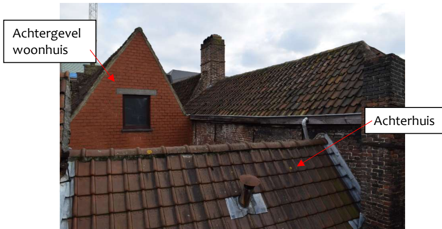
Afb. 82 Zicht op de het dak van de achterbouw en de achtergevel van de woning Molenaarstraat 3
