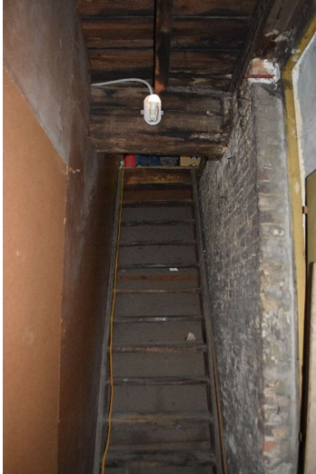
Afb. 525 M15f_R1.09: zicht op de balkenzoldering en steektrap
