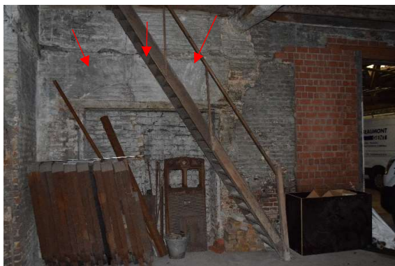
Afb. 660 M15h_R0.13: scheidingsmuur met 0.12 met dichtgemetselde doorgang
