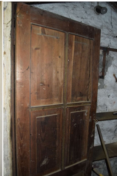
Afb. 569 M15h_R0.03: berging met houten deur bij de trap
