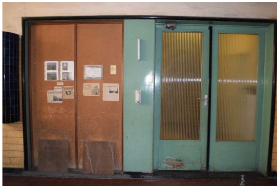
Afb. 382 Ruimte M15a_RO.01: zicht op de doorgangen naar 0.04 en 0.05
