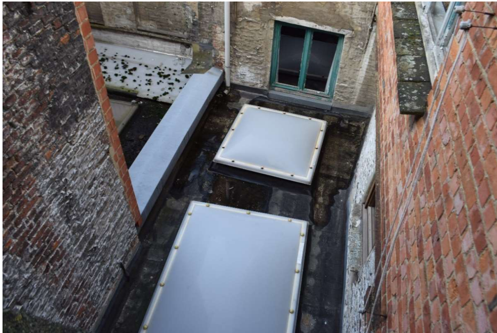
Afb. 152M5: zicht op de overdekte binnenkoer tussen het voor- en achterhuis
