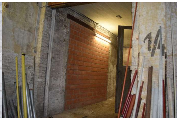
Afb. 504 M15e_R0.04: scheidingmuur met het pand 15f
