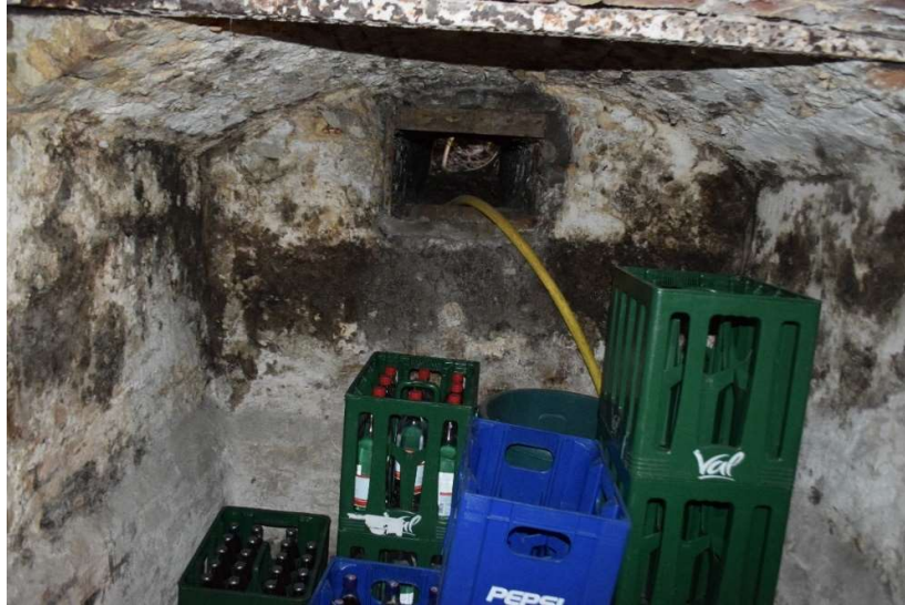
Afb. 86 Ruimte M3_R-1.01: algemeen zicht naar de straatzijde
