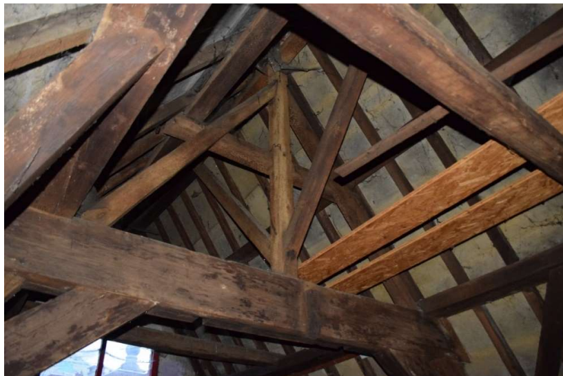
Afb. 131 Ruimte M3_R2.01: detail van de dakconstructie
