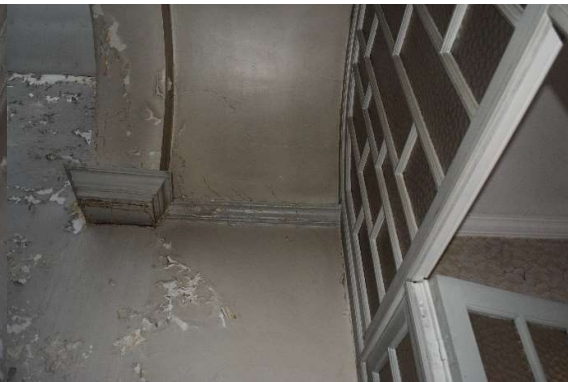
Afb. 467 Ruimte M15a_R1.07: detail van het plafond
