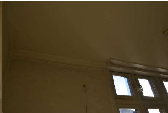
Afb. 49 Ruimte M1_R1.01: zicht op de strijk balk
