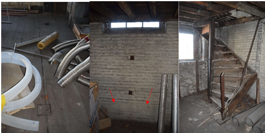
Afb. 603 M15h_R2.02: detail van de houten plankenvloer met sporen van een verdwenen constructie?
