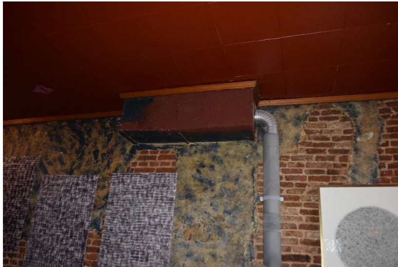
Afb. 91 Ruimte M3_R0.01: detail van de weggebroken schouw
