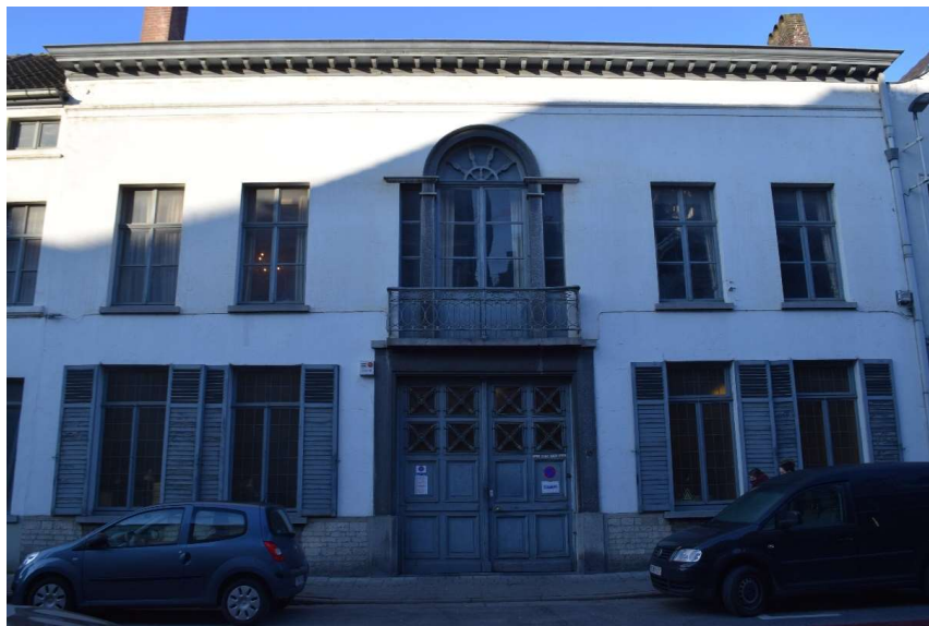
Afb. 363 M15: algemeen zicht op de voorgevel
