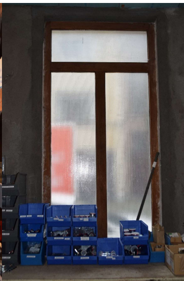
Afb. 286 Ruimte M15B_RO.01: houten raam uit ca. 1986
