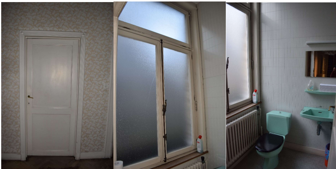
Afb. 457 Ruimte M15a_R1.05: houten toegangsdeur
