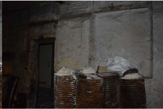
Afb. 506 M15e_R0.04: zicht op de oude achtergevel met dichtgemetselde vensteropening
