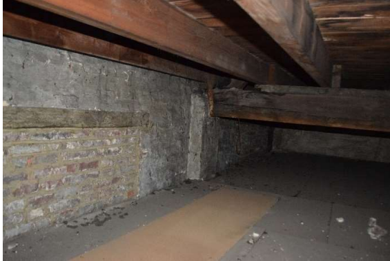
Afb. 554 M15g_R2b.01: zicht op de verlaagde vensteropeningen en vals plafond van de eerste verdieping
