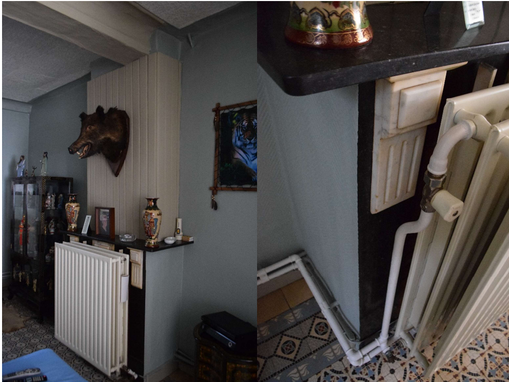
Afb. 169 Ruimte M5_R0.03: open haard met 20 ste - eeuwse mantel (vermoedelijk ca. 1932) en bekleding
