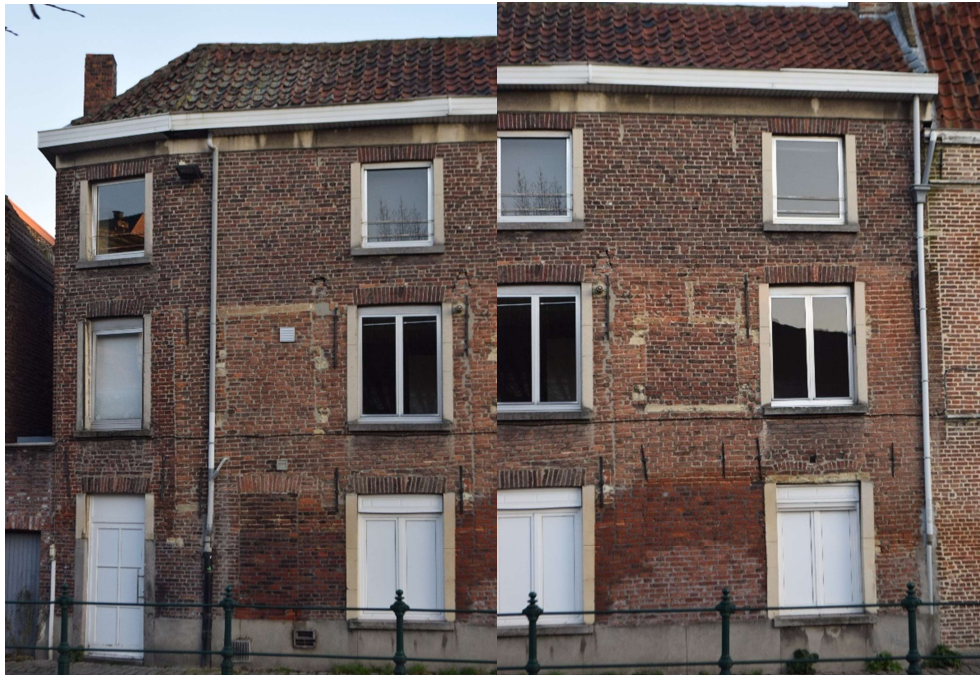
Afb. 10 M1: detail van de zijgevel aan de Sint-Antoniushaai
