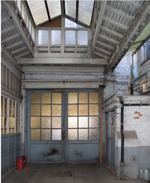
Afb. 371 M15: algemeen zicht op de achtergevel
