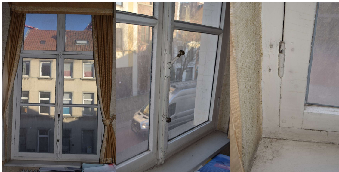
Afb. 448 Ruimte M15a_R1.03: houten raam uit 1828
