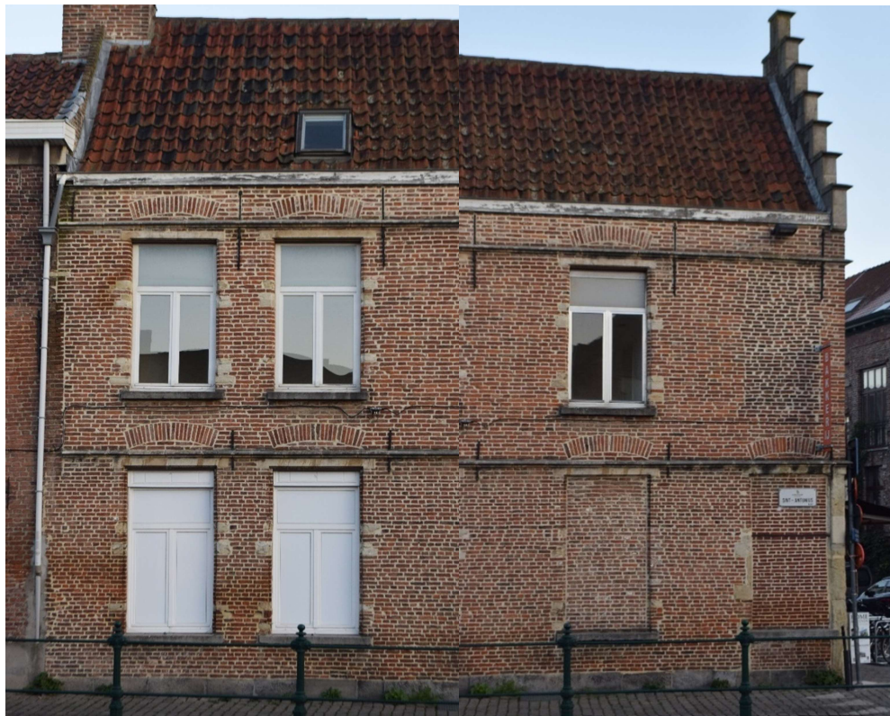
Afb. 7 M1: detail van de zijgevel 1
