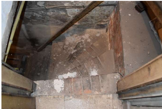
Afb. 376 Ruimte M15a_R-1.01: bakstenen toegangstrap
