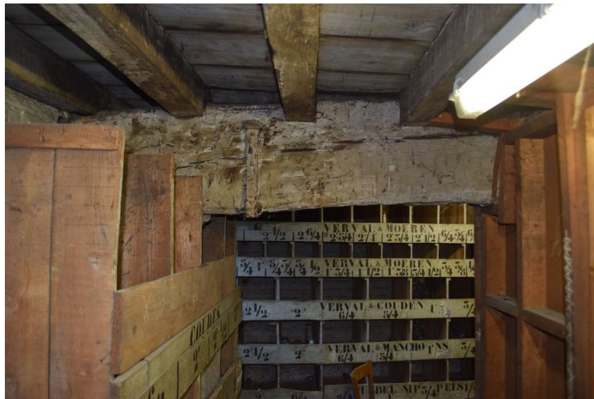
Afb. 579 M15h_R0b.01: detail van één van de moerbalken
