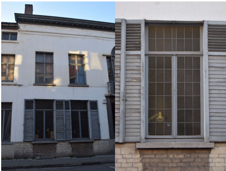
Afb. 367 M15: detail van de voorgevel
