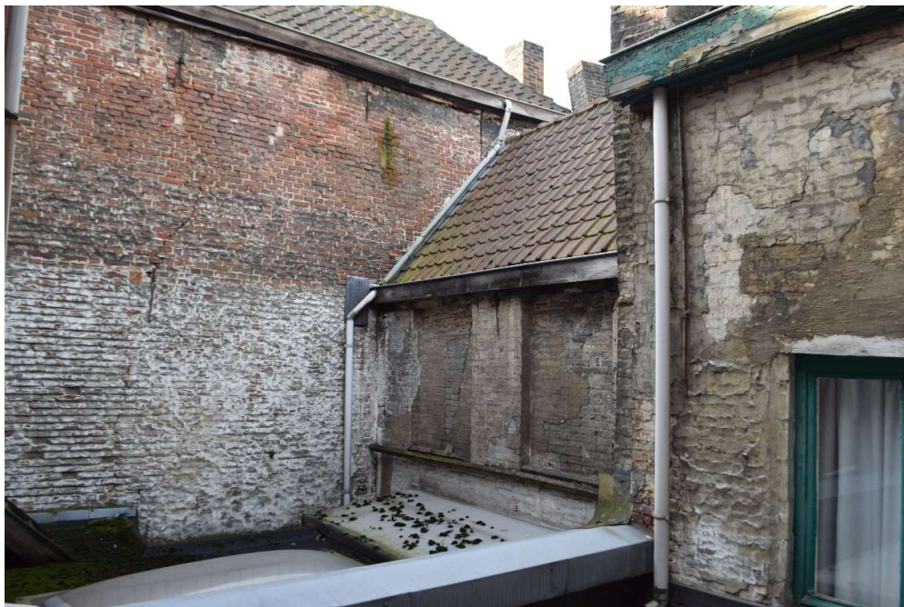
Afb. 13 M1: algemeen zicht op de achtergevel
