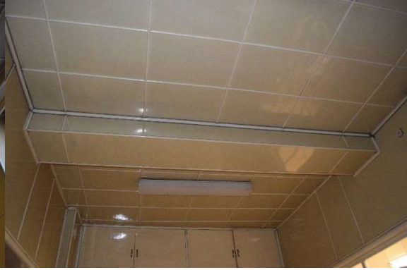
Afb. 393 Ruimte M15a_R0.03: zicht op de moerbalk of ligger
