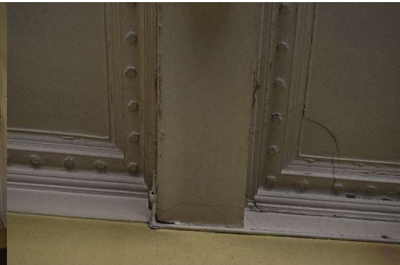
Afb. 402 Ruimte M15a_R0.04: detail van het stucwerkplafond
