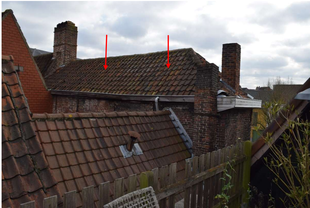
Afb. 12 M1: algemeen zicht op het dak en de achtergevel
