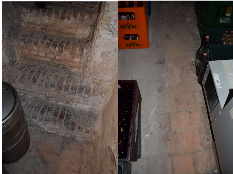
Afb. 84 Ruimte M3_R-1.01: bakstenen keldertrap
