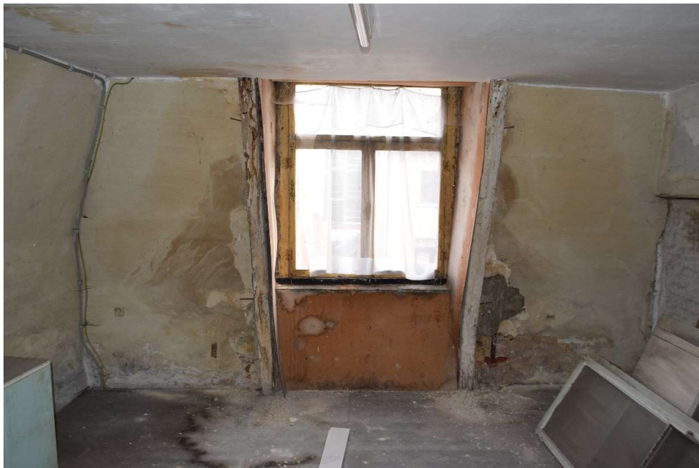
Afb. 211 Ruimte M5_R2.01: algemeen zicht naar de voorgevel
