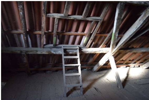
Afb. 623 M15h_R4.01: dichtgemaakt dakvlakvenster
