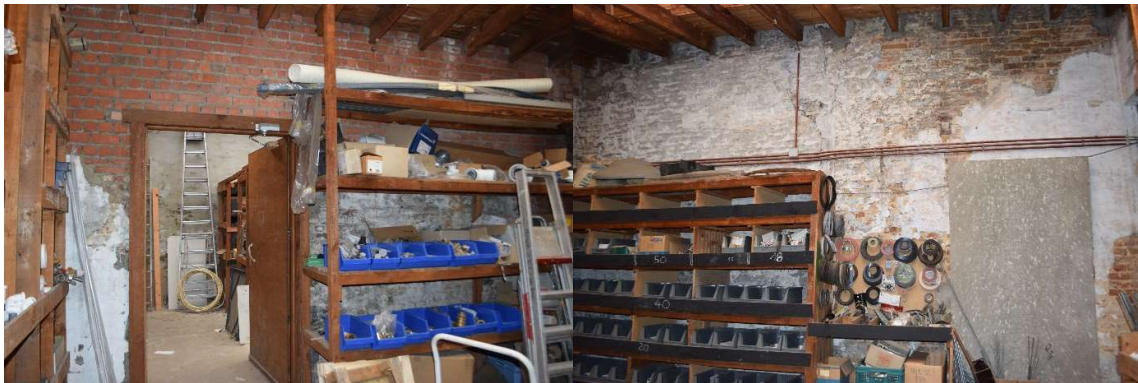
Afb. 302 Ruimte M15B_R0.04: scheidingsmuur tussen M15b en M15c
