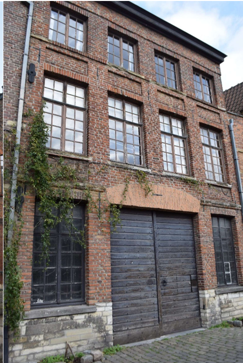
Afb. 517 M15f: algemeen zicht op de voorgevel
