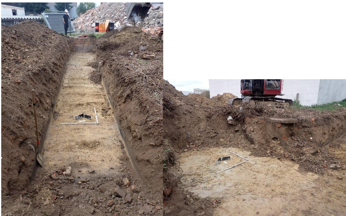
Figuur 11: Overzicht van werkput 6 (links) en kijkvenster van werkput 6 (rechts) (© J. Verrijckt Bv).
