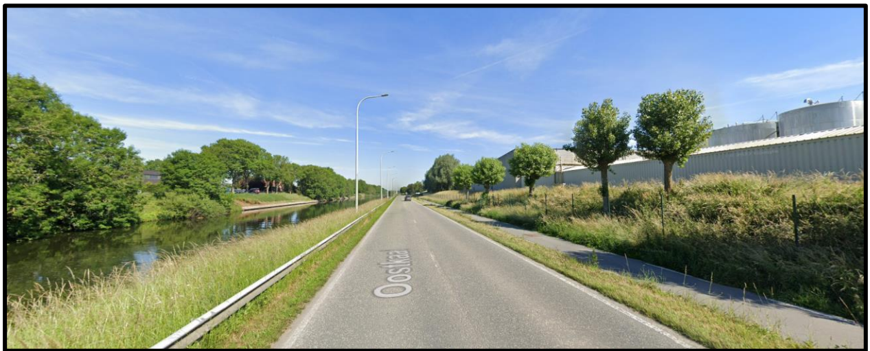
Figuur 4: Meest zuidelijke punt van het geplande tracé met links het kanaal Ieper-IJzer, rechts de berm en het fietspad waaronder de huidige riolering (en de geplande persleiding) zich situeert. (Google Streetview, 2023; opname dateert van juni 2022)
