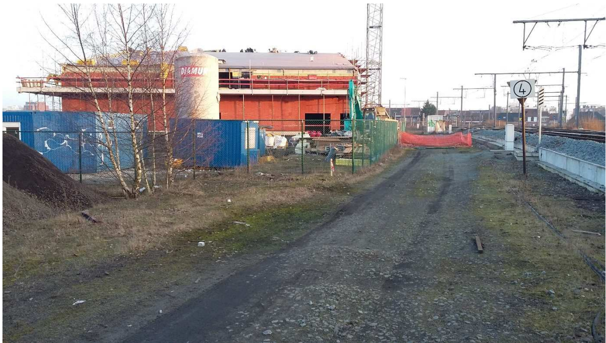
Figuur 7: Foto van de huidige situatie van het onderzoeksgebied in de omgeving van het zwembad met zicht op de noordwestelijke gevel van de fuifzaal (bron: Opdrachtgever 2017).
