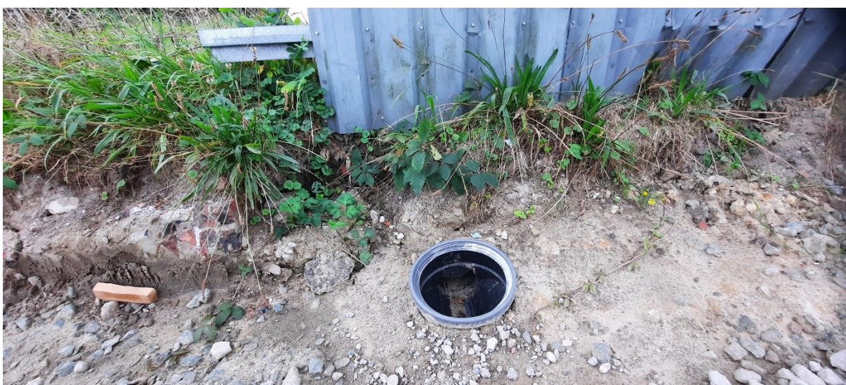
Figuur 11. Reeds aangelegde aansluitingen voor de riolering van het nieuwbouwproject (© Erfpunt).
