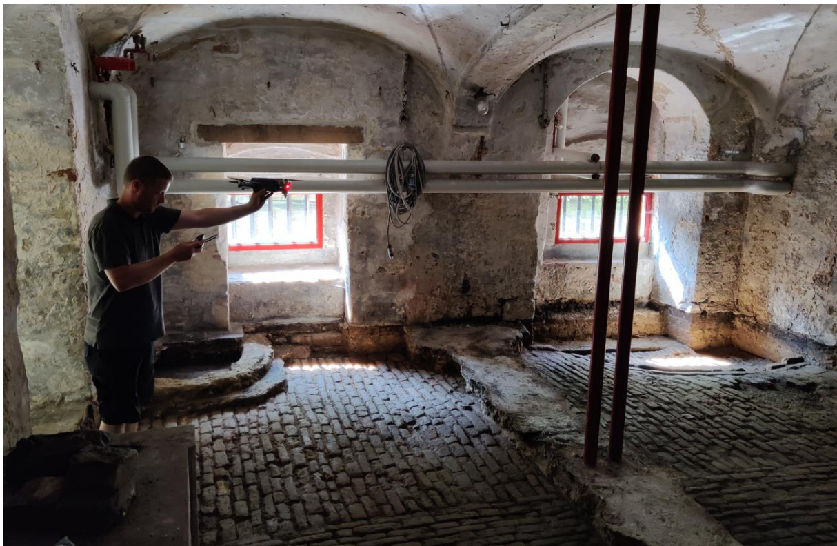
Figuur 34: Het oudere vloerniveau onder de kelder in de Kartuizerinnenstraat 4, foto bekomen via Raakvlak.
