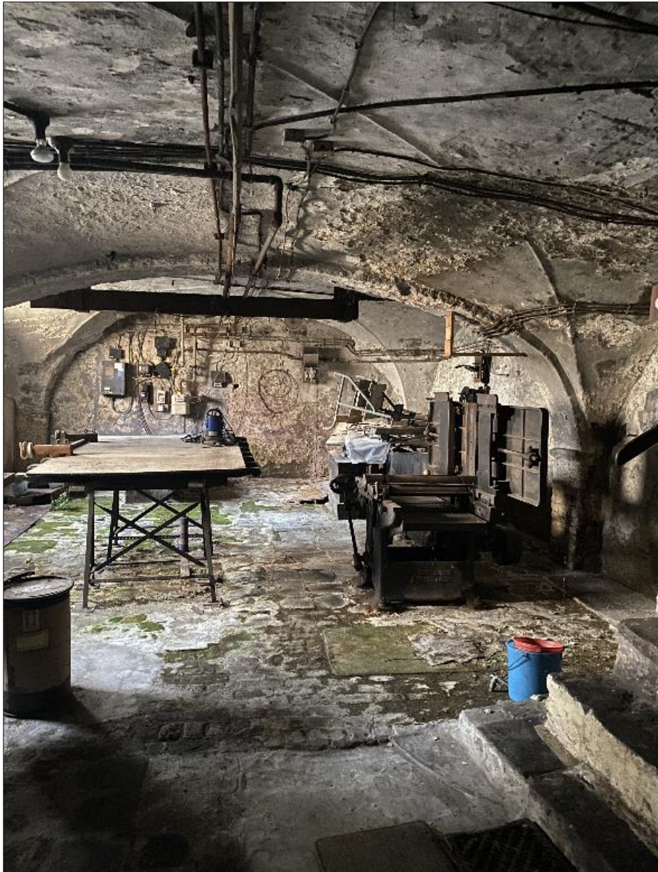
Figuur 21: Bestaande kelder.
