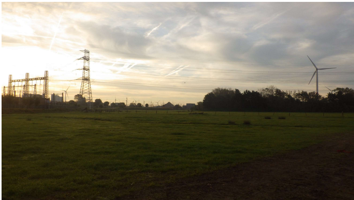
Fig. 2.7: Zicht op het oostelijke deel van het terrein met de aanwezigheid van de elektriciteitscentrale.
