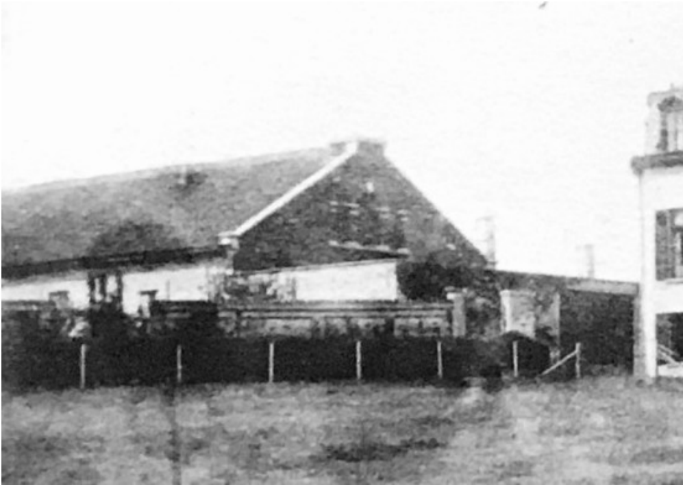
Fig. 2.7: Zicht op de tuitgevel langsschuur (©Collectie Heemkundige Kring Ascania).
