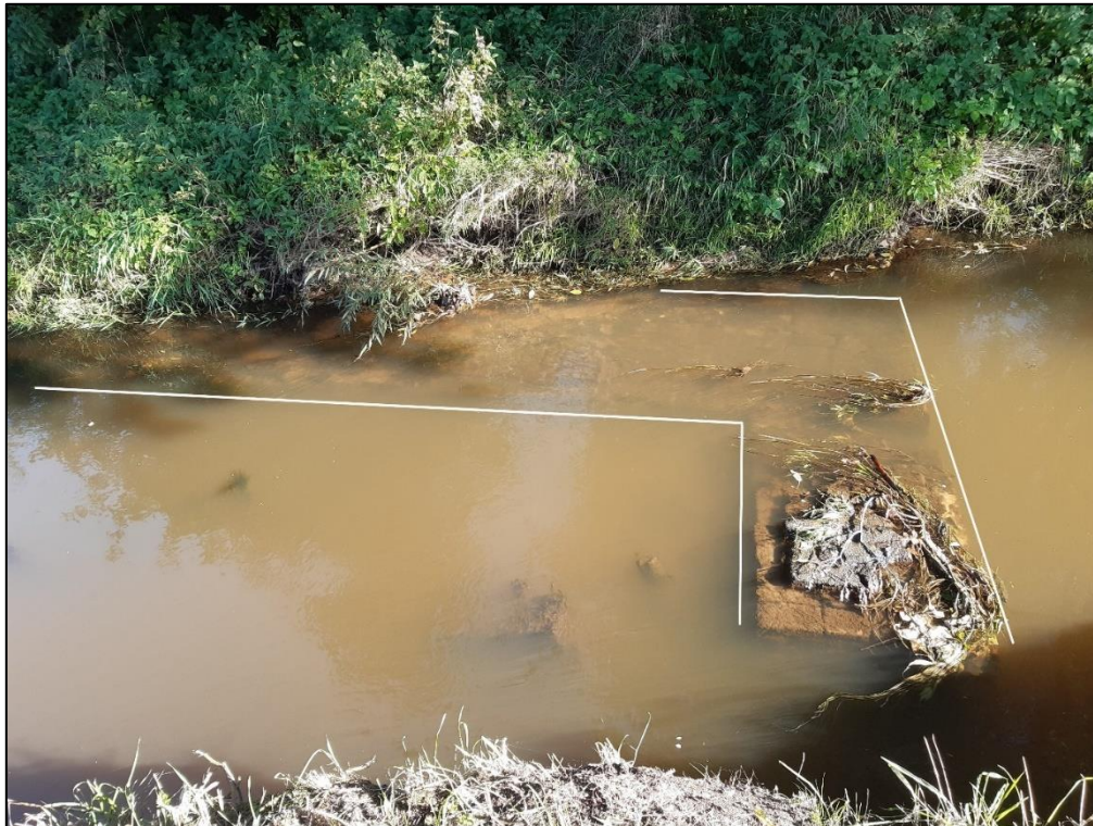
Figuur 8: Stevig muurwerk in de waterloop
