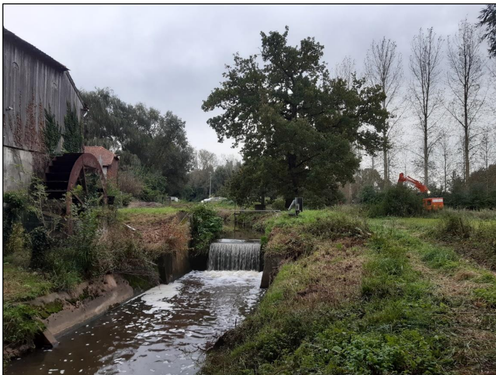
Figuur 5: Een verstevigde talud ter hoogte van de oever. Deze werd niet aangesneden door een proefsleuf.
