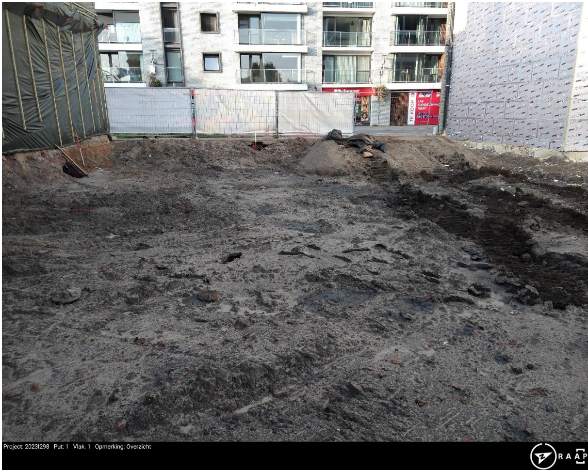
Figuur 4. Situatie binnen het onderzoeksgebied. Het niveauverschil ten opzichte van de straat is duidelijk zichtbaar. Er werd een talud aangelegd om het perceel te kunnen betreden en om de grond te stabiliseren.
