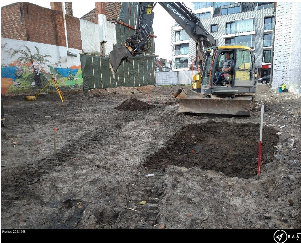
Figuur 13: Aanleggen van Proefput 1.
