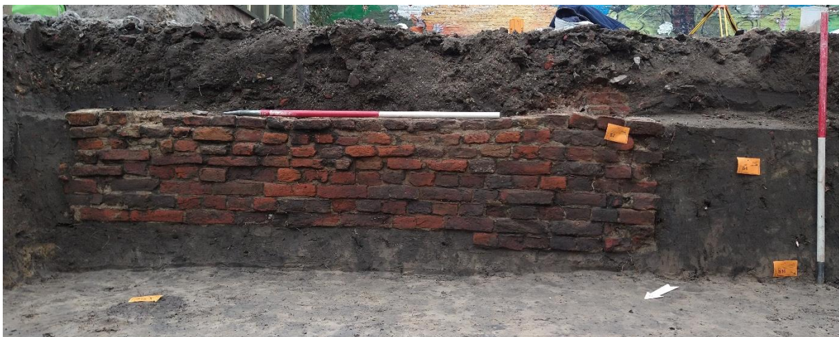
Figuur 15. Zicht op S2, de mogelijke kelder.
