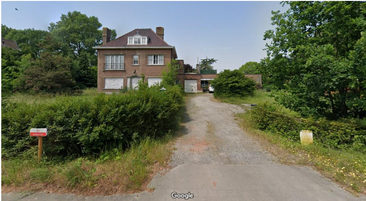
Figuur 1: Streetviewbeeld van de oprit en de centrale gebouwen in het plangebied vanaf de Gestichtstraat. 6
