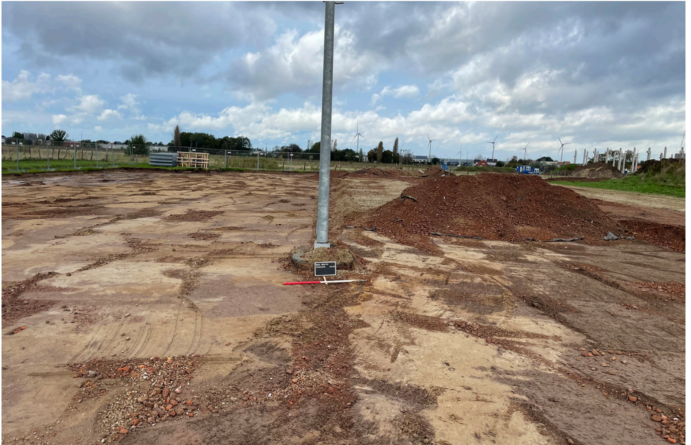
Figuur 5: De ontharde westelijke zone, de aanwezige nutsleidingen (verlichting) en de sloopwerken in het oosten
