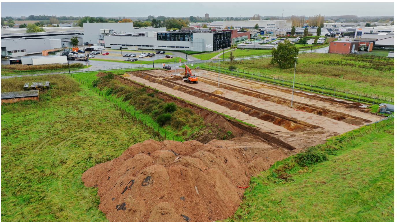
Figuur 14: Zicht op het uitgevoerde proefsleuvenonderzoek en het bestaande talud en grondopslag
