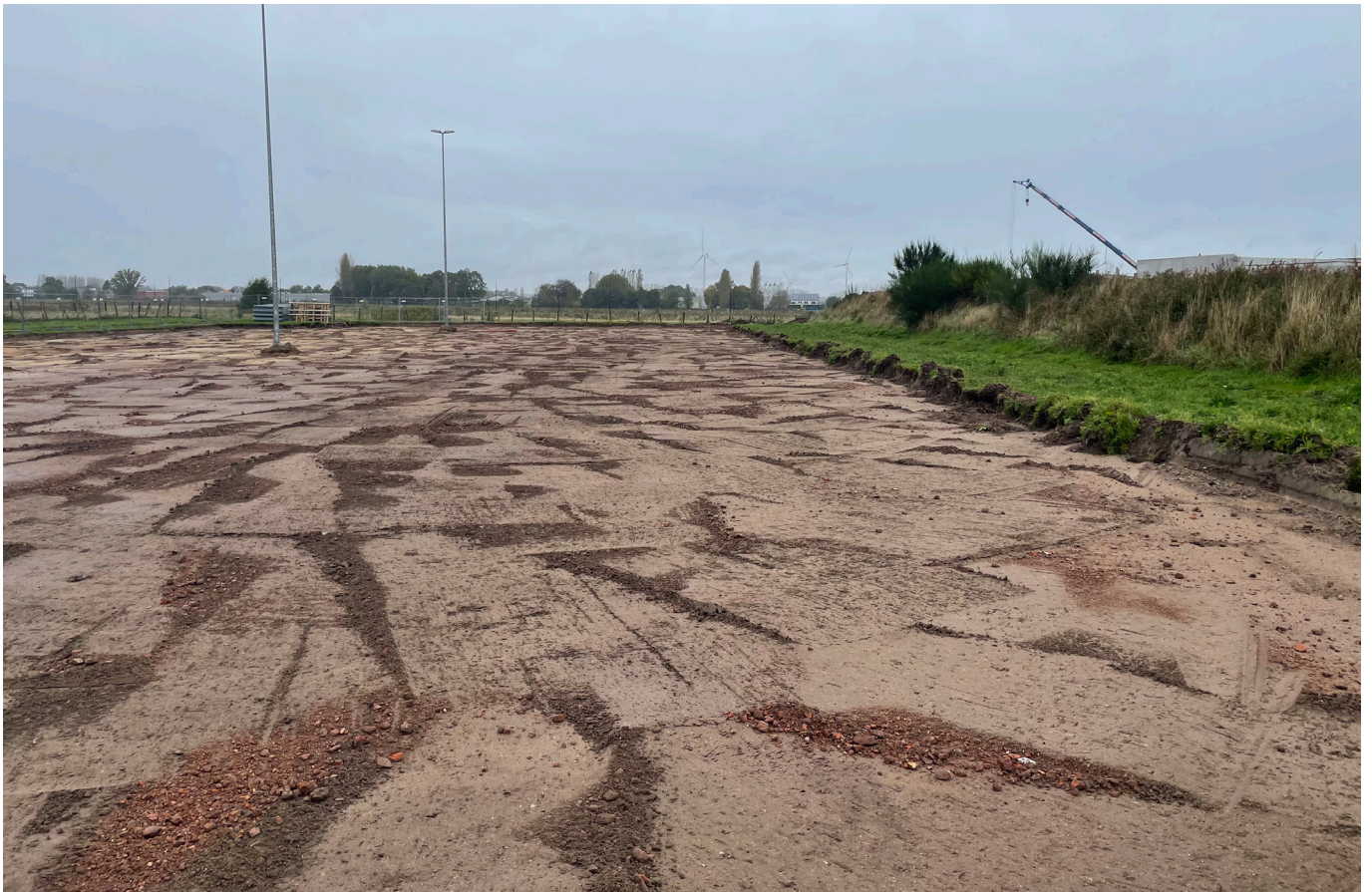
Figuur 6: De oostelijke zone na het verwijderen van de verharde parking, en zich op het bestaande talud
