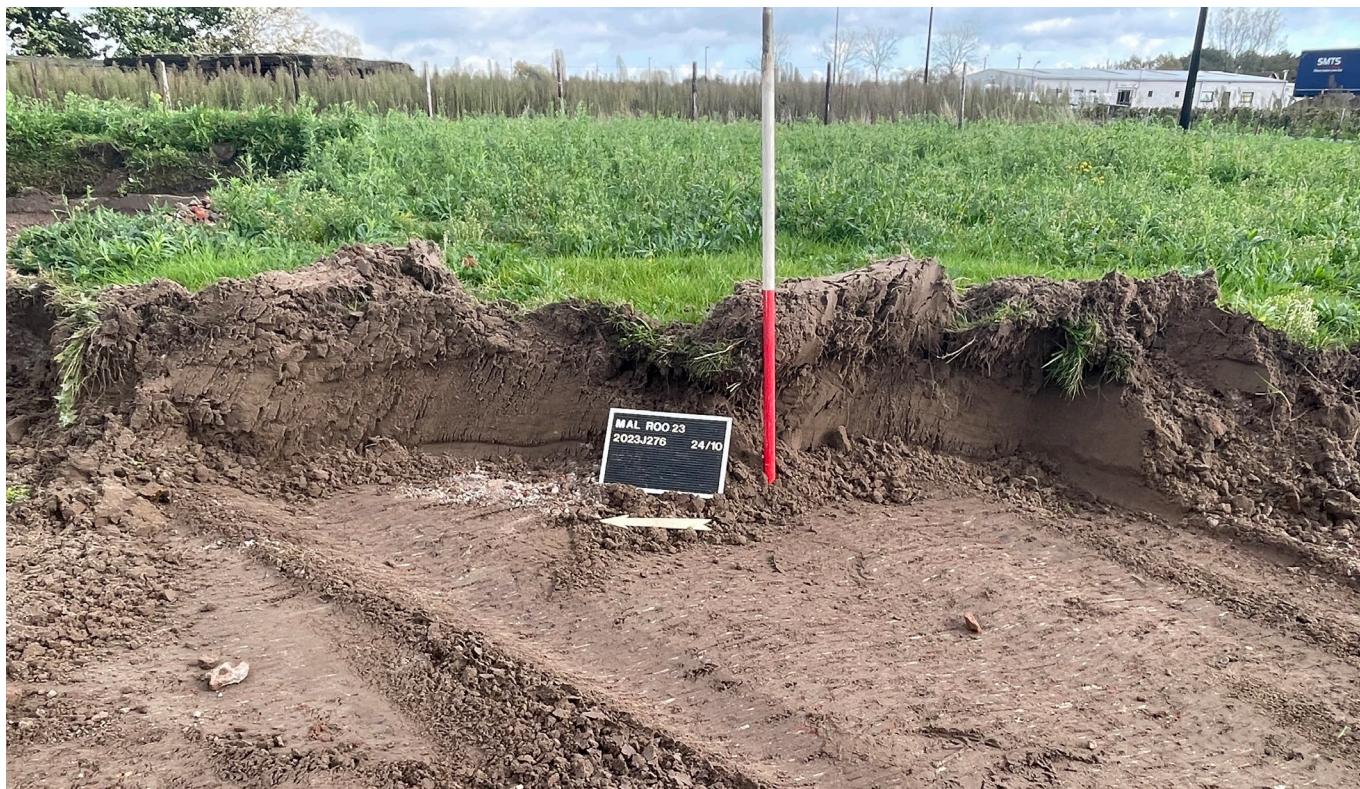
Figuur 7: Afgegraven diepte tegen de bestaande graszone en talud in het oosten
