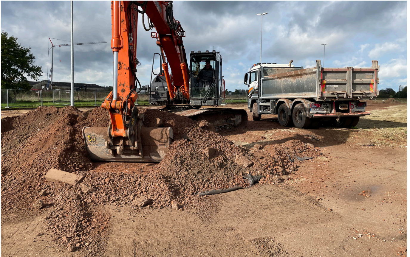
Figuur 3: Zicht op de sloopwerken tijdens het verwijderen van de verharde parkingpakket
