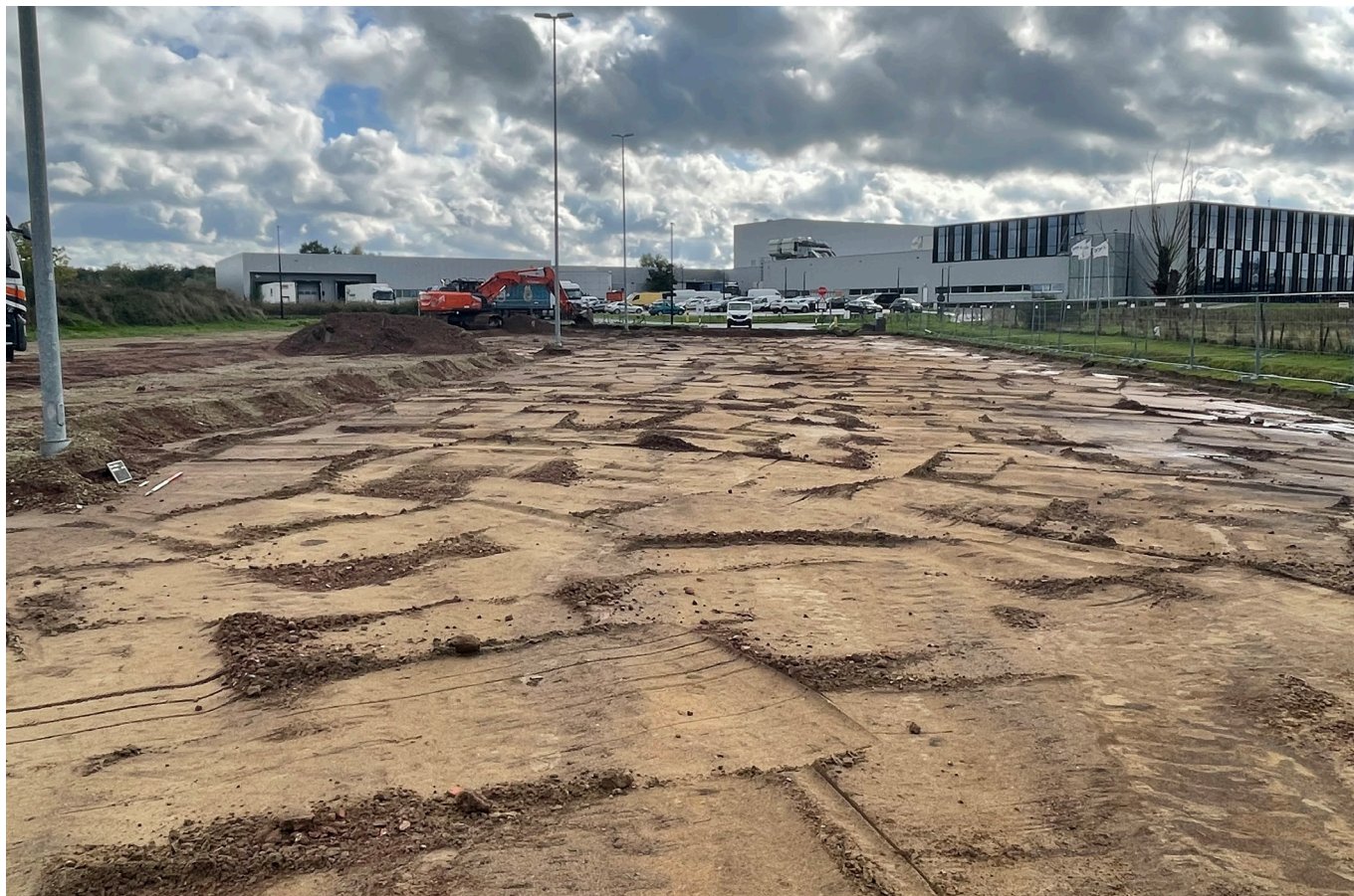
Figuur 8: Zicht op de ontharde oostelijke zone en de sloopwerken
