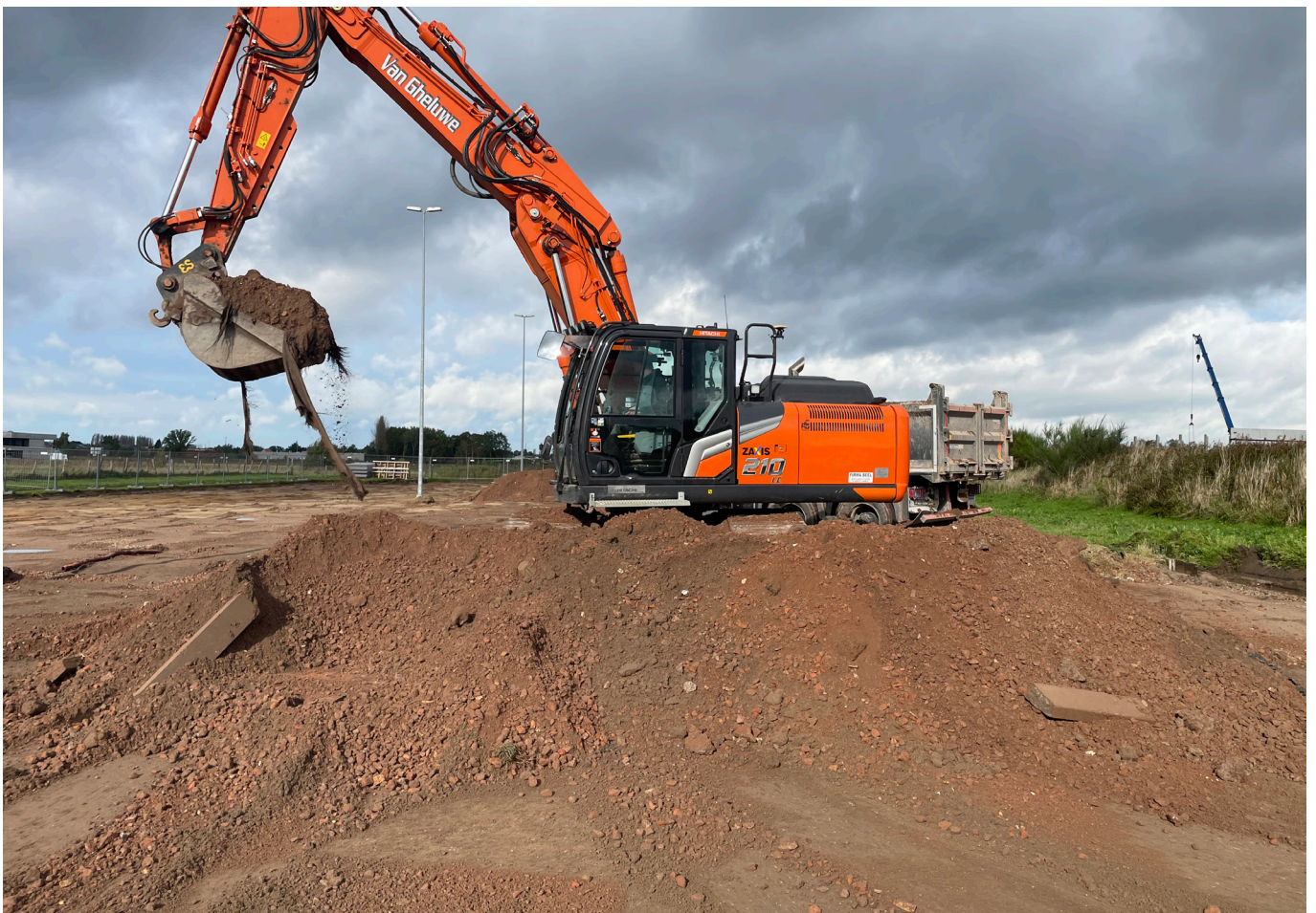
Figuur 4: Zicht op de sloopwerken. Het verharde grindpakket lag op een gronddeuk
