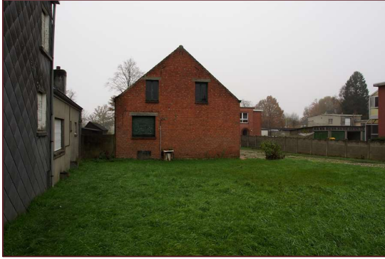
Foto 11: Voortuin langgevelhoeve nr. 56, N naar Z (bron: AIR)
