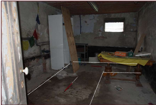
Foto 15: Westgevel langgevelhoeve nr. 56. Eerste stal ten Z woning. Vloer in baksteen, onderkelderd met beerput (bron: AIR)
