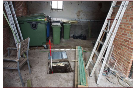
Foto 15: Westgevel langgevelhoeve nr. 56. Eerste stal ten Z woning. Vloer in baksteen, onderkelderd met beerput (bron: AIR)
