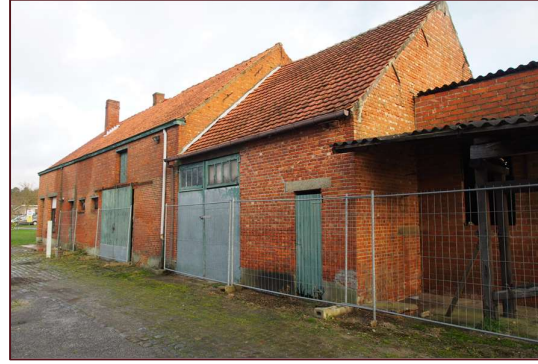
Foto 12: Westgevel langgevelhoeve nr. 56, Z naar N: met meerdere bouwfases (bron: AIR)
