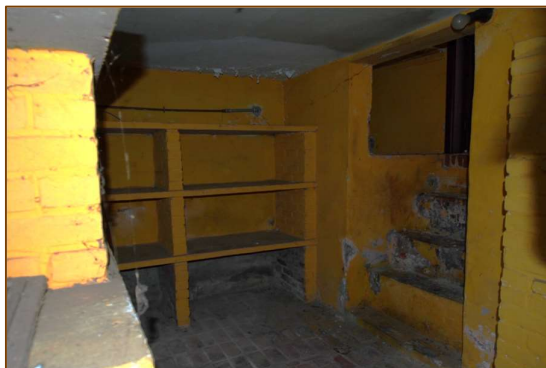
Foto 9: Nr. 58, kelder (bron: AIR)
