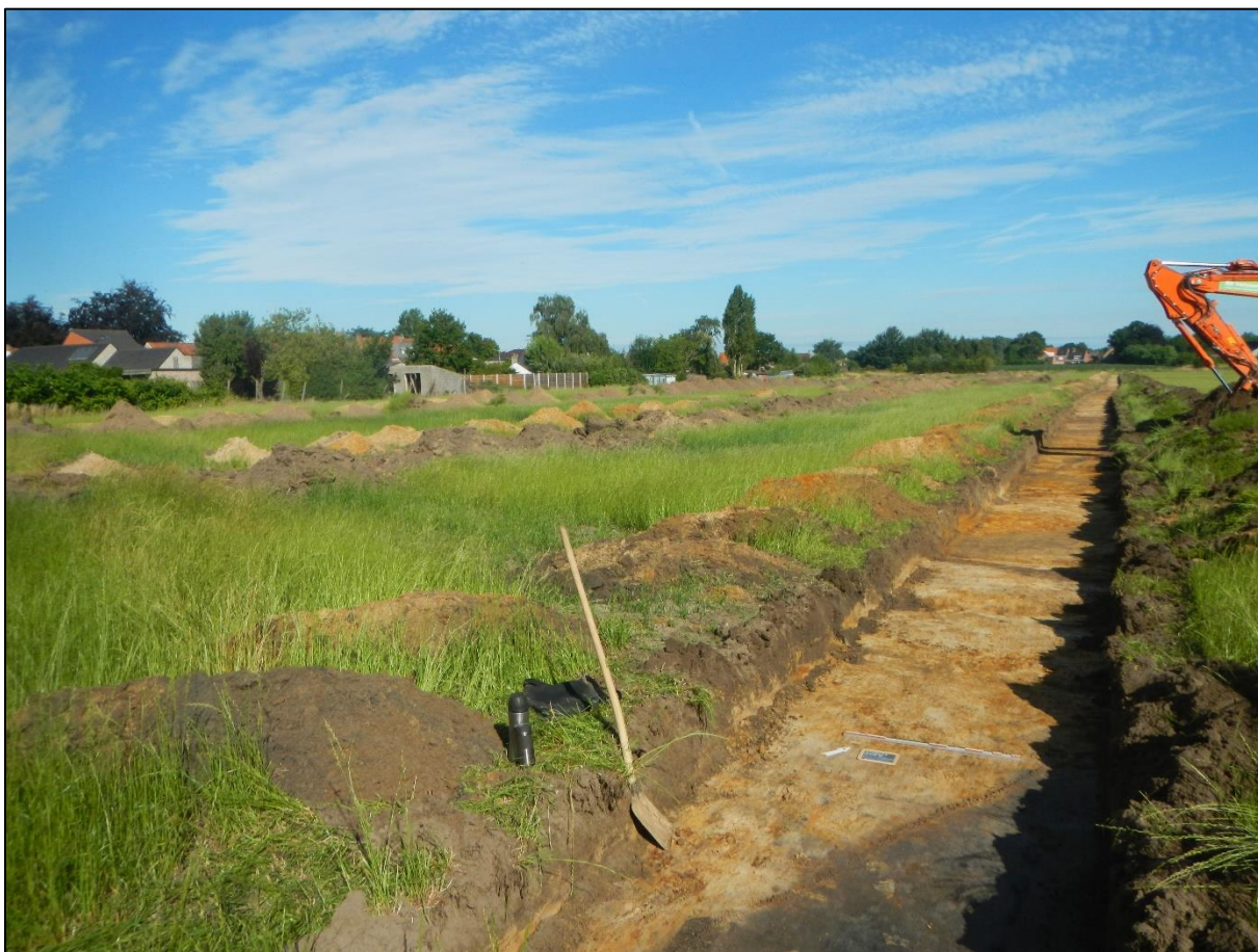
Figuur 12 Zicht op een deel van de aangelegde sleuven.
