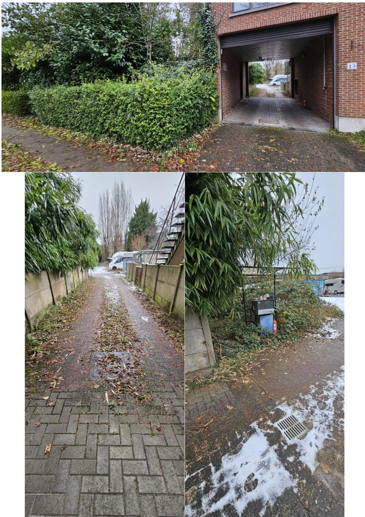
Figuur 6: Zicht op de doorgang met riolering en de oude bezinepomp ( © J. Verrijckt)
