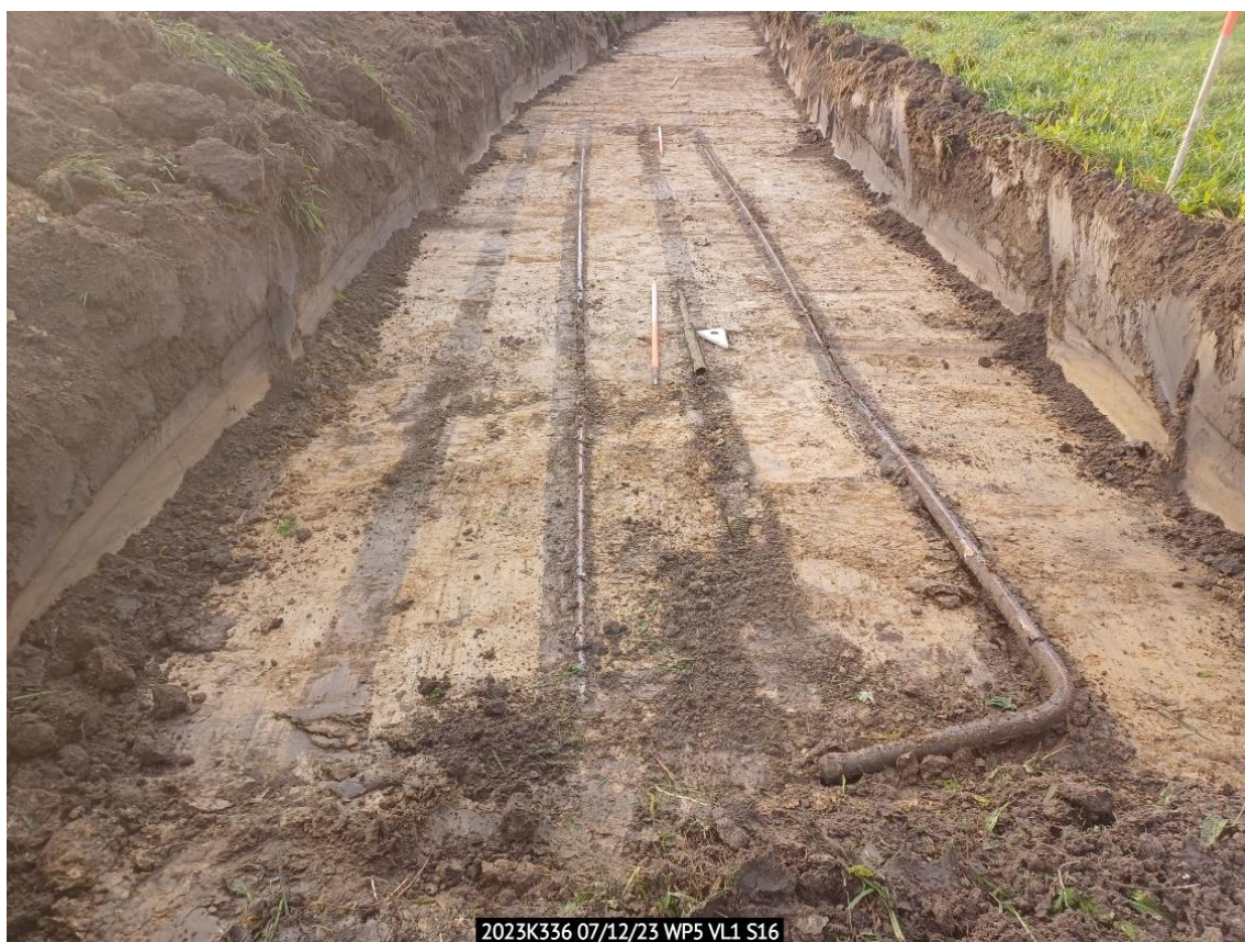
Figuur 28: Werkput 5, zone met waterleidingen S16
