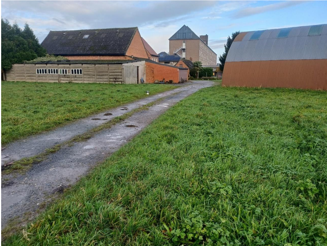
Figuur 13: Werkfoto met zicht op de oprit en verschillende gebouwen waaronder de loods
