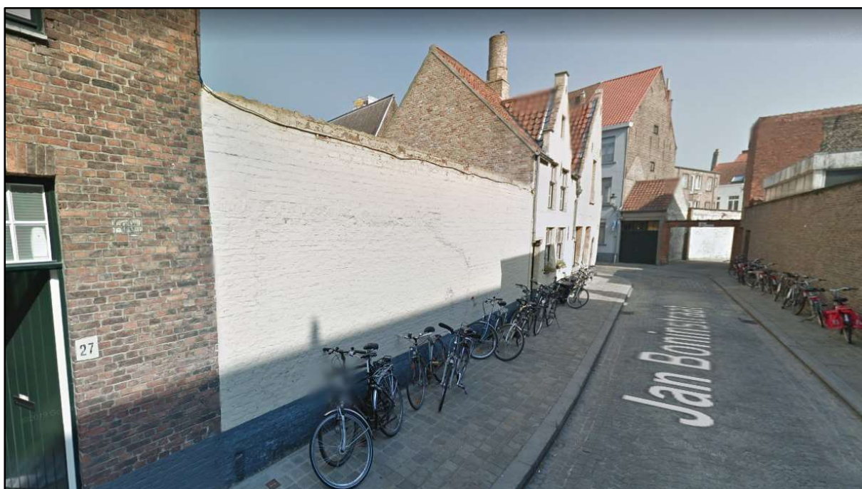
Figuur 4 Beeld vanuit het zuidwesten op de blinde muur grenzend aan de Jan Boninstraat (bron: https://www.google.com/maps ).
