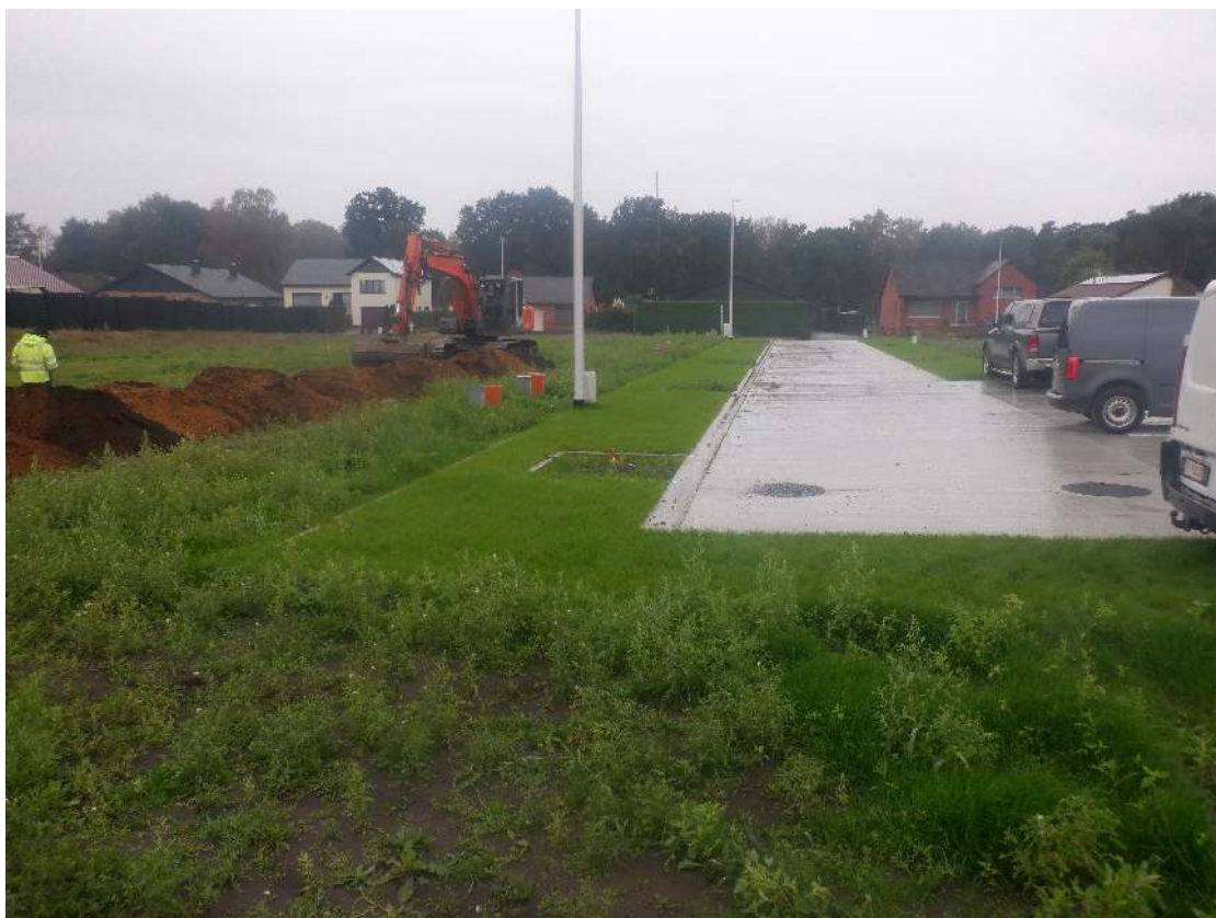
Afbeelding 3.5.2.1: Impressie van de nieuw aangelegde weg met links hiervan de huisaansluitingen. De foto is genomen tijdens de aanleg van werkput 4.
