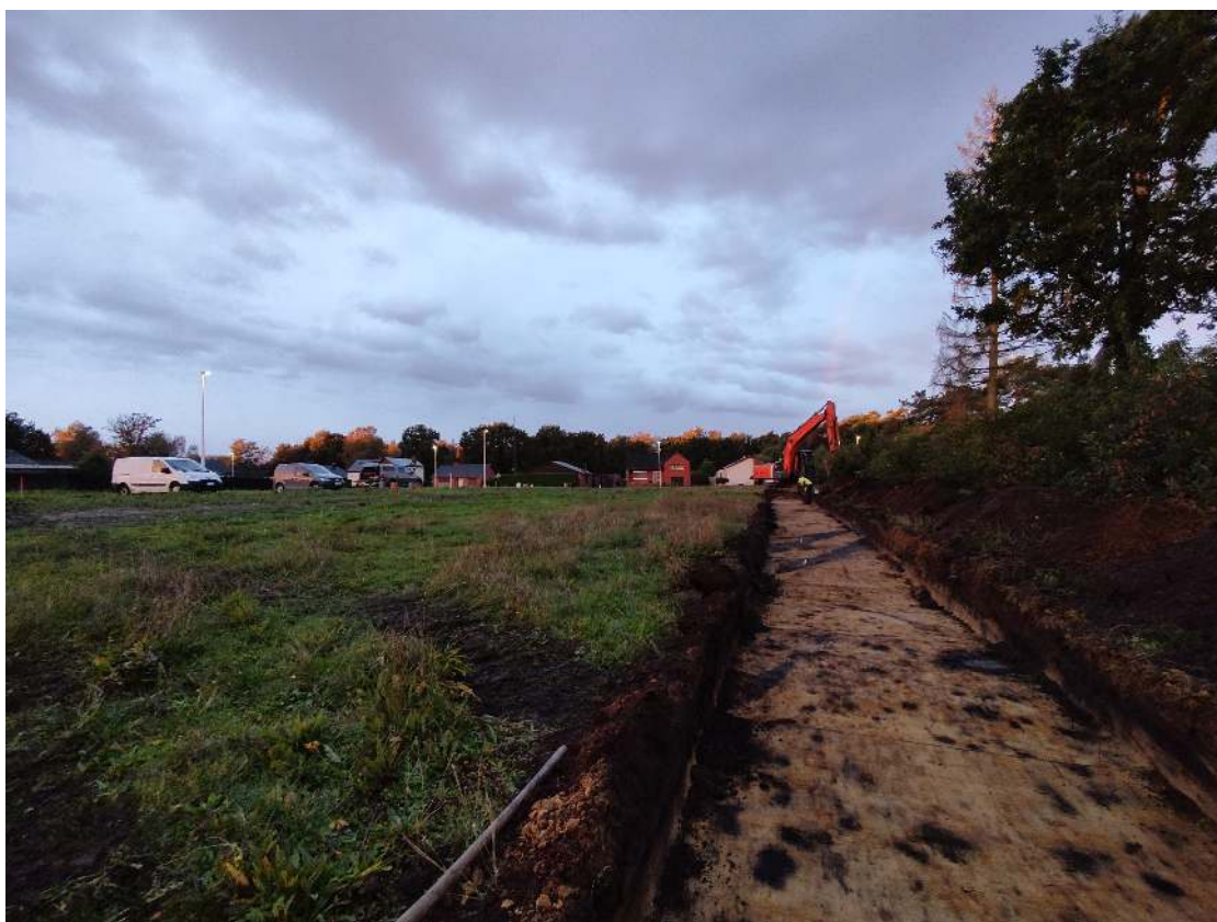
Afbeelding 3.5.2.2: Impressie tijdens de aanleg van werkput 1
