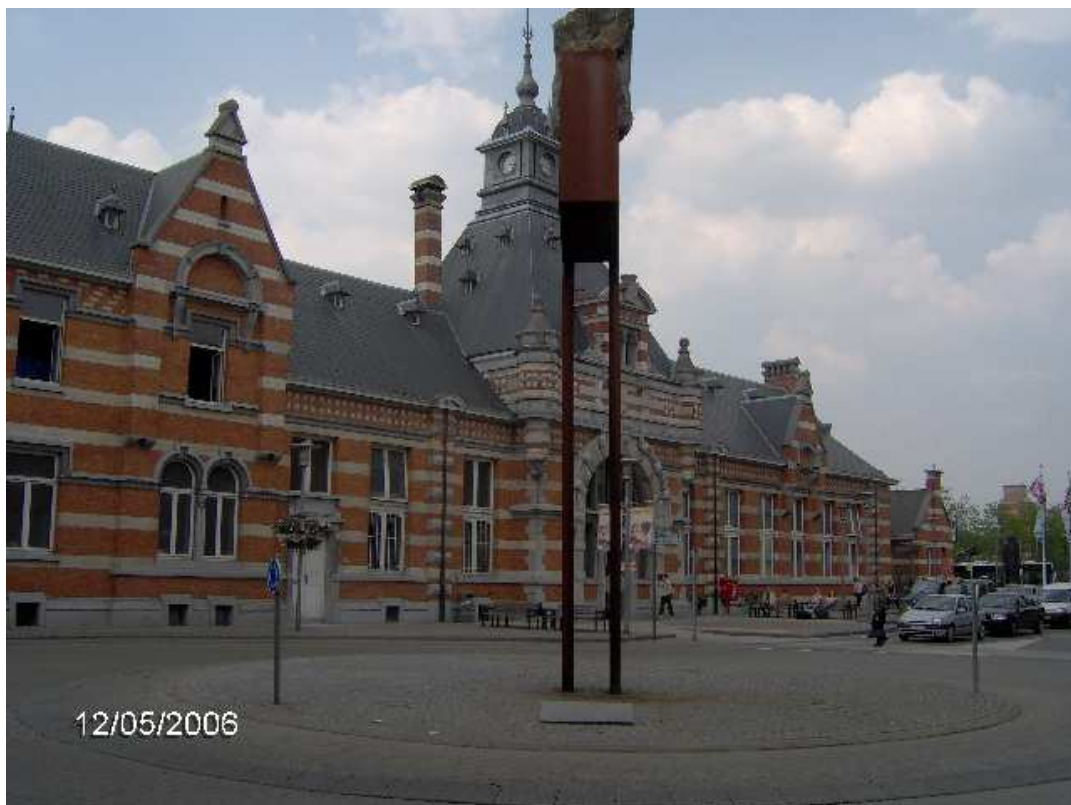
Figuur 49: Stationsgebouw Turnhout (Bron: Inventaris Onroerend Erfgoed 2017: ID12265).
