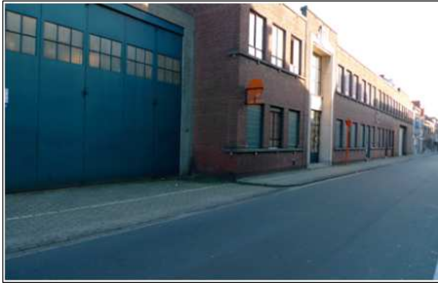
Figuur 10: Zicht op de westgevel van de bewaarde bebouwing langs de Bareelstraat (bron: Opdrachtgever 2017).
