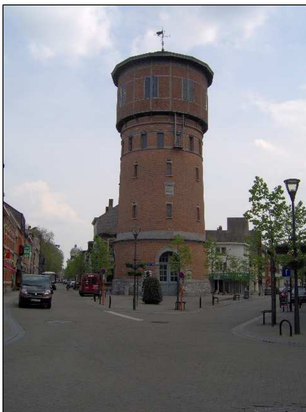
Figuur 51: Watertoren langs de Warandestraat (Bron: Inventaris Onroerend Erfgoed 2017: ID12336).
