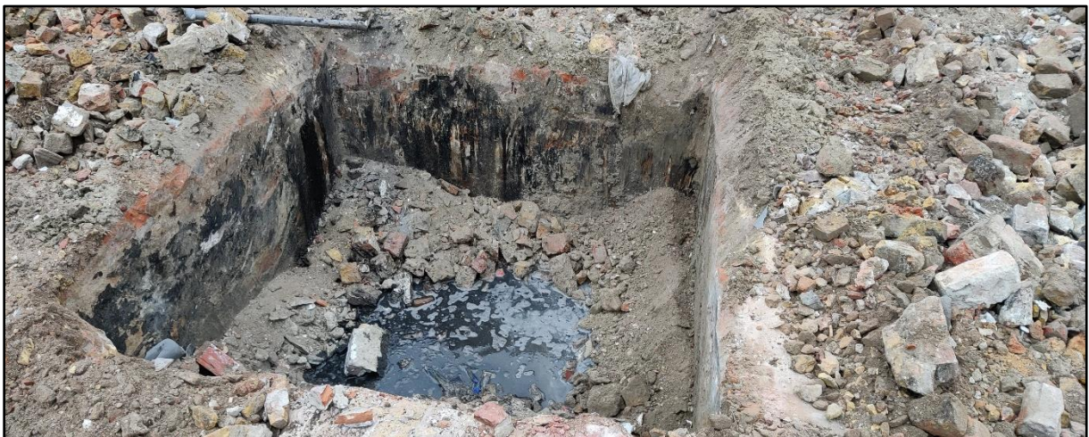
Figuur 9: Algemeen zicht op werkput 3 (ABO nv 2023).
