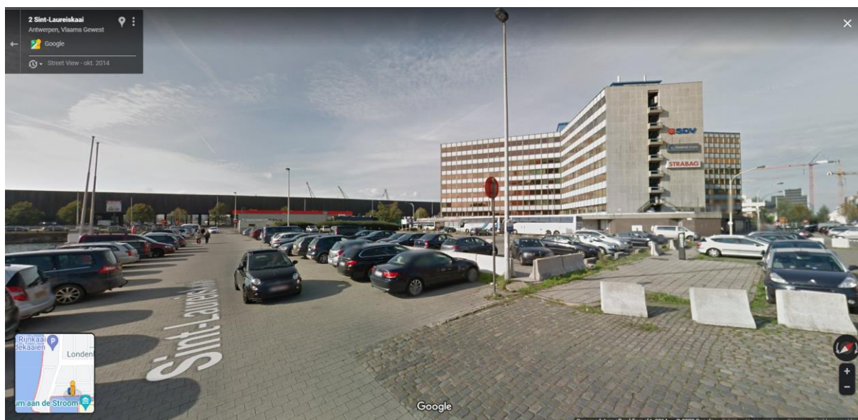
Figuur 5: Zicht op parking, okt. 2014 (© Google Street View)
