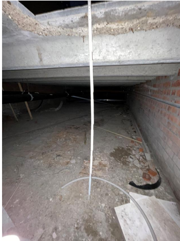
Figuur 14: Kruipkelder van het gebouw langs de Kardinaal Mercierlaan. 12
