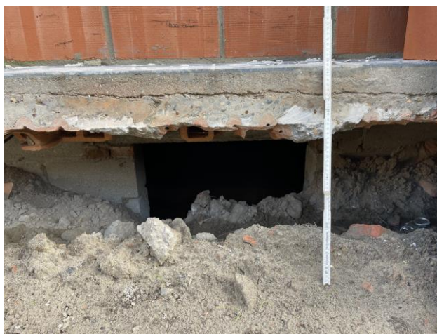
Figuur 13: Zicht op kruipkelder van het gebouw langsheen de Kardinaal Mercierlaan. 11
