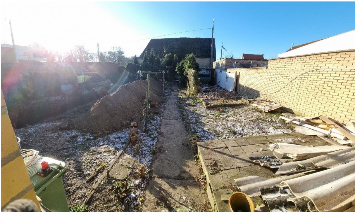
Fig. 22: Het terrein gefotografeerd vanuit het noorden van de projectzone na aanleg van proefsleuf 1
