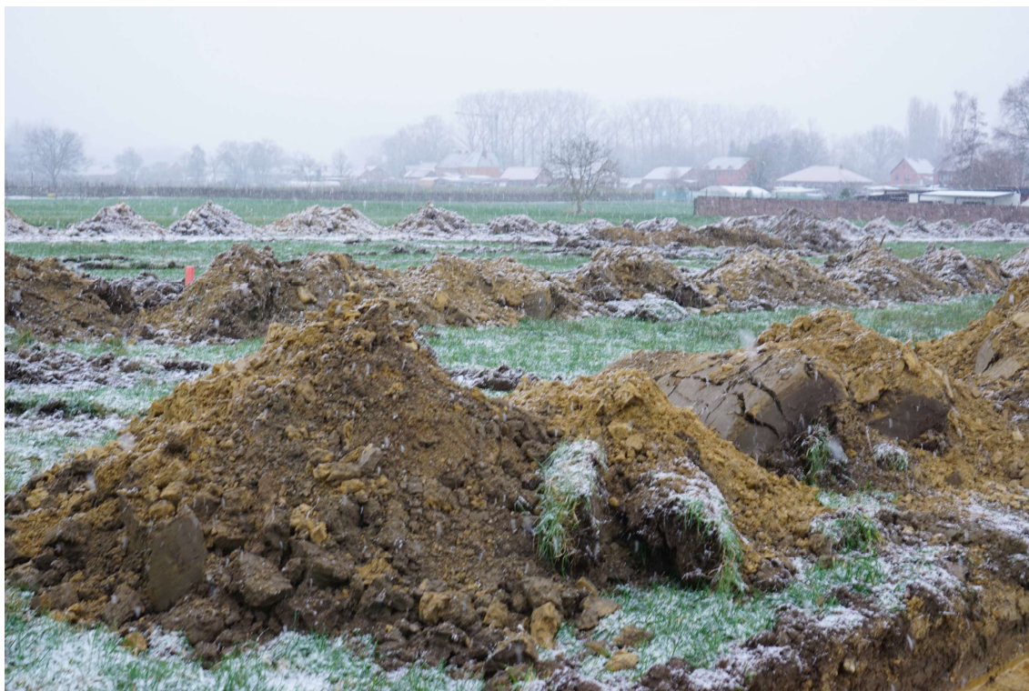
Fig. 3.6: Zicht op het terrein in de noordelijke zone.
