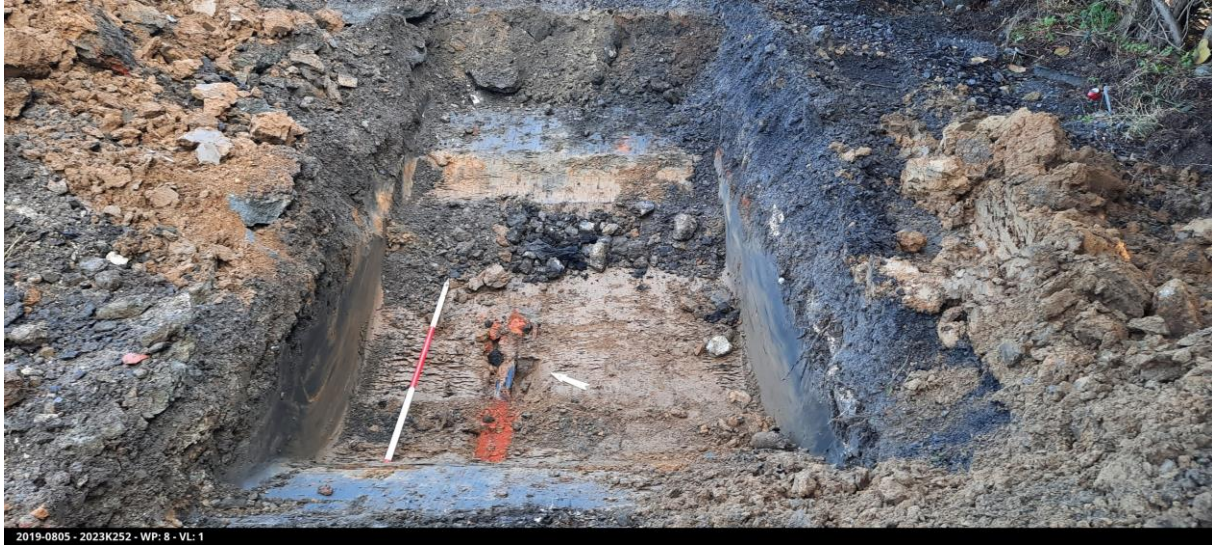
Figuur 35: Leiding ter hoogte van werkput 8
