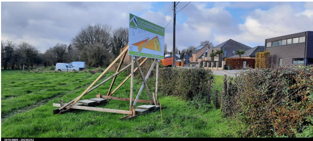
Figuur 33: Obstacle ter hoogte van werkput 6
