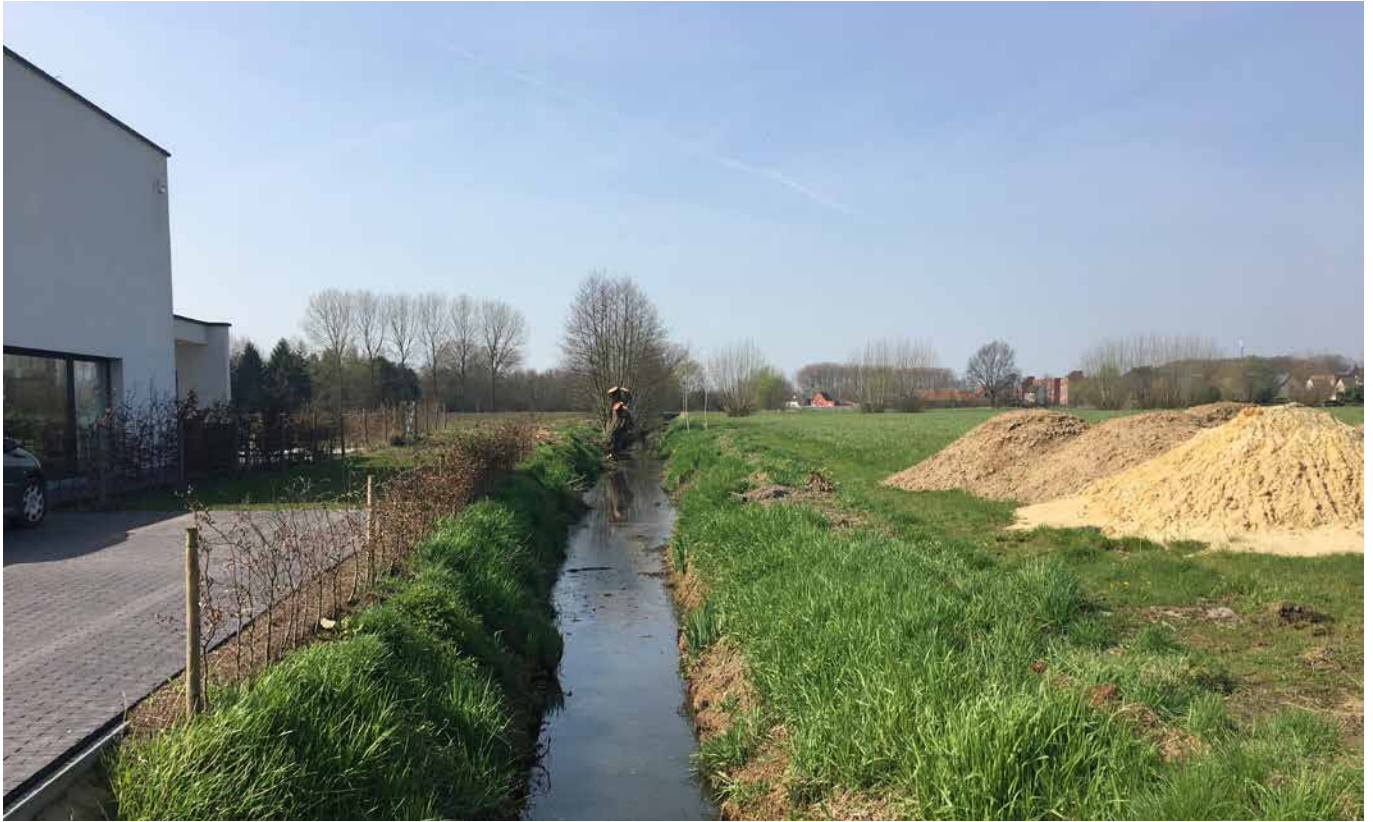
Figuur 13: Foto 1 met zicht op de Stevensbeek
