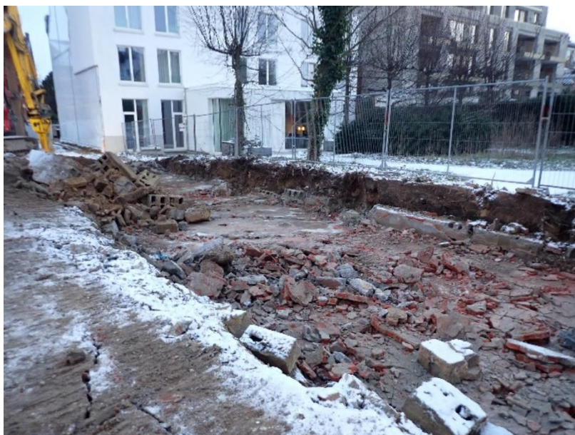
Figuur 20: Zicht op één van de uitgebroken kelders aan de oostelijke zijde van het plangebied © J. Verrijckt Bv
