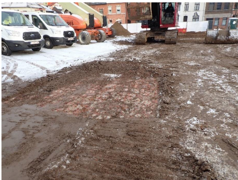
Figuur 21: Zicht op het maaiveld ter hoogte van werkput 1. De aanwezige verharding van de toenmalige speelplaats is nog duidelijk zichtbaar © J. Verrijckt Bv
