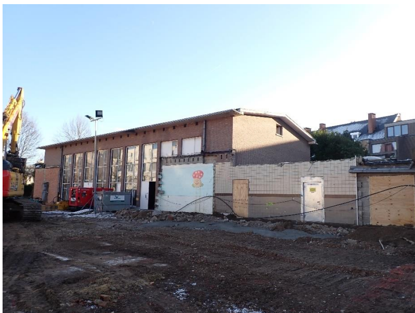
Figuur 22: Zicht op de te behouden bebouwing binnen het zuidelijke deel van het plangebied © J. Verrijckt Bv
