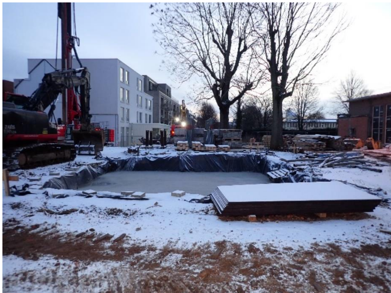
Figuur 18: Zicht op reeds gestorte betonfundering t.b.v. de torenkraan met achterliggend de twee te behouden bomen. ◉
